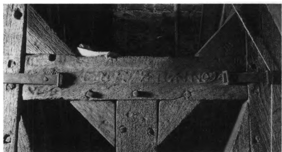
Fig. 40. Detalje af klokkestol med årstal 16?? (s. 2505). NE fot. 1980. - Detail of the bell frame's beam with carved date 16??.
