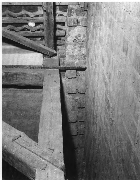
Fig.64-65. 64. Søndre fortanding på østsiden af skibets østgavl (s. 2566). 65. Luge i skibets østgavl set fra korets loftsrum (s. 2569). Mogens Vedsø fot. 1989. - 64. Toothings to the south on the east face of the nave's east gable. 65. Hatch in the east gable of the nave seen from the loft above the chancel.
