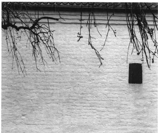
Fig.44. Skibets nordside med rester af \dagger sakristi? (s. 2677). NE fot. 1990. - North wall of the nave with traces of \dagger sacristy?
