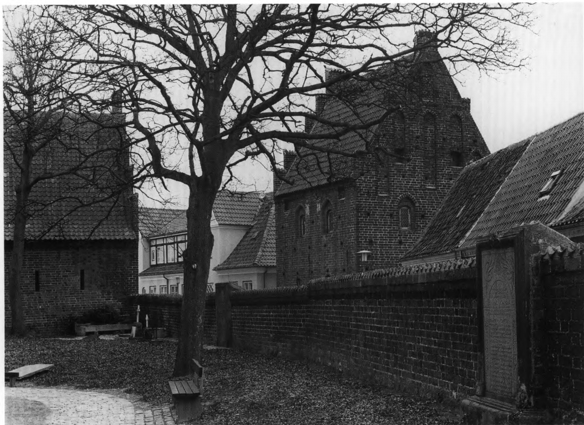
Fig. 6. Indersiden af kirkegårdsmurens sydøstre del, jfr. fig. 11 (s. 3029). I baggrunden til venstre ses kirkeladen, til højre stenhuset (1480'erne) i Præstegade (s. 3034, 3024). NE fot. 1982. - Inner face of the south-east part of the churchyard wall, cf. fig. 11. In the background on the left the tithe barn, on the right the brick-built house (1480s) in Præstegade.
