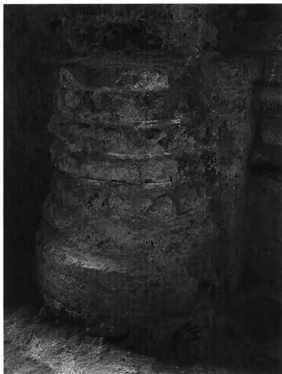
Fig. 92-93. Halvøjlebaser ved nordre og søndre korsarmsarkade efter fjernelse af sekundære pudslag 1917-21. 92. Base ved nordre arkade, jfr. fig. 90 (s. 3093). 93. Base ved søndre arkade, jfr. fig. 91 (s. 3090). Mogens Clemmensen fot. - Bases of engaged columns of the north and south transept's arcades after the removal of secondary plaster 1917-21. 92. Base of the arcade to the north, cf. fig. 90. 93. Base of the arcade to the south, cf. fig. 91.
