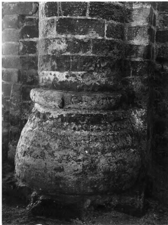
Fig. 92-93. Halvøjlebaser ved nordre og søndre korsarmsarkade efter fjernelse af sekundære pudslag 1917-21. 92. Base ved nordre arkade, jfr. fig. 90 (s. 3093). 93. Base ved søndre arkade, jfr. fig. 91 (s. 3090). Mogens Clemmensen fot. - Bases of engaged columns of the north and south transept's arcades after the removal of secondary plaster 1917-21. 92. Base of the arcade to the north, cf. fig. 90. 93. Base of the arcade to the south, cf. fig. 91.
