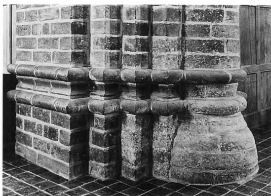
Fig. 90-91. Rekonstruerede sokler med halvøjlebaser på nordre og søndre korsarmsarkade, jfr. fig. 51-52. 90. Nordre arkades vestre sokkel (s. 3093). 91. Søndre arkades vestre sokkel (s. 3090). Ad. Jeppesen, Kalundborg, fot. 1922. - Reconstructed plinths of the north and south transept's arcades with bases of engaged columns, cf. figs. 51-52. 90. West plinth of the arcade to the north. 91. West plinth of the arcade to the south.
