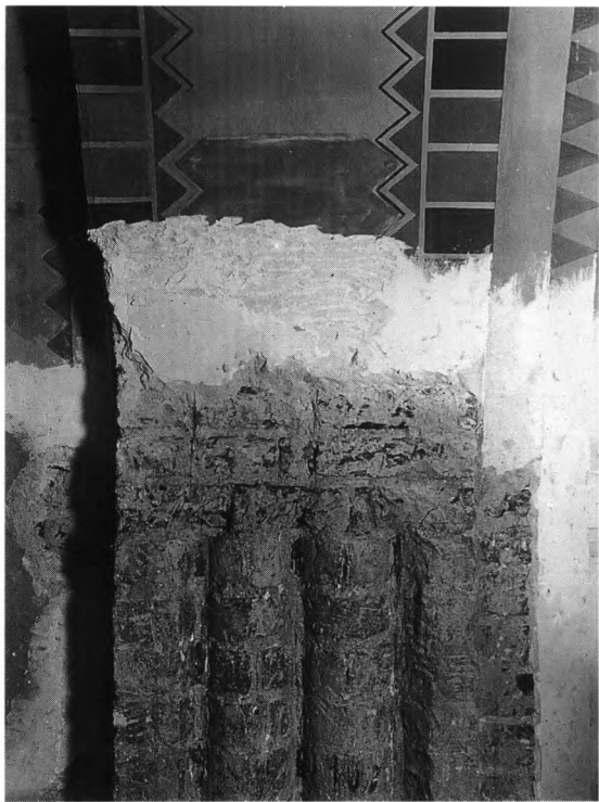
Fig. 124. Afdækning af forsænkede rundstave i søndre vange af østre korsarmsarkade (s. 3090, 3130). Mouritz Mackeprang fot. 1906. - Uncovering recessed roll moulding in the south jamb of the east transept's arcade.
