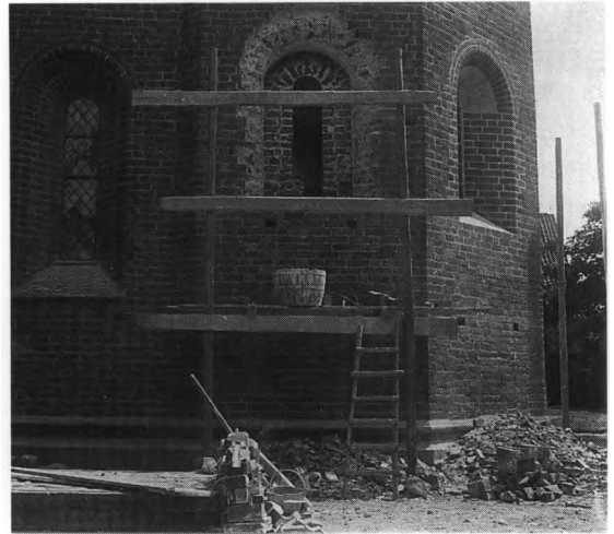
Fig. 75. Genskabelse af vinduer på søndre korsarms vestside 1917-21. Til venstre vindue fra restaureringen 1867-71 (s. 3128). - Reconstruction of windows in the west wall of the south transept, 1917-21. On the left a window from the restoration of 1867-71.
