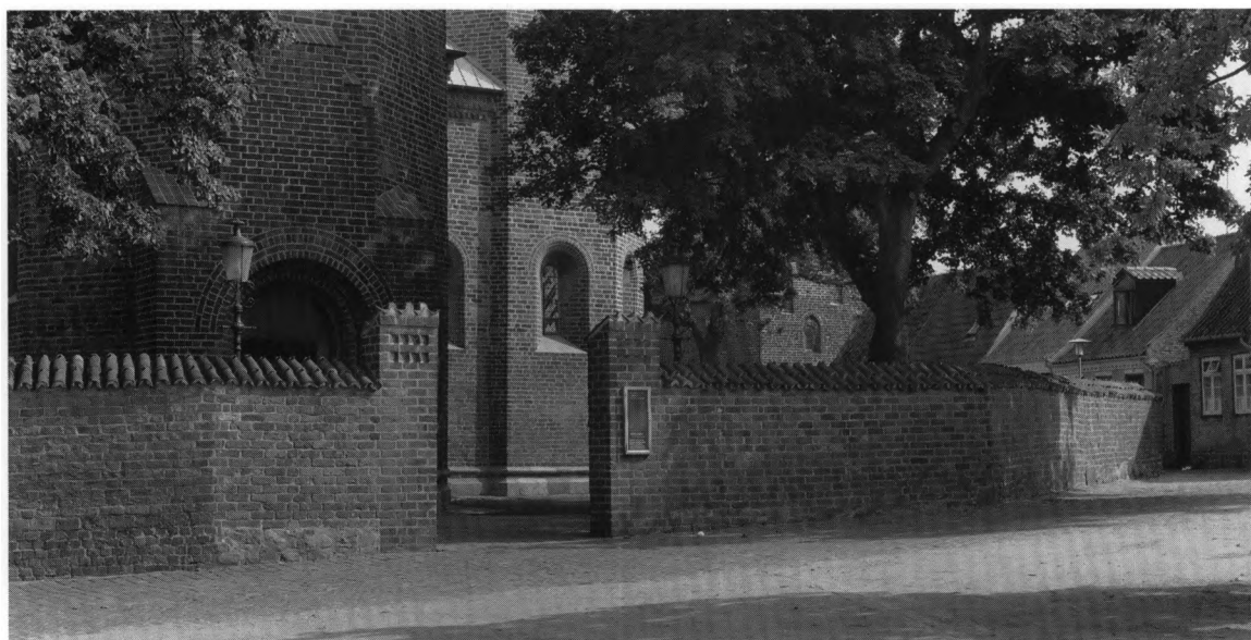
Fig. 16. Ydersiden af kirkegårdsmurens vestre del, syd for lågen, jfr. fig. 11 (s. 3030). HJ fot. 1991. - Outer face of the west part of the churchyard wall, south of the gate, cf. fig. 11.
