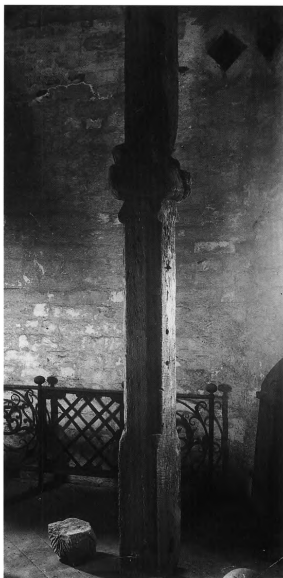
Fig. 126. Kongestolpe, antagelig fra midtertårnets † spir, nu opstillet i søndre tårns øvre stokværk (s. 3133). På billedet ses endvidere *granitkapitæl, *alterskranke og *dørfløj (s. 3085, 3158 og 3179). Ivar Hertzsprung fot. 1897. - King-post, presumably from the central tower's †spire, now put up in the upper storey of the south tower. In the photograph from 1897 is also shown *granite Capital, *altar rail and *door.
