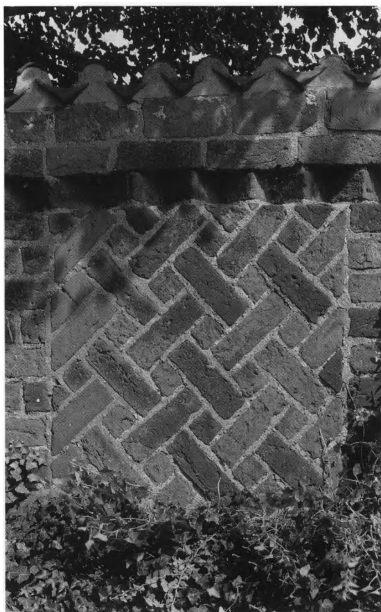
Fig. 30. Mønstermurværk på indersiden af kirkegårdsurens nordøstre del, jfr. fig. 12 (s. 3028). HJ fot. 1991. - Brickwork pattern on the inner face of the north-east part of the churchyard wall, cf. fig. 12.
