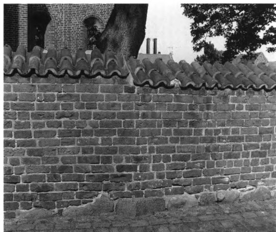
Fig. 15. Ydersiden af kirkegårdsmurens søndre del med sokkelkvader fra et thjørne inden murens udretning langs Præstegade, jfr. fig. 11 (s. 3027). HJ fot. 1991. - Outer face of the churchyard wall to the south with a plinth ashlar from a corner before the wall was realigned along Præstegade, cf. fig. 11.
