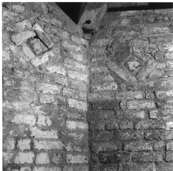
Fig. 232. Nordtårnets sydøstre hjørne med sekundært ommurede kanaler (s. 3082). HJ fot. 1995. - The north tower's south-east cower with rebuilt openings.
