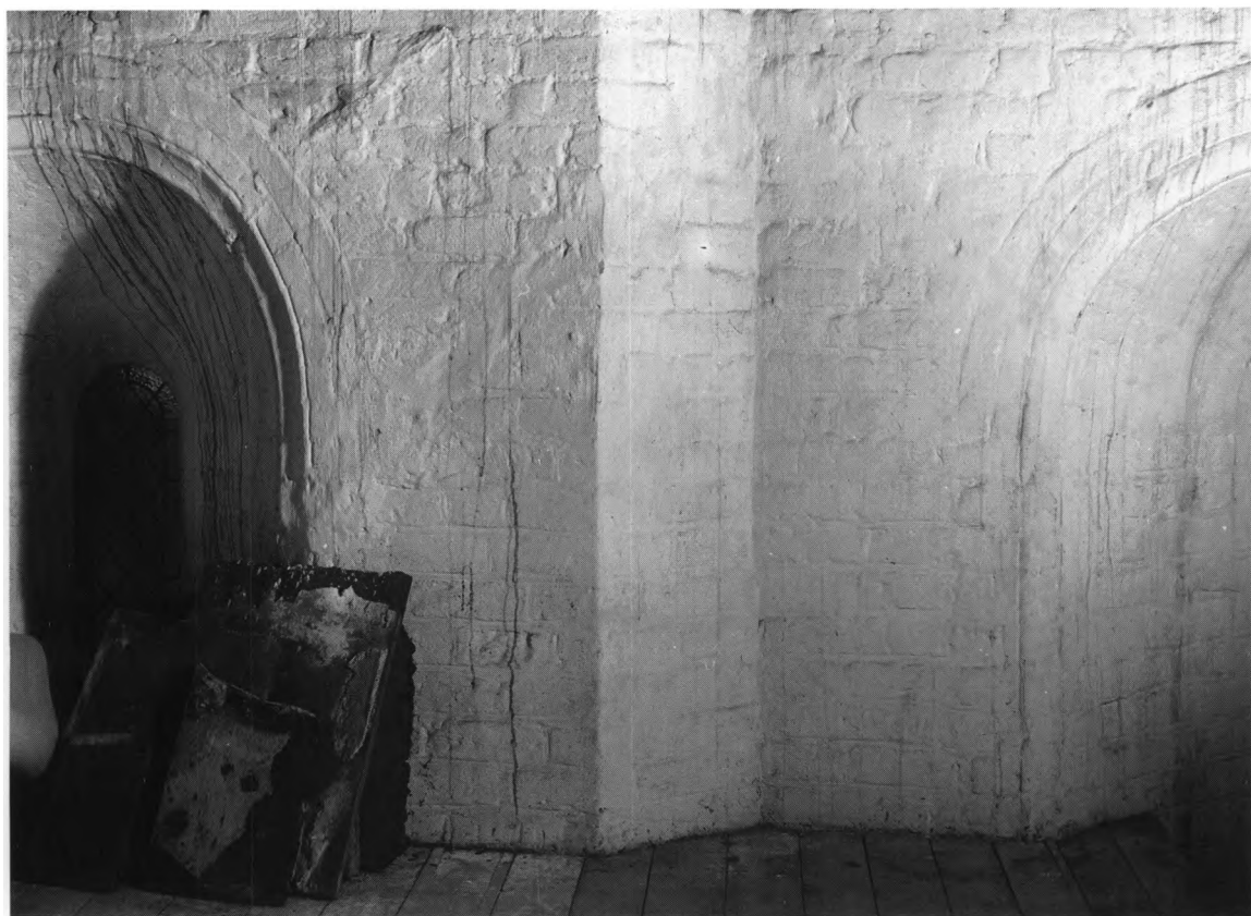
Fig. 104. Vinduer i østre korsarm, set fra sakristiets overetage (s. 3078). På muren anes tagspor fra et lavere sakristi, jfr. fig. 102 (s. 3100). HJ fot. 1991. - Windows in the east transept, seen from the sacristy's upper storey. Traces from a lower sacristy roof can be discerned on the wall.
