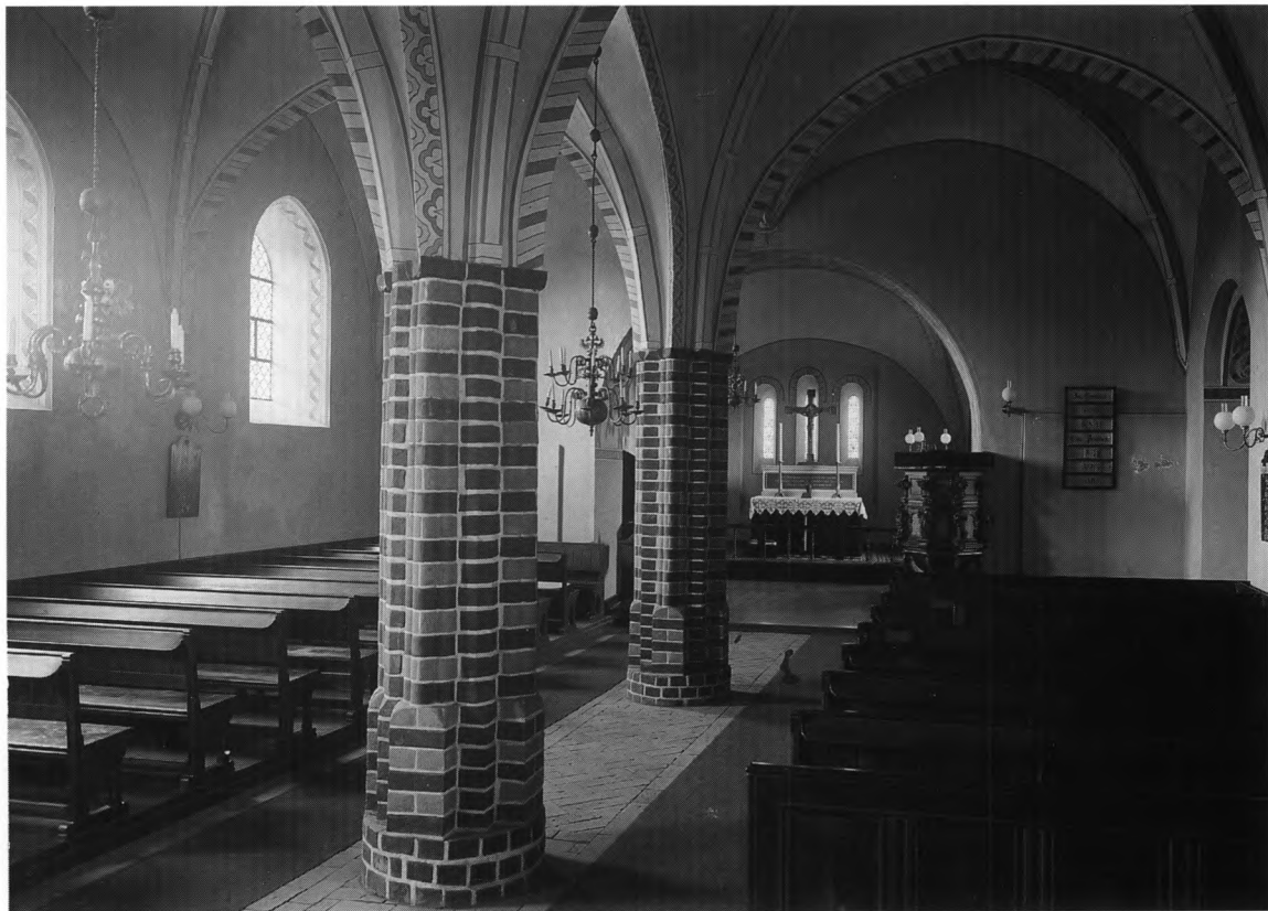
Fig. 27. Indre set mod øst. Hude fot. 1902. - Interior to the east.
