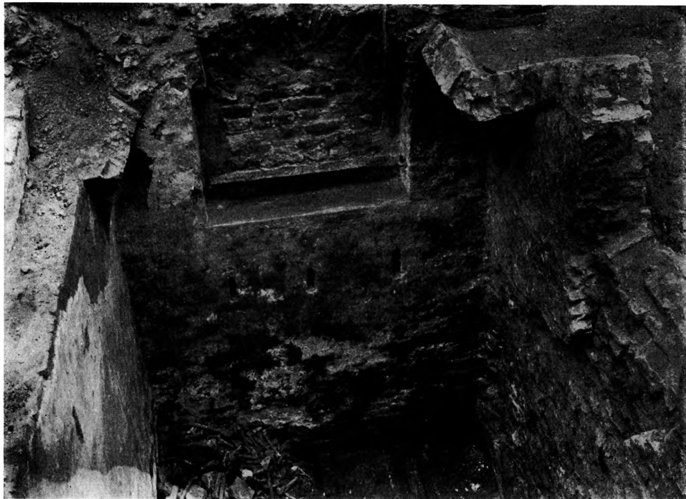
Fig. 85. Gravhvælving i Kapitelshusets Grund.
