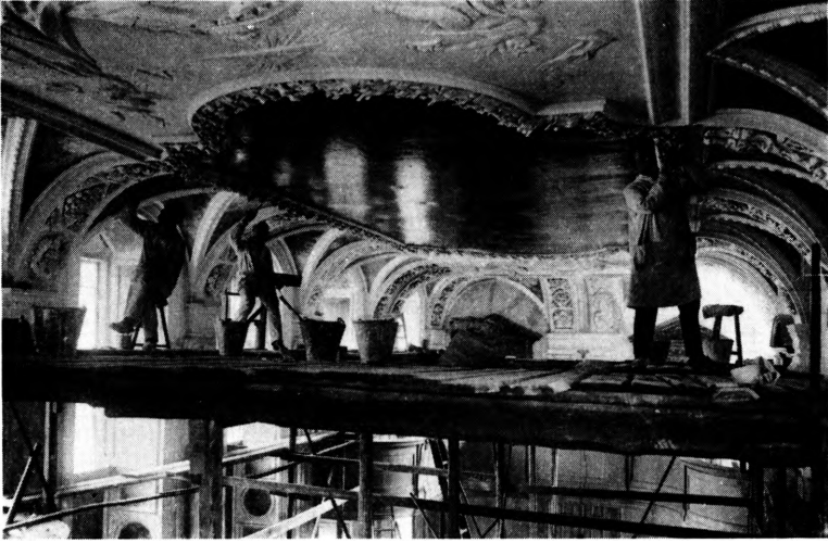
Fig. 26. Frederiksberg Slotskirke. Stukloftet repareres 1926. Efter fotografi i oberst Niels Maares privatarkiv.
