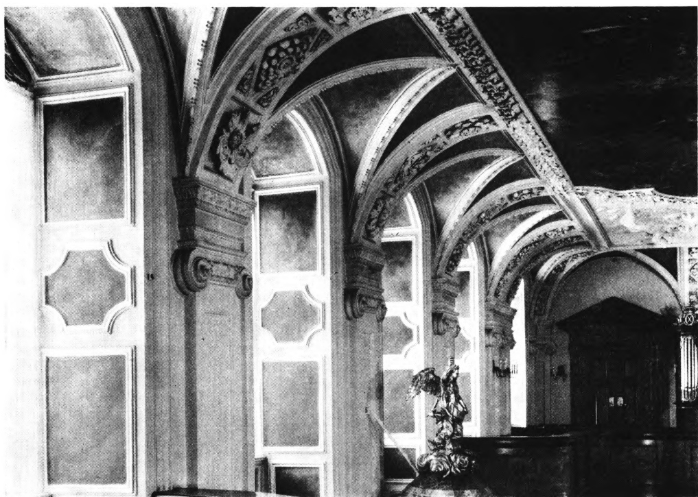
Fig. 14. Frederiksberg slotskirke. Den østre vinduesrække med stukloft.
