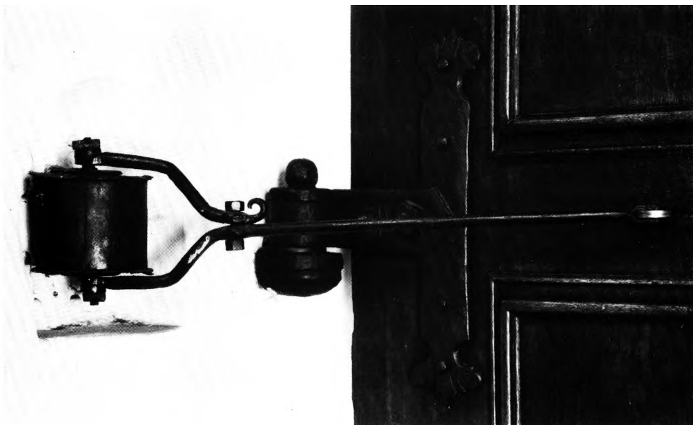
Fig. 74. Christians kirke. Hængsel og dorlukker, 1759, på hovedindgangens mellemdør (p. 180). – Christians Kirche. Scharnier und Türschliesser, 1759, an der mittleren Tür des Haupteinganges.
