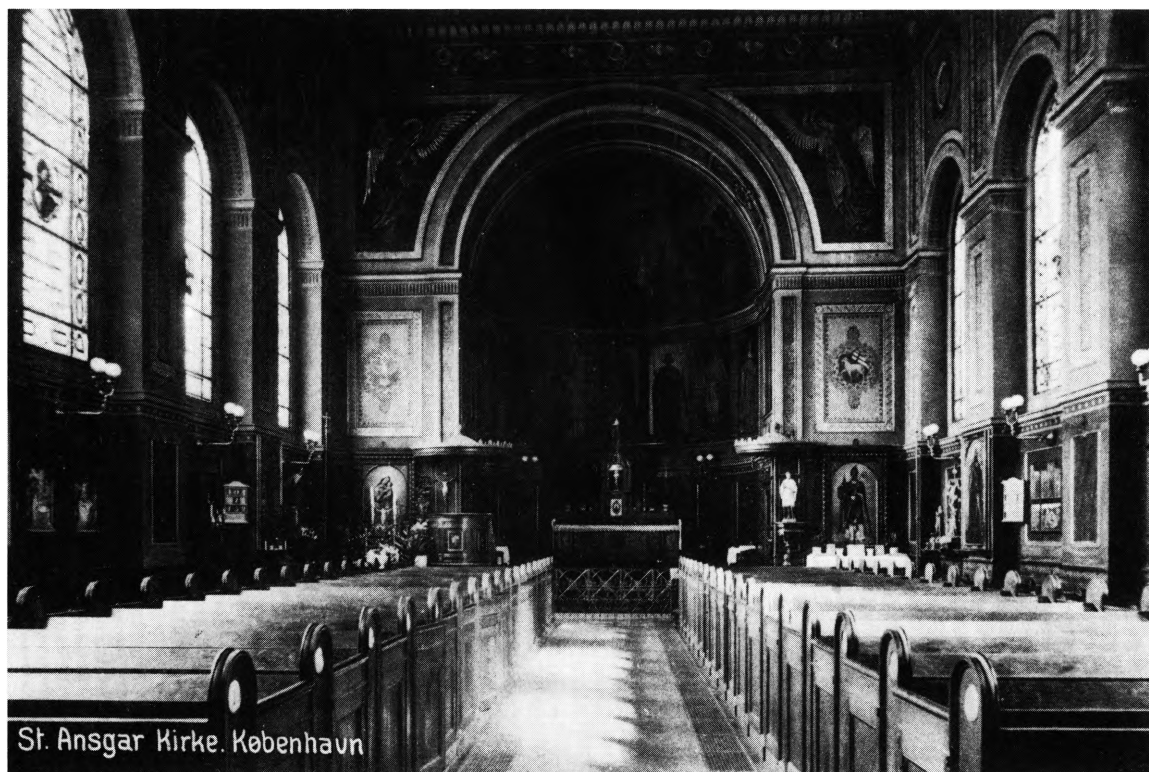
Fig. 61. Indre set mod øst med den nu afrensede vægudsmykning (s. 392). Ældre fot. efter 1907, men før 1932, i NM2. — Interior to the east. Early photograph taken between 1907-1932.
