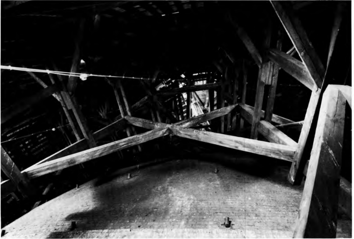
Fig. 227. Tagværkskonstruktionen, set fra nedre omgang (s. 717). Jens-Jørgen Frimand fot. 1986. – View of the roof construction.
