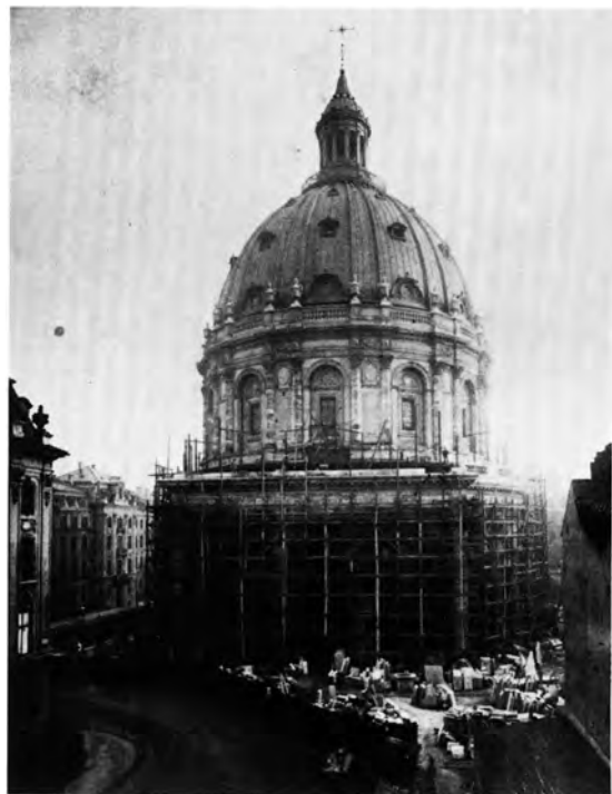
Fig. 183. Marmorkirkens byggeplads, set fra Store Kongensgade, o. 1890. Fot. KglBibl. – Marmorkirken's building site seen from Store Kongensgade, c. 1890.
