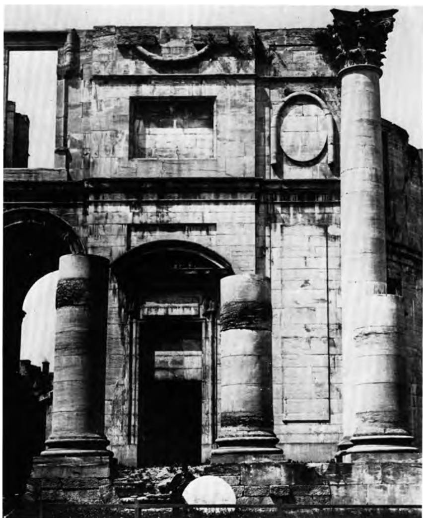
Fig. 133. Marmorkirkens nordøsthjørne med de tre delvist opførte søjler. Fot. i Kunstakademiets Bibliotek. — The northeast corner of the Marble Church with three, partially erected columns.
