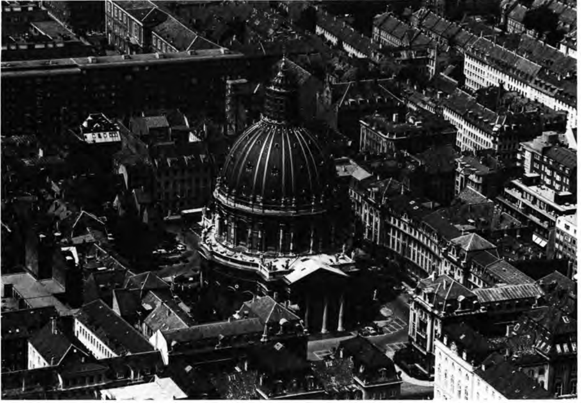
Fig. 193. Marmorkirken, fotograferet under kuplens og lanternens istandsættelse (s. 688). Tage Ruggaard fot. API 1975. – The Marble Church photographed during repairs to the dome and lantern, 1975.
