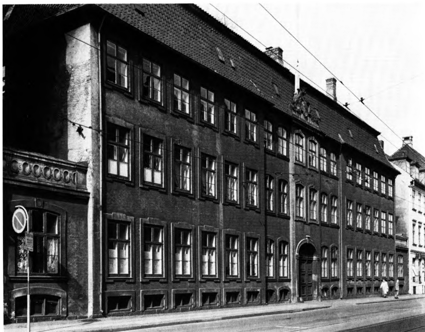
Fig. 171. Det Harboeske Enkefru-kloster efter forhøjelsen af mellembygningen 1773 ved C. F. Harsdorff (s. 188). NE fot. 1959. – The Harboe Foundation for Widows (Enkefru-kloster) after the additional storey was added to the building in the middle by C. F. Harsdorff 1773.
