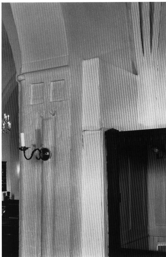
Fig. 41. Detalje af nordvestre korsskæringspille, set fra nordkappel (s. 1051). HJ fot. 1996. - Detail of the crossing's north-west pillar, seen from the north chapel.
