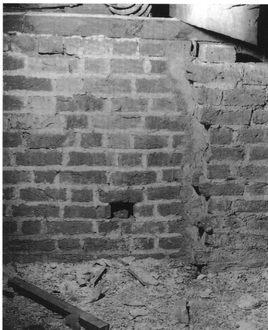
Fig. 56. Sammenføjningen i syd af midtskib og vestforlængelse, set fra loftsrummet (s.1282). HJ fot. 1997. - Joining to the south of the nave and the west extension seen from the loft.
