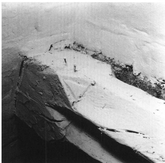
Fig. 307. Nordende af ankerbjælke langs korgavlen, jfr. fig. 66 (s. 1295). HJ fot. 1997. - North end of anchored beam along the chancel gable, cf. fig. 66.
