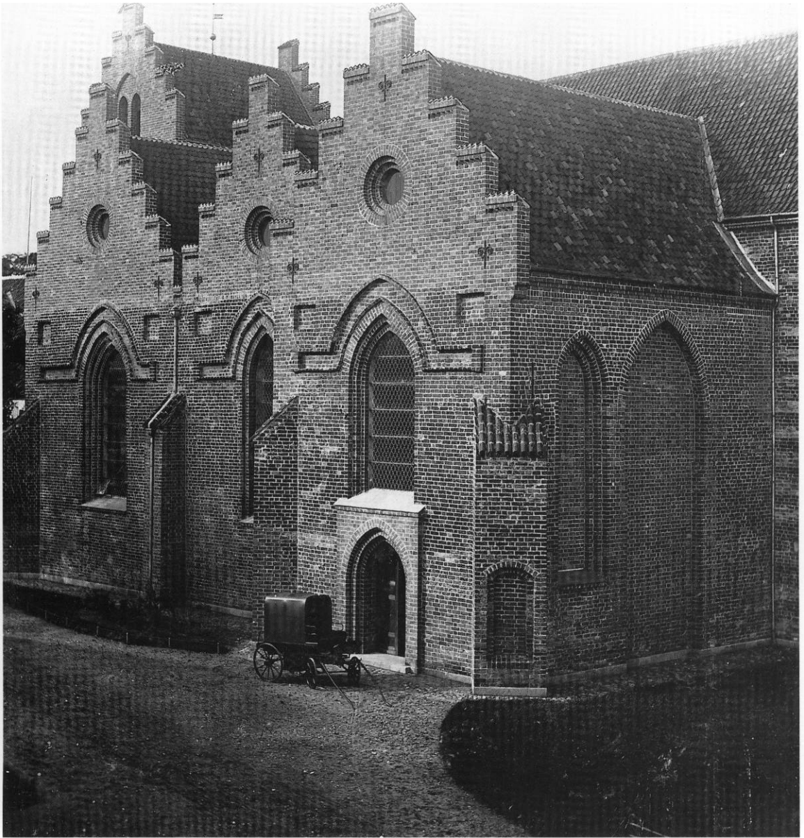
Fig. 53. Sydkapellerne, set fra sydøst. Ældre fot. efter hovedrestaureringen 1877-80. - Southern chapels seen from the south-east after the major restoration of 1877-80.
