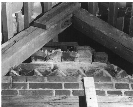
Fig. 59. Detalje af tårnets østre gesims, delvis dækket af kirkens tagværk (s. 1286). Henrik Wichmann 1998. - Detail of the tower's east cornice, partly concealed by the church roof.
