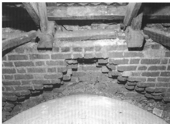
Fig. 70. Detalje af korets nordre overvæg med hvalv -forlæg (s. 1294). HJ fot. 1997. - Detail of the upper north wall with springer for vault.
