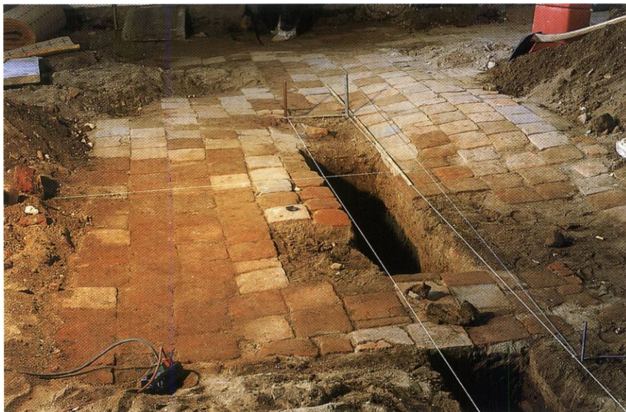
Fig. 107. Ældre flgulve i vestforlængelsens smalle fag og det tilgrænsende 3. fag af midtskibet, set mod vest, jfr. fig. 34 (s. 1331). HJ fot. 1997. - Earlier flfloors in the west extension's narrow bay and the abutting third bay of the nave, seen to the west, cf. fig. 34.
