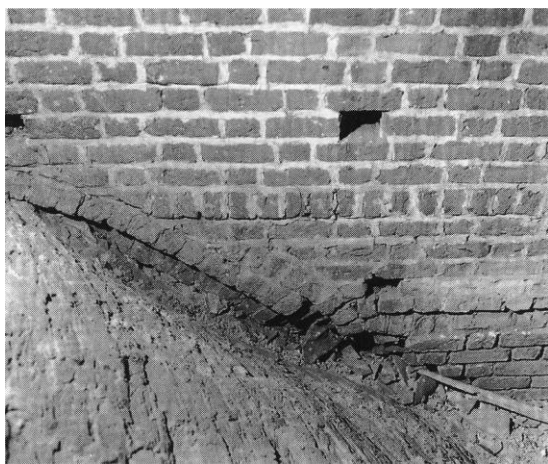
Fig. 57a-b. Midtskibets overvæg, set fra loftet over nordre sideskibs 2. fag, hvor murværkets øvre del hviler på en trinvis udkraget aflastningsbue over hvælvkappen. Nærmest hvælvlokkerne ses udvaskede fuger (s. 1283). HJ fot. 1997. - Upper wall of the nave seen from the loft above the second bay of the north side aisle, where the masonry rests on the stepped corbelling of a relieving arch above the vault. Eroded joints can be seen close to the pendentives.
