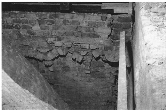
Fig. 89. Detalje af overvæg mellem søndre sideskibs 2. og 3. fag, set fra loftet over sidstnævnte (s. 1309). HJ fot. 1997. - Detail of the upper wall between the second and third bay of the south side aisle, seen from the loft above the latter.
