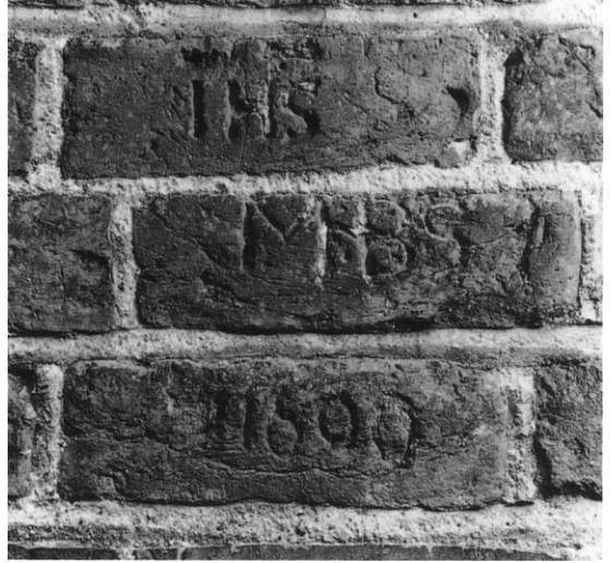
Fig. 99. Mursten på vestsiden af søndre sideskibs hjørnepille med fabrikationsstempel (»I H S«), håndværkersignatur(?) (»M H B S«) og årstal (»1699«). Henrik Wichmann fot. 1999. - Bricks on the south side aisle's corner pillar with manufacturer's mark (»I H S«), artisan's initials(?) (»M H B S«) and year (»1699«).
