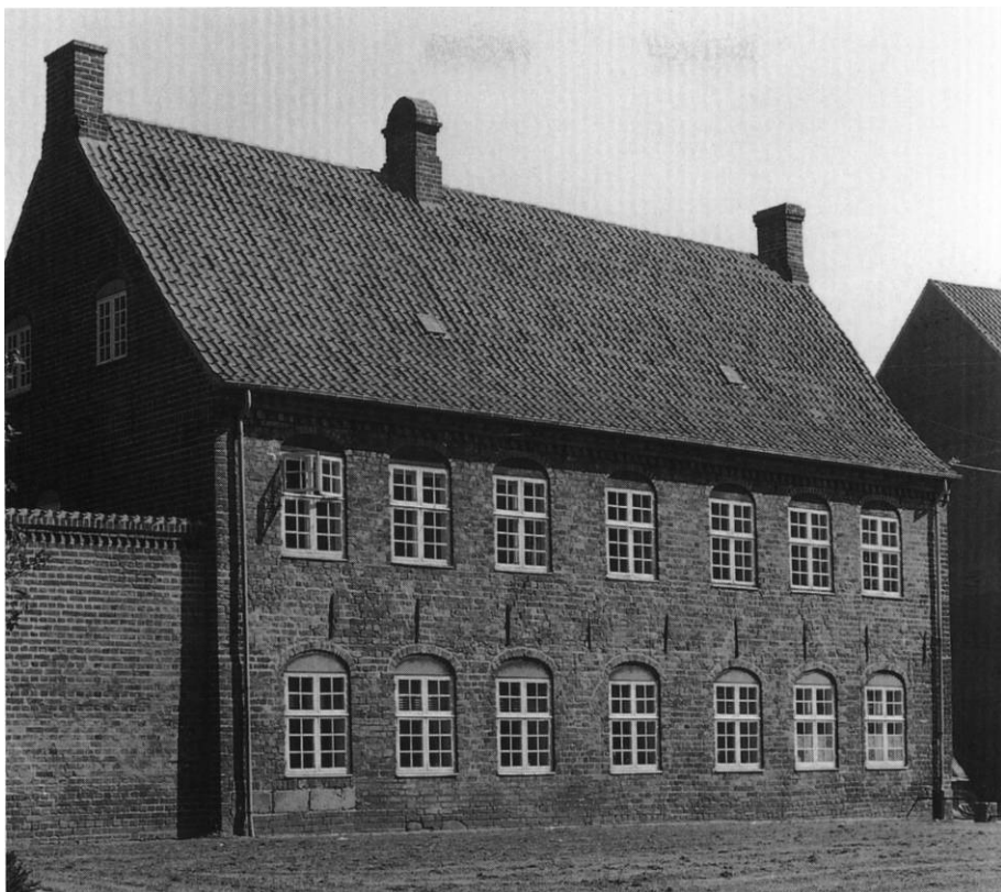
Fig. 19. Præstegårdens sydfacade mod den tidligere kirkegård (s. 1237f.). HJ fot. 1997. - South facade of the Rectory overlooking the former cemetery.
