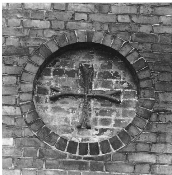
Fig. 82. Cirkelblænding med Johanniterkors på nordre sideskibs 2. fag. Formstenene overført fra nordkapellets nedrevne ydermur, jfr. fig. 38 (s. 1301). HJ fot. 1998. - Circular recess with the Maltese cross in the second bay of the north side aisle. The moulded bricks come from the demolished outer wall of the north chapel, cf. 38.
