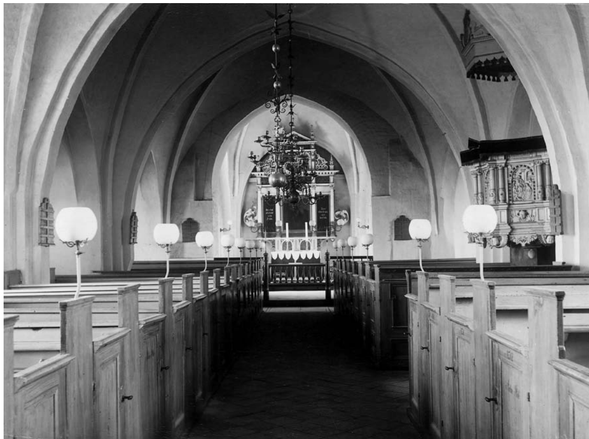
Fig. 66. Skibet set mod øst. Foto før 1905. – The nave looking east.
