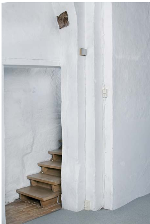
Fig. 29-30. Korets sydvestre (tv.) og nordvestre hvælpille med overskåret bjælke fra †lektorium (s. 2123). Foto Arnold Mikkelsen 2008. – The south-west (left) and north-west vaulting pillar of the chancel, with severed beam from the †gallery.
