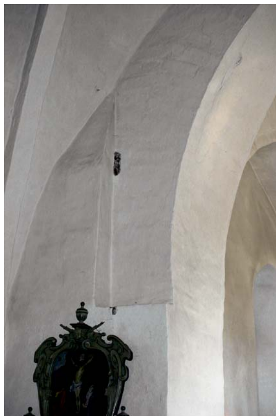
Fig. 119. Afsætning til tlektorium på kormurens vestside, set fra sydvest (s. 2123). Foto Thomas Bertelsen 2009. – Recess for the t gallery on the west side of the chancel, seen from the south-west.
