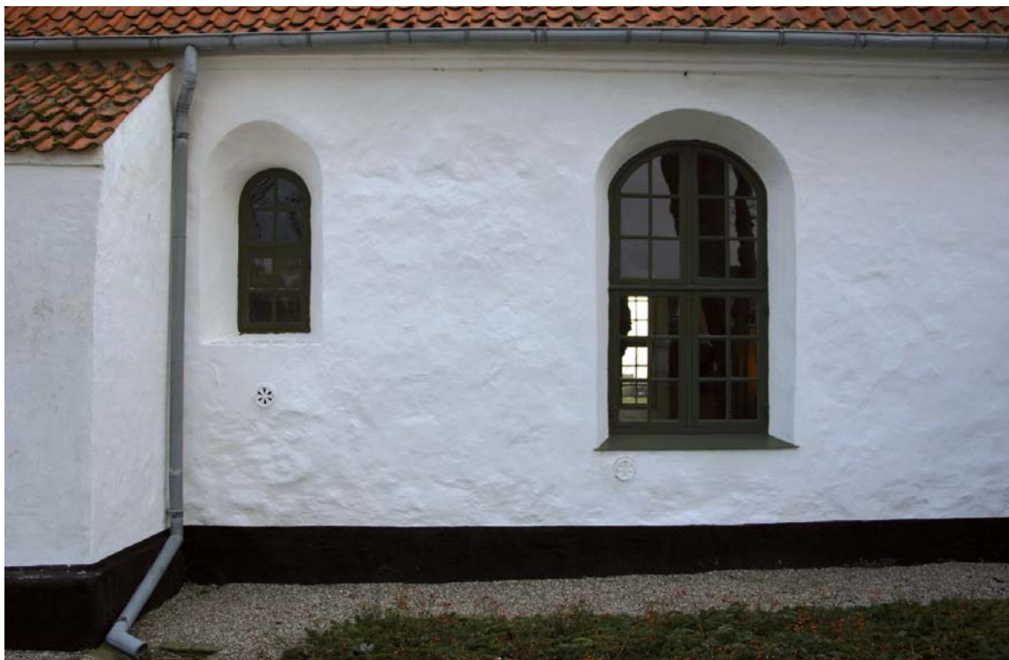
Fig. 14. Udsnit af kirkens sydfacade med romansk vindue i vestforlængelsen og nyere vindue i skibet (s. 2111 ff., 2134). Foto Thomas Bertelsen 2009. – Part of the south facade of the church with Romanesque window in the western extension and later window in the nave.
