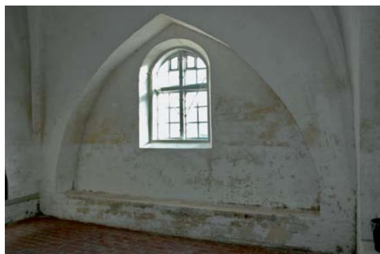
Fig. 118. Tårnrummets østre vægblænding (s. 2114). Foto Thomas Bertelsen 2009. – Bricked up space in the east wall of the tower room.
