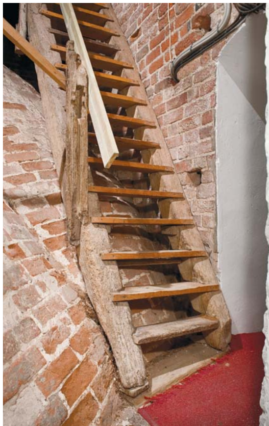
Fig. 31. Trappe i tårnet som forbinder hulrummet over tårnrummets hvælv med mellemstokværket (s. 2259 f.). Foto Arnold Mikkelsen 2010. – Staircase in the tower linking the space above the vault of the tower room to the middle storey.
