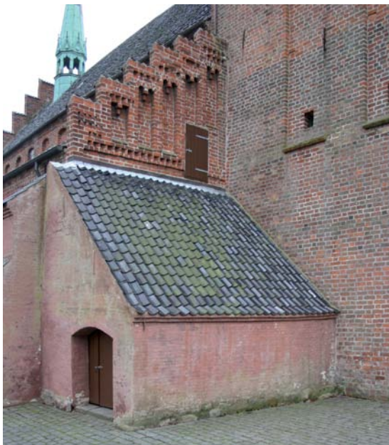
Fig. 59. Materialhus ved nordre sideskibs vestgavl (s. 2279 f.). Foto Thomas Bertelsen 2009. – Storehouse at the west gable of the north aisle.
