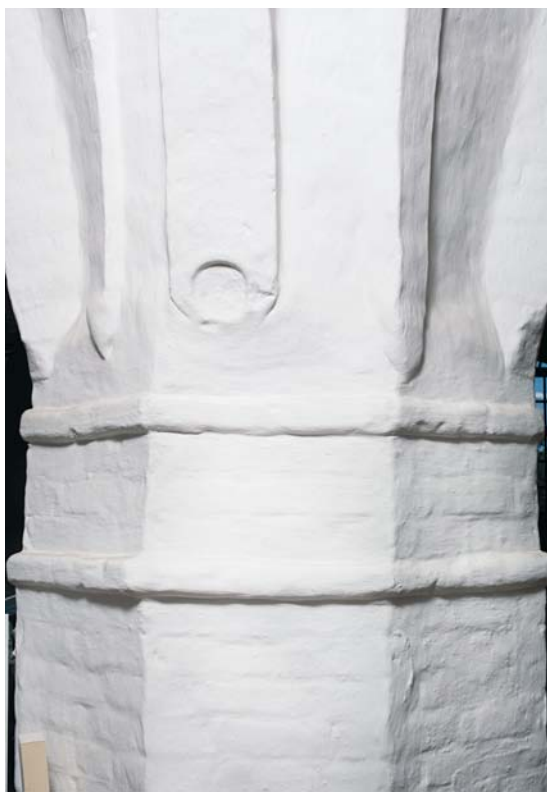
Fig. 58. Gjorbuekonsol på midterste arkadepille, set fra syd i søndre sideskib (s. 2277). Foto Arnold Mikkelsen 2010. – Corbel of the rib on the central arcade pillar, seen from the south in the south aisle.
