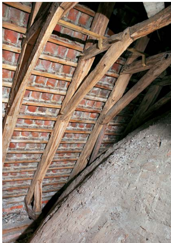
Fig. 63. Korets tagværk, set fra sydvest (s. 2283). Foto Arnold Mikkelsen 2009. – The roof construction of the chancel, seen from the southwest.
