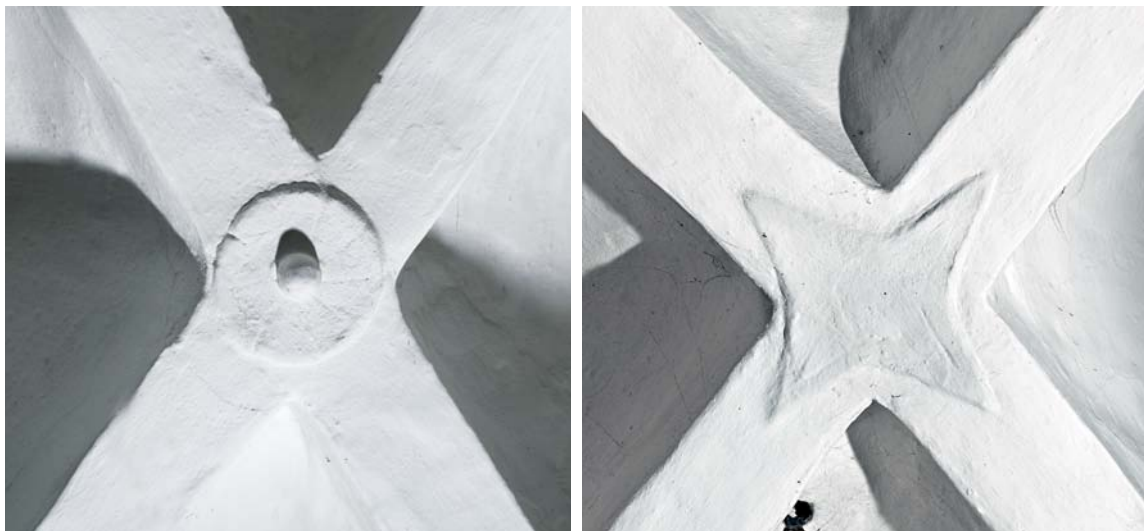
Fig. 56-57. 56. Stukroset i toppen af søndre sideskibs næstvestligste hvælvfag (s. 2277). 57. Stukstjerne i toppen af nordre sideskibs østligste hvælvfag (s. 2277). Foto Arnold Mikkelsen 2010. – 56. Stucco rosette at the top of the second vault-section from the west in the south aisle. 57. Stucco star at the top of the easternmost vault-section of the north aisle.
