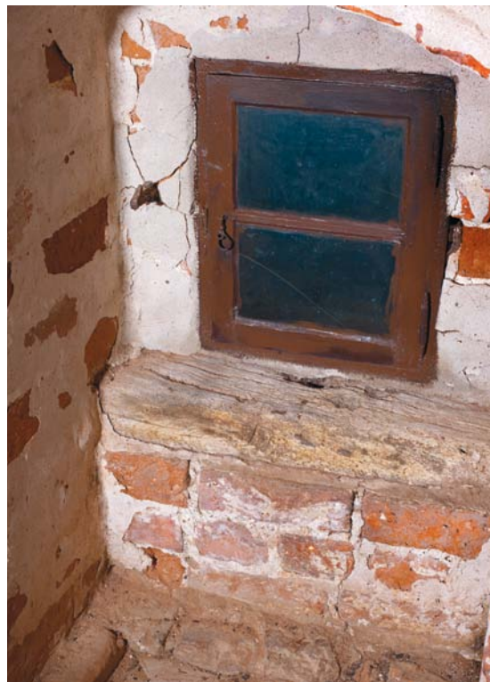
Fig. 32-33. Østligste skydeskår i nordmuren i tårnets mellemstokværk (s. 2260). 32. Opstalt set mod nord, plan og snit. 1:50. Målt og tegnet af Thomas Bertelsen 2010. 33. Rekylbjælke med hul til gaffelkanon, set fra sydøst. Foto Arnold Mikkelsen 2009. – Embrasure furthest to the east in the north wall of the tower's middle storey. 32. Elevation looking north, plan and cross section. 1:50. 33. Recoil beam with hole for a gun-support, seen from the southeast.
