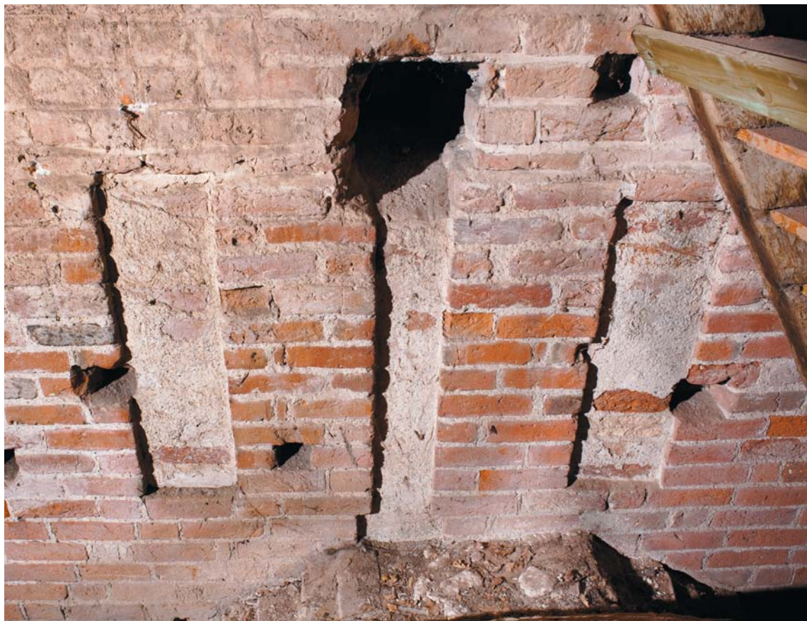
Fig. 11. Blændingsdekoration på vestgavlen af det teglsatte \uparrow skib, set fra vest under tårnets mellemstokværk (s. 2235). Foto Arnold Mikkelsen 2009. – Blind arcading on the west gable of the brick-built \uparrow nave, seen from the west below the middle storey of the tower.
