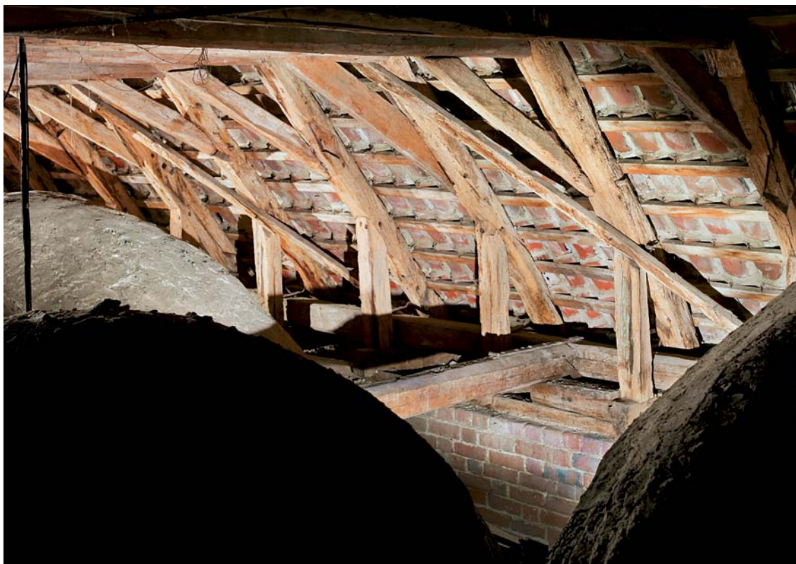
Fig. 65. Midtskibets tagværk og hvælv, set fra sydøst (s. 2284 f.). Foto Arnold Mikkelsen 2009. – The roof construction and vault of the nave, seen from the southeast.
