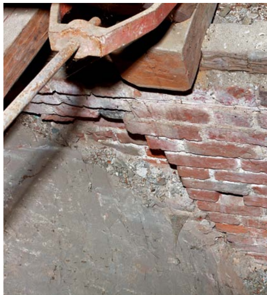
Fig. 49. Hvælvforlæg for midtskibets næstøstligste hvælv fra øst, set fra nordvest (s. 2272 f.). Foto Arnold Mikkelsen 2009. – The vault-setting for the nave's second vault from the east, seen from the northwest.
