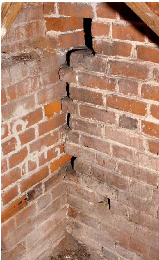
Fig. 47. Sammenstødet mellem nordre høj Kirkemur og nordre sideskibs østre gavltrekant, set fra loftet af nordre sideskib fra nordvest (s. 2264). Foto Arnold Mikkelsen 2009. – Junction between the north clerestory wall and the eastern gable triangle of the north aisle, seen from the loft of the north aisle, from the northwest.
