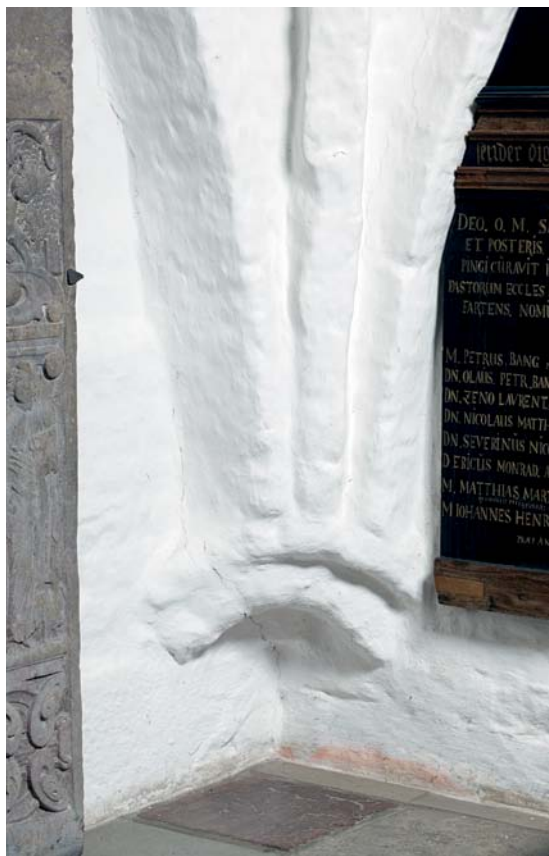
Fig. 21. Hvælvkonsol i sakristiets sydvestre hjørne, set fra nordøst (s. 2250). Foto Arnold Mikkelsen 2010. – Corbel of the vault-rib in the southwest corner of the vestry, seen from the northeast.
