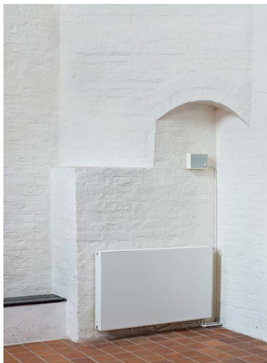
Fig. 139. Tårnrummets nordøstre hjørne med tilgang til fligeløbstrappe, set fra sydvest (s. 2434). Foto Arnold Mikkelsen 2011. – North west corner of tower room with approach to †straight-run stairs, seen from the south west.
