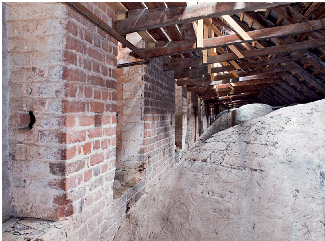
Fig. 48. Nedre del af 'triforieåbninger' i søndre højkirkemurs 1. byggefase, set fra sideskibsloftet fra sydvest (s. 2472). Foto Arnold Mikkelsen 2011. – Lower part of 'triforium openings' in the 1st construction phase of the nave wall, seen from the side aisle ceiling from the south west.
