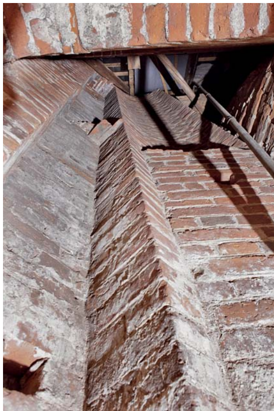
Fig. 21. Tårnets sydøstre facade, set nedefra fra sideskibsloftet (s. 2445-46). Foto Arnold Mikkelsen 2011. – South east facade of the tower, seen from below from the side aisle ceiling.
