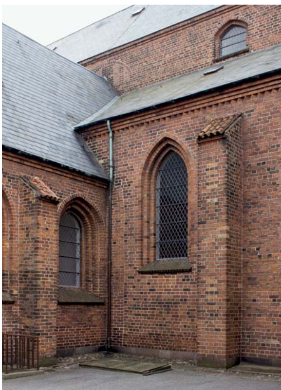
Fig. 25. Nordre sideskibs sammenstød med nordre korsarm, set fra nordvest. Foto Thomas Bertelsen 2011. – Where the north side aisle meets the north transept, seen from the north west.
