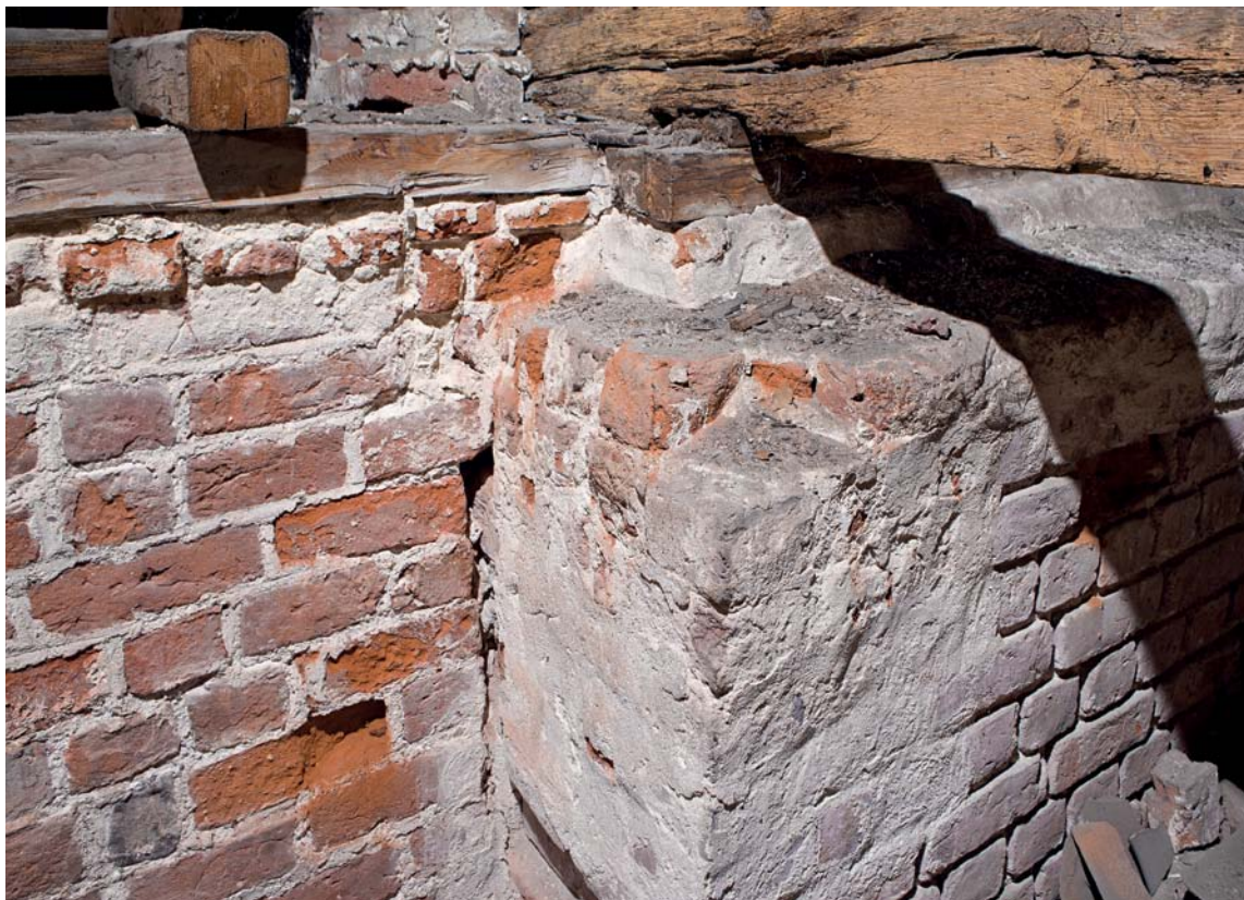
Fig. 29. Søndre højkirke mur ved sammenstødet mellem 1. og 2. byggefase, set fra midtskibsloftet fra nordøst (s. 2455-56). Foto Arnold Mikkelsen 2011. – South nave wall at the point where the 1st and second construction phase meet, seen from the nave ceiling from the north east.
