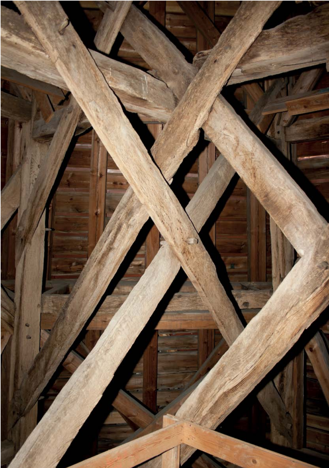
Fig. 67. Tårnets spirkonstruktion, nedre del (s. 2505 ff.), set mod sydøst. Foto Mogens Vedsø 2012. – Spire construction of the tower, lower part, looking south east.
