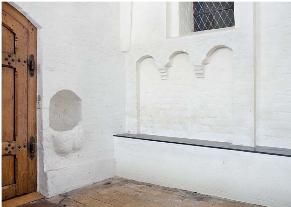
Fig. 54. Våbenhusets indre, set mod nordøst (s. 2480, 2529). Foto Arnold Mikkelsen 2011. – Porch interior, looking north east.
