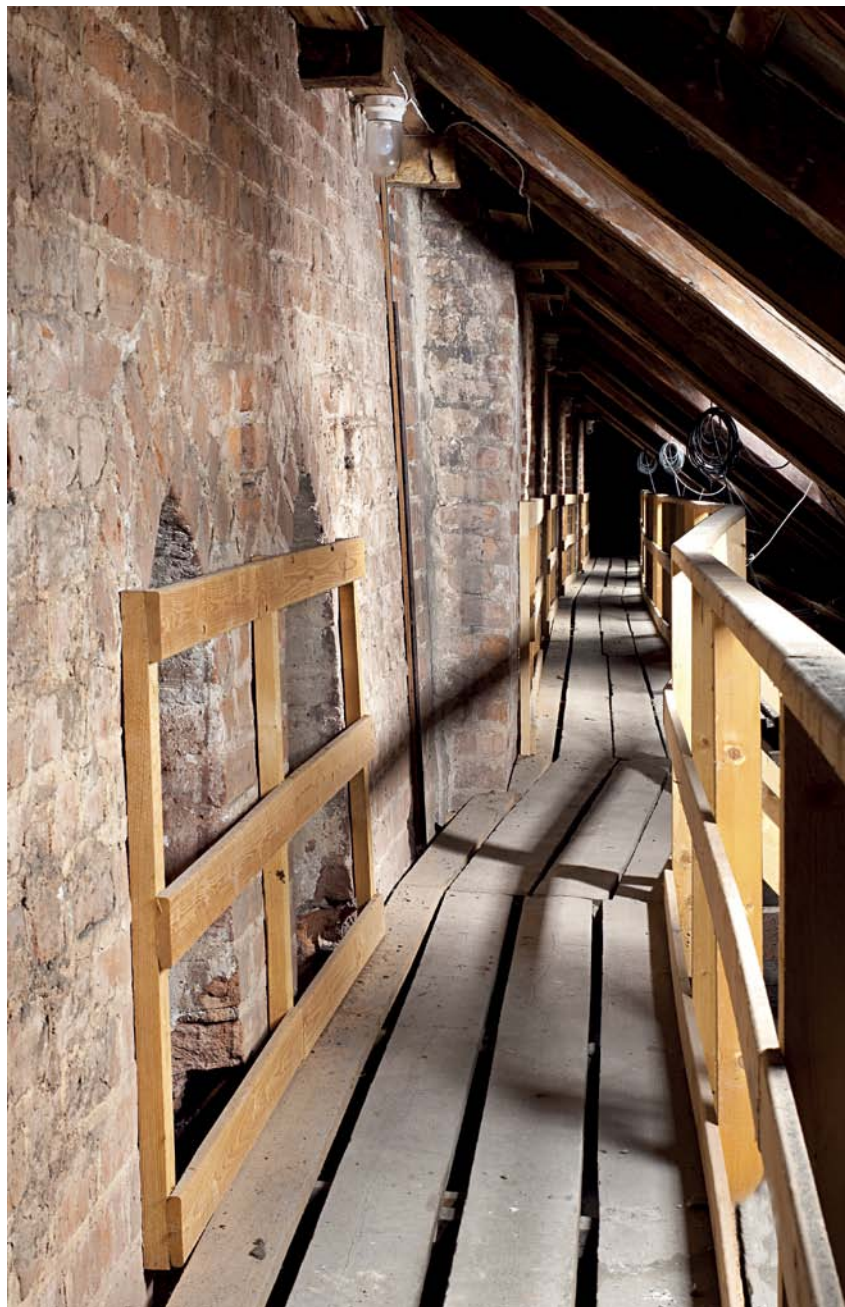
Fig. 28. Søndre højkirke mur ved overgangen mellem 1. og 2. byggefase, set fra sideskibsloftet fra vest (s. 2455-56). Foto Arnold Mikkelsen 2011. – South nave wall at the transition between 1st and 2nd construction phase, seen from the side aisle ceiling from the west.
