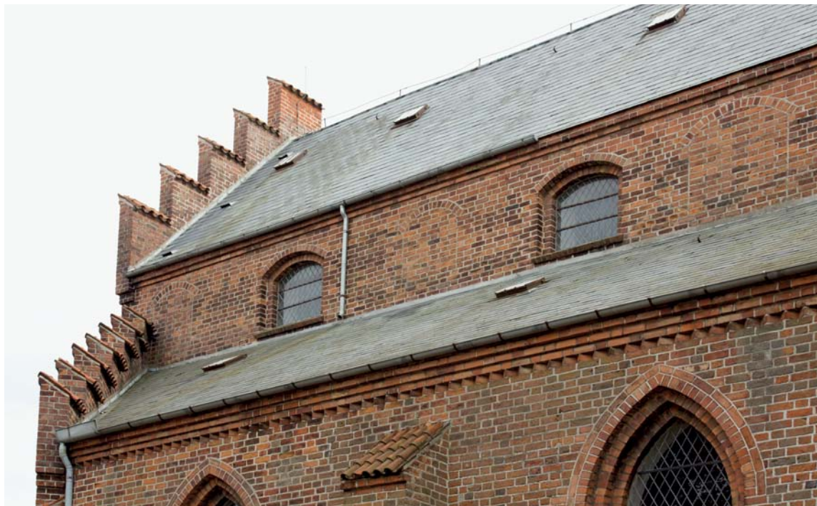
Fig. 143. Nordre højkirkemurs østre del, set fra nordvest. Foto Thomas Bertelsen 2011. – Eastern part of the north nave wall, seen from the north west.
