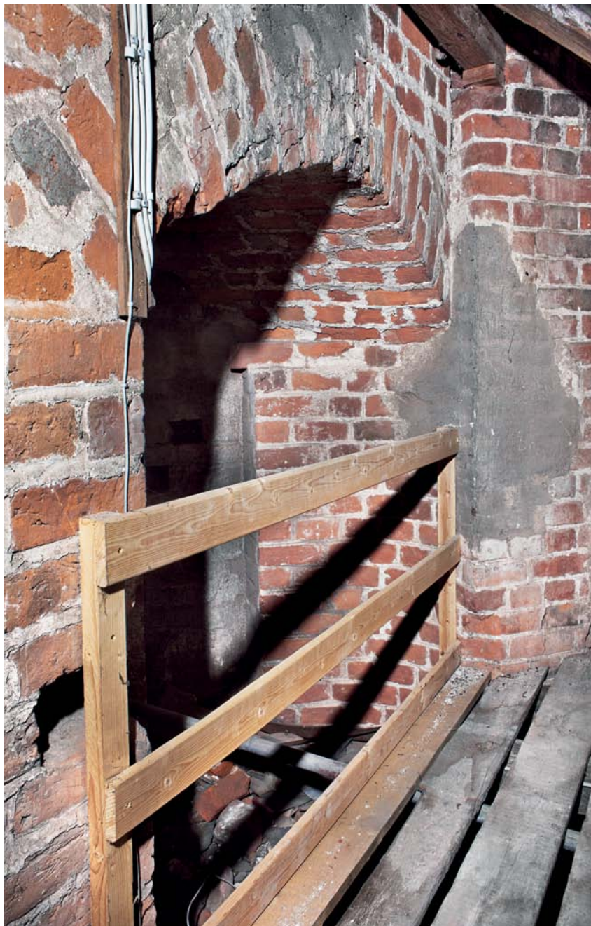
Fig. 50. Aflastningsbue i nordre højkirkemur ved overgangen til tårnet, set fra sideskibsloftet fra nordøst (s. 2472-73). Foto Arnold Mikkelsen 2011. – Relieving arch in the north nave wall at the transition to the tower, seen from the side aisle ceiling from the north east.
