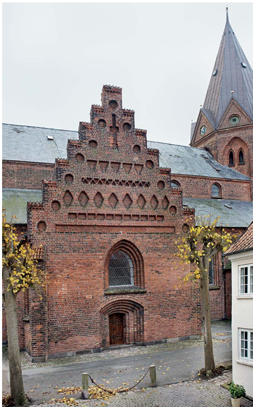
Fig. 13. Nordre korsarm, set fra nordøst (s. 2434 ff.). Foto Arnold Mikkelsen 2011. – North transept, seen from the north east.
