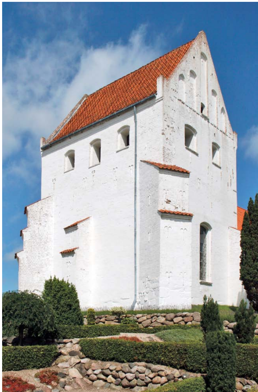
Fig. 10. Tårnet set fra sydvest (s. 2651). Foto Martin Wangsgaard Jürgensen 2012. – Tower seen from the south west.
