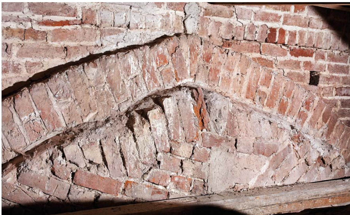
Fig. 13. Tårnbuens top set fra vest (s. 2655); blændet ved opførelsen af skibets hvælv (s. 2659). – Top of the tower arch seen from the west; bricked up when the nave vault was built.
