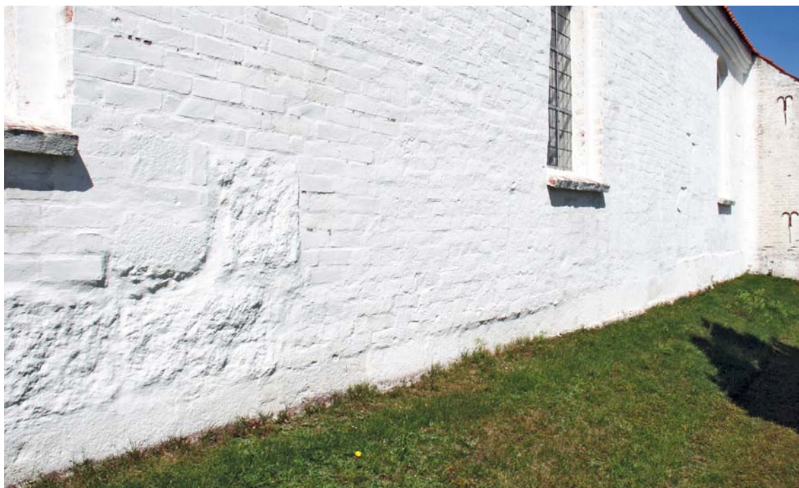
Fig. 42. Udsnit af kirkens sydmur. Foto Martin Wangsgaard Jürgensen 2012. (s. 2650). – South wall.
