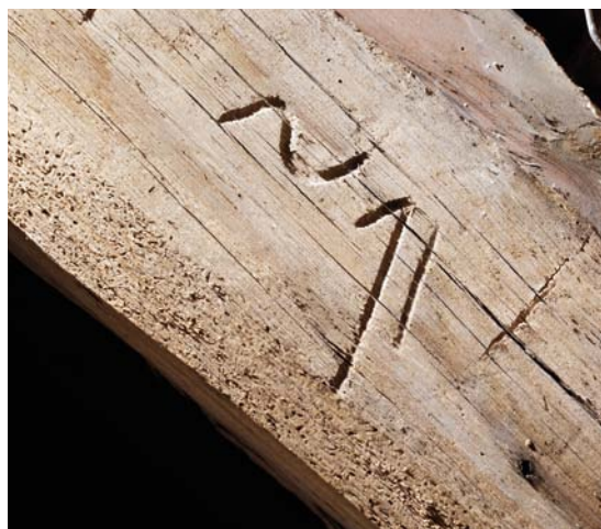
Fig. 44. Tømmermærker på skibets tagværk (s. 2662). Foto Arnold Mikkelsen 2012. – Timber marks in the roof of the nave.
