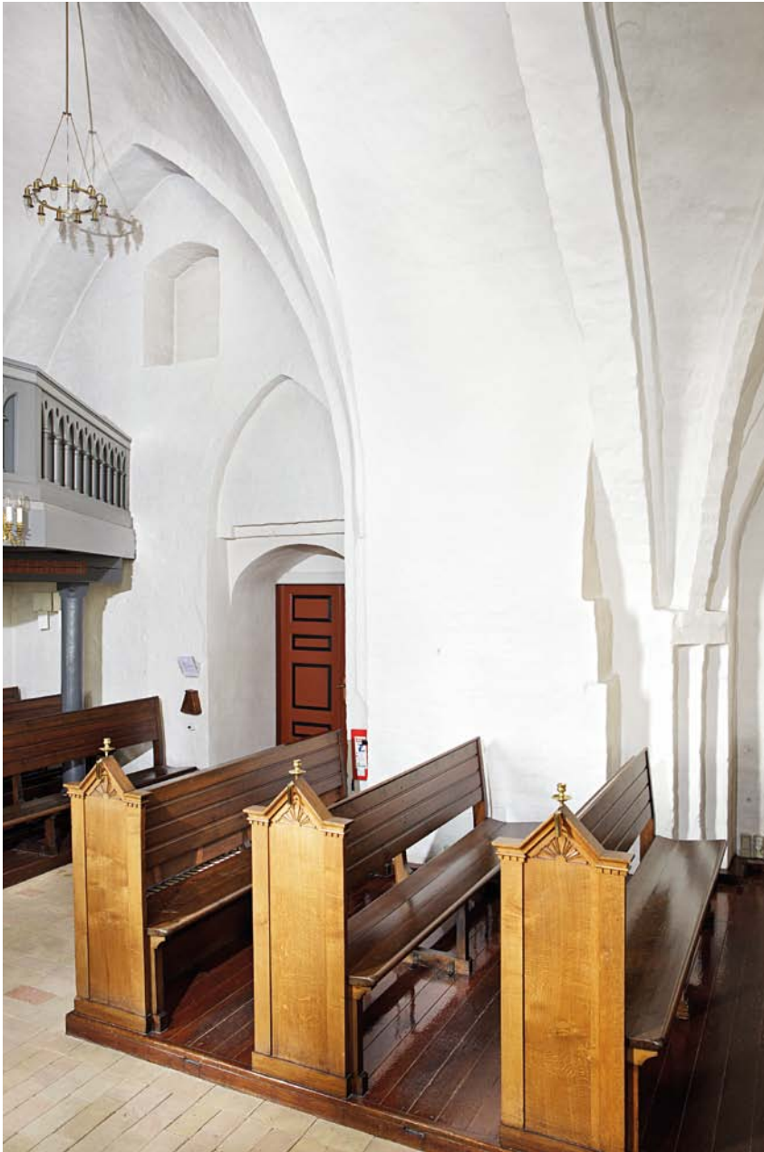
Fig. 11. Mødet mellem tårnarkade og skibets hvælv (s. 2651). Foto Arnold Mikkelsen 2012. – Point where tower arcade meets nave vault.
