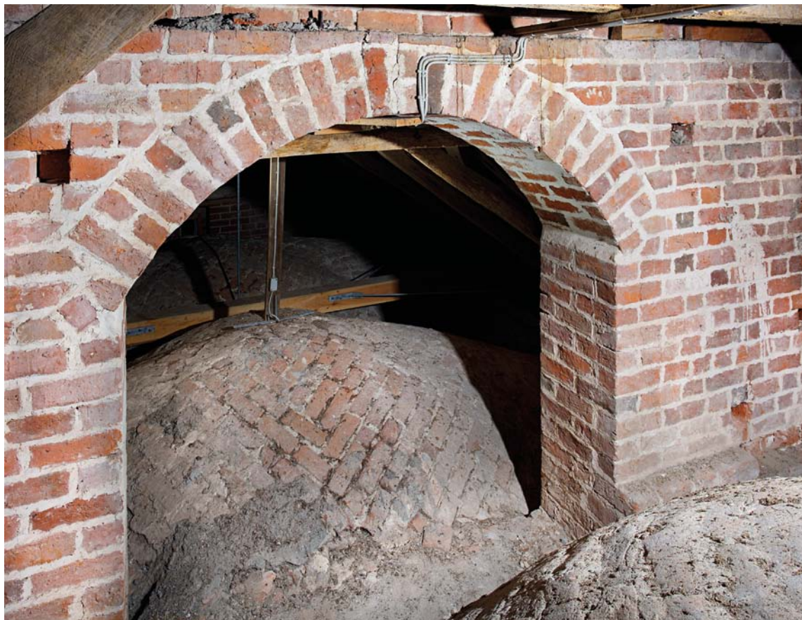
Fig. 5. Gotisk passage mellem kor og skib over hvælvene set mod sydøst (s. 2766). Foto Arnold Mikkelsen 2012. – Gothic passage between chancel and nave looking south east.
