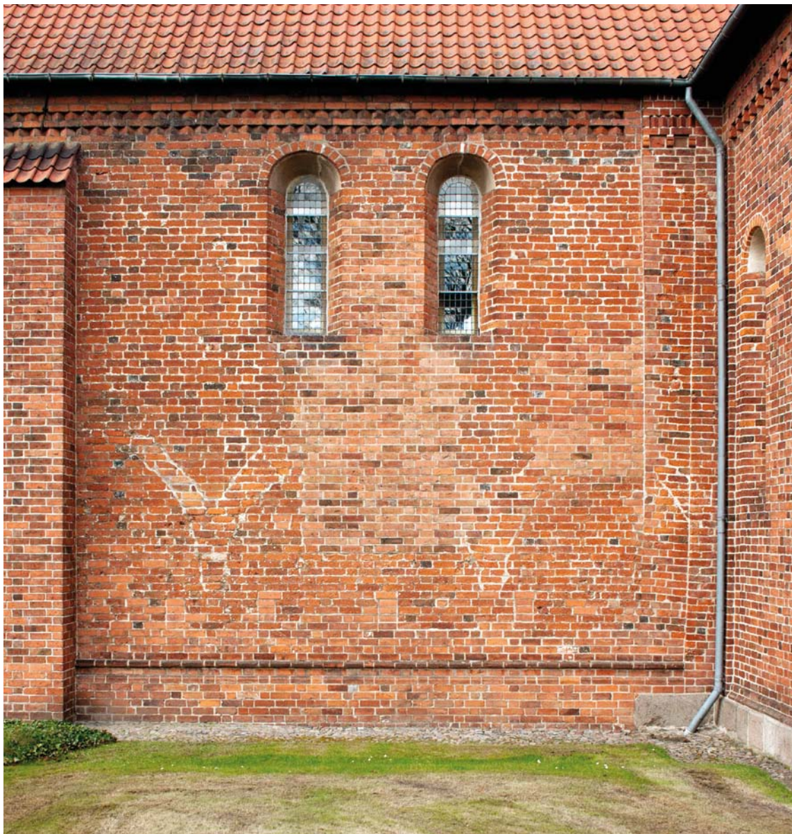
Fig. 20. Skibets sydmur, østlige fag. Foto Mogens Vedsø 2014. – South wall of the nave.
