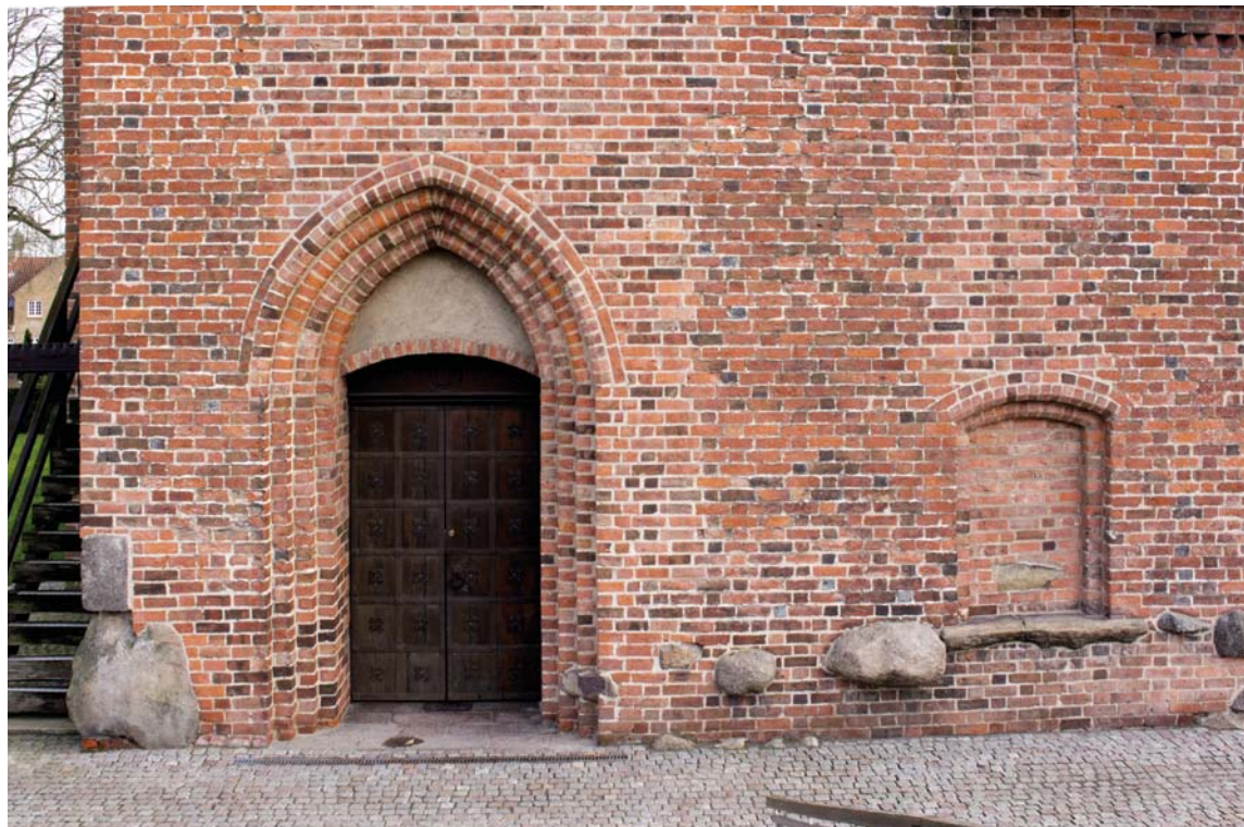
Fig. 92. Vestindgangen (s. 2826). Foto David Burmeister Kaaring 2014. – The west entrance.
