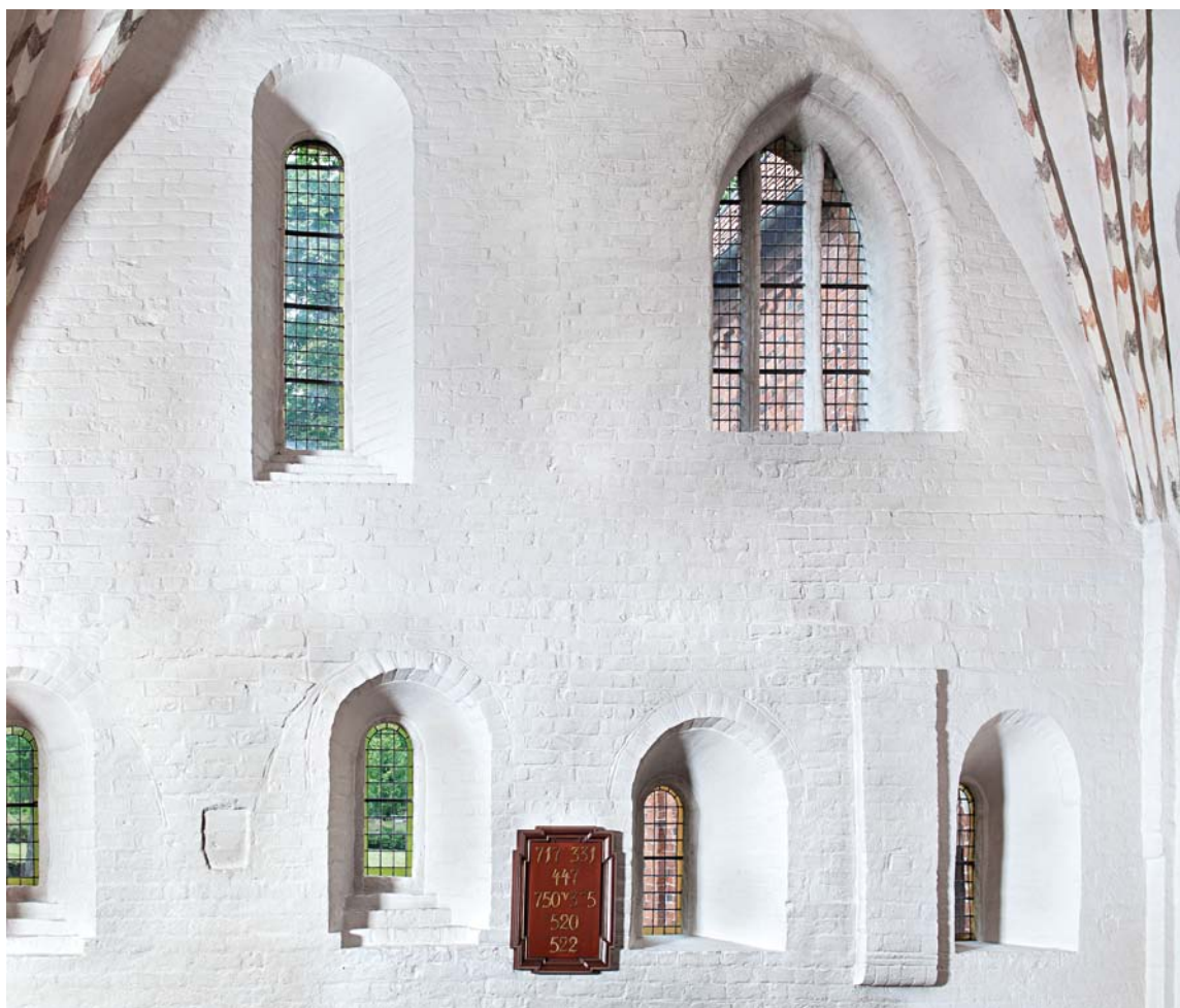
Fig. 18. Den østlige del af skibets nordvæg (s. 2817). Foto Arnold Mikkelsen 2013. – Eastern part of the north wall of the nave.
