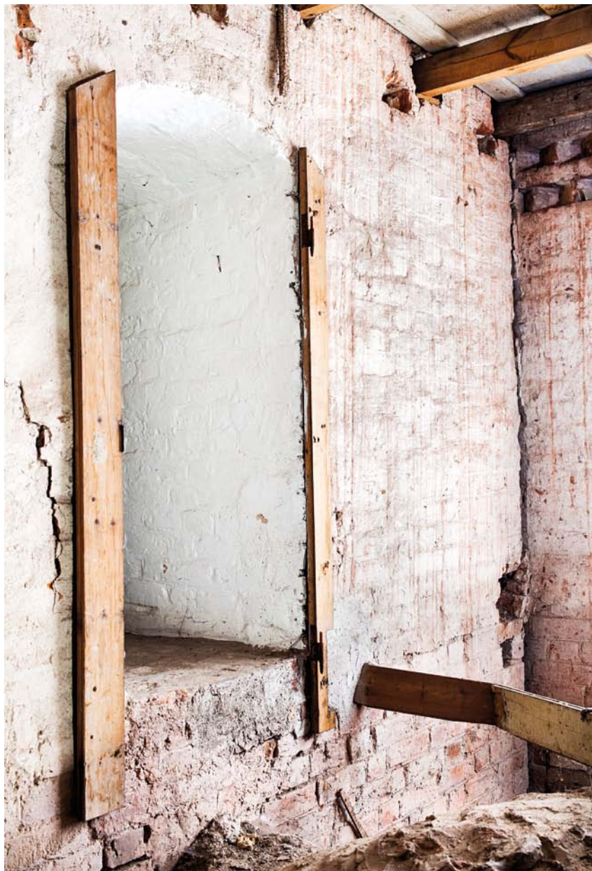
Fig. 29. Nonnernes dør over fordelingsbygningens hvælv, der giver adgang til tårnet (s. 2831). Foto Arnold Mikkelsen 2013. – Nuns' door above vault of distribution building, giving access to the tower.
