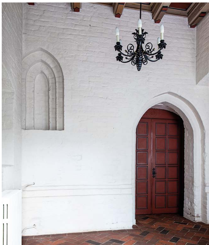
Fig. 26-27. 26. Tårnrummets indre set mod øst (s. 2826). 27. Blændingsfrisen på skibets vestgavl (s. 2823) set fra tårnets andet mellemstokværk (s. 2829). Foto Arnold Mikkelsen 2013. – 26. Interior of tower looking east. 27. Recess decoration on west gable of nave seen from the second middle floor of the tower.
