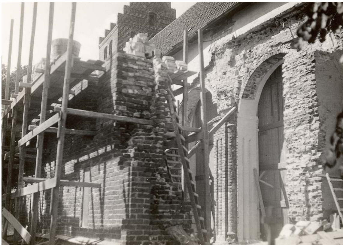
Fig. 38. Søndre korsarms genopførelse. Foto 1929 i privat eje. – Re-erection of south transept, 1929.
