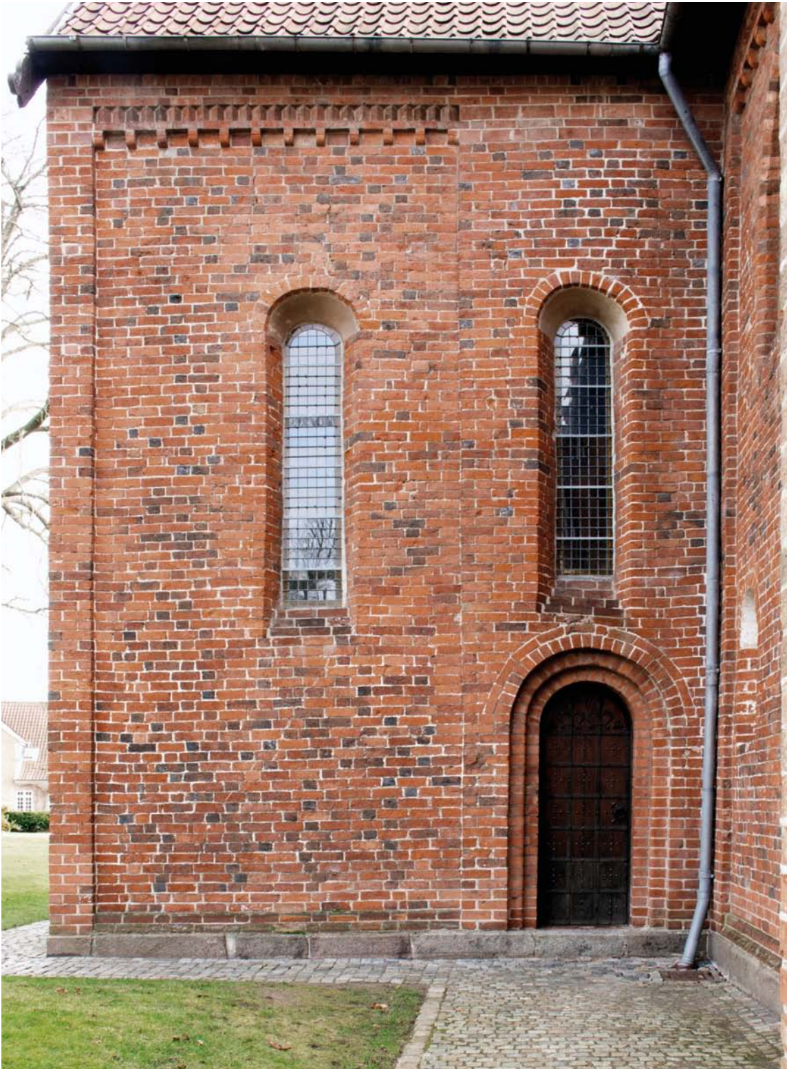
Fig. 12. Præstedøren i nordre korsarm (s. 2806). Foto David Burmeister Kaaring 2014. – Priest's door in north transept.
