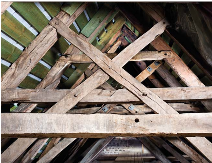
Fig. 78. Skibets tagværk set mod øst (s. 2930). Foto Arnold Mikkelsen 2013. – Roofing of church looking east.
