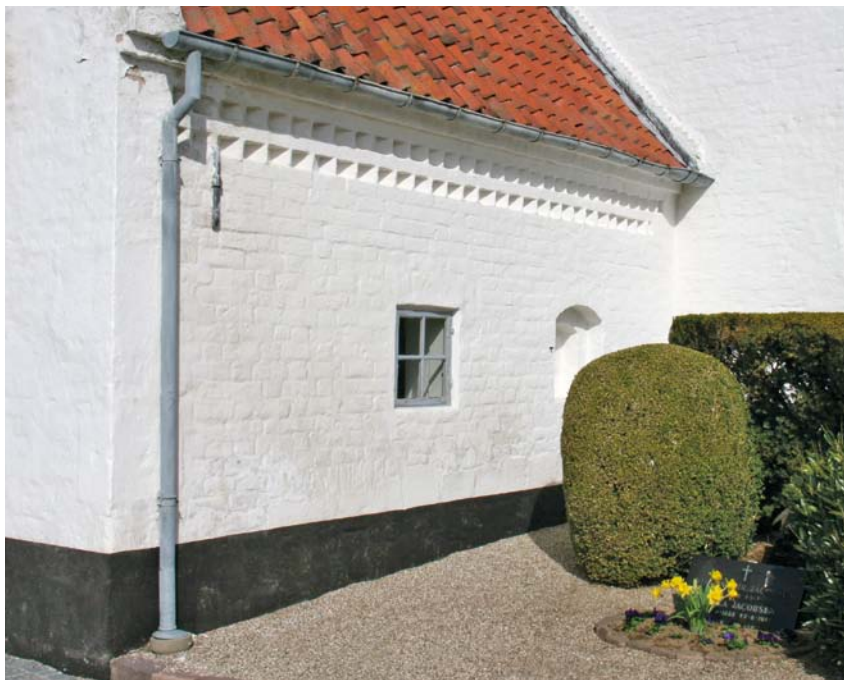
Fig. 76. Våbenhusets østmur (s. 2929). Foto Martin Wangsgaard Jürgensen 2013. – East wall of porch.
