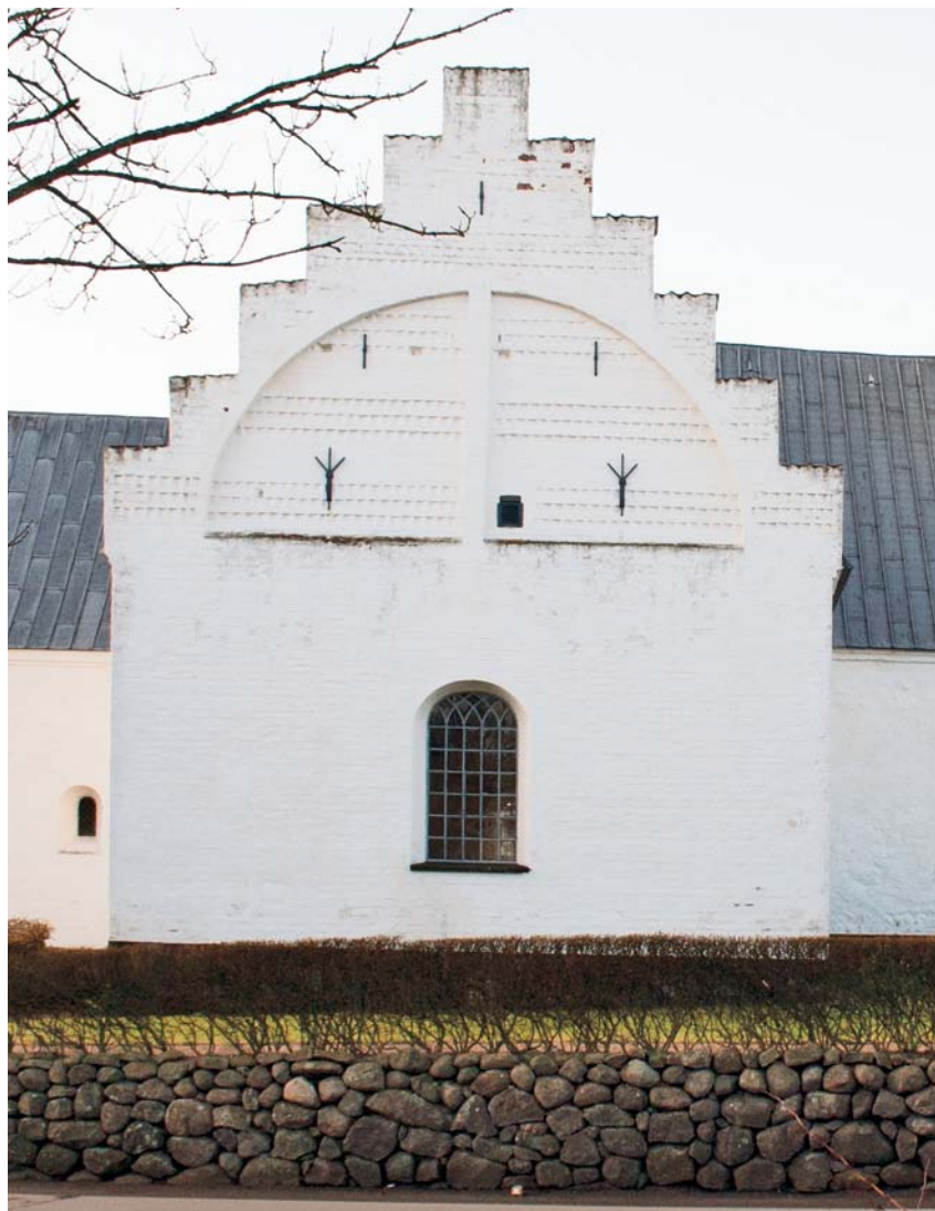
Fig. 15. Nordre korsarm (s. 2928). Foto Mogens Vedsø 2014. – North transept.
