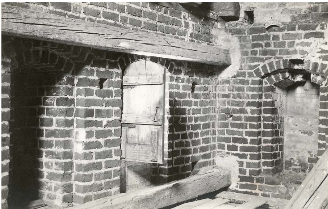
Fig. 12. De falsede glamhuller i tårnets klokkestokværk set mod nordøst (s. 2924). Foto Waahlin 1926. – The rabbeted belfry lights in the tower, looking north east.
