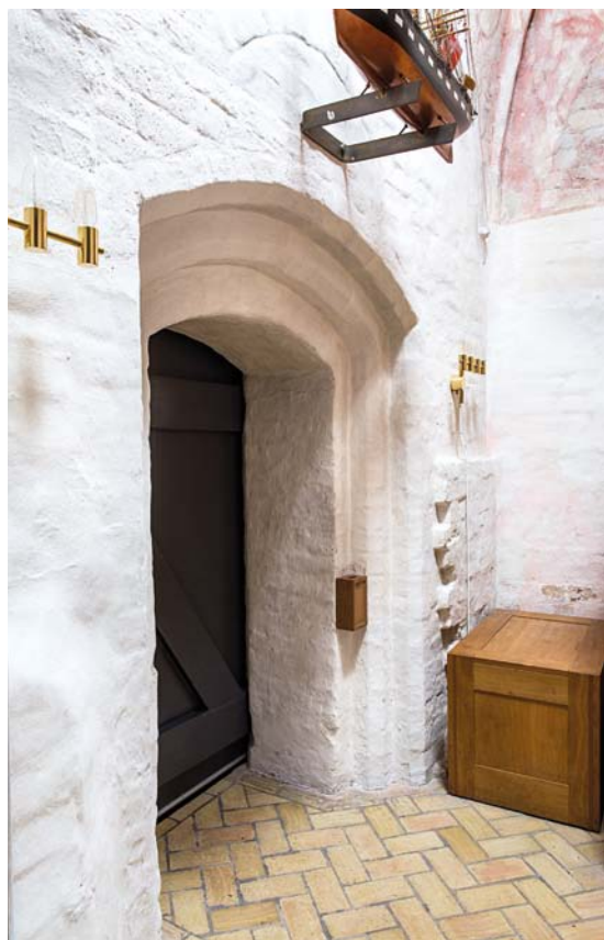
Fig. 15. Den sekundære dør i tårnets sydside (s. 3054). Bemærk det ældre blændede vindue over døren (s. 3049). Foto Arnold Mikkelsen 2014. – The secondary door in the south side of the tower. Note the older bricked-up window above the door.
