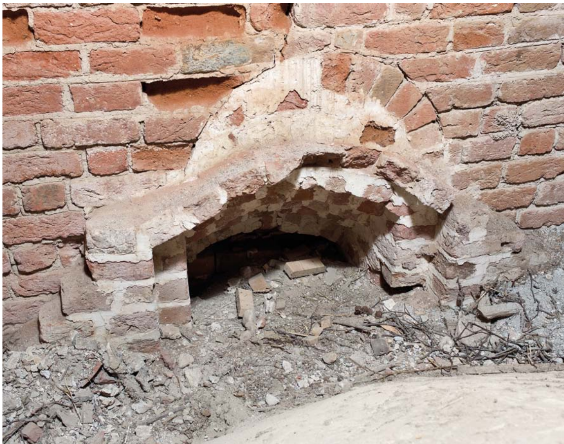
Fig. 16. Blændet romansk (†)vindue (s. 3048) og ligeledes blændet sengotisk (†)dør i tårnets nordmur (s. 3049). Foto Arnold Mikkelsen 2014. – Bricked-up Romanesque (†)window and similarly bricked-up Late Gothic (†)door in north wall of tower.
