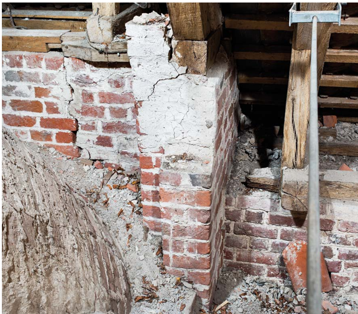
Fig. 17. Sammenstødet mellem kor og skib, nordsiden, over kirkens hvælv (s. 3049). Foto Arnold Mikkelsen 2014. – Meeting of chancel and nave, north side, above the vaulting of the church.
