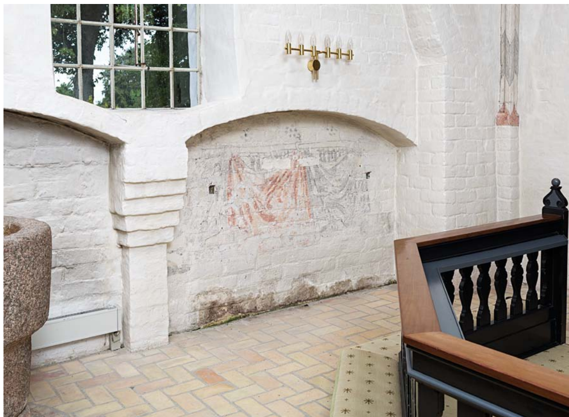
Fig. 9. Fladbuede nicher i korets nordside med kalkmalet baldakin udført 1496 (s. 3051, 3061). Foto Arnold Mikkelson 2014. – Flat-arched niches in north side of chancel with wall-painted baldachin, 1496.
