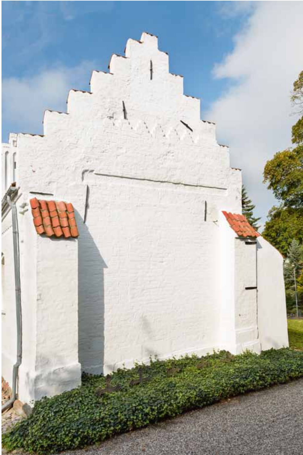
Fig. 5. Korets østgavl set fra sydøst. Foto Arnold Mikkelsen 2014. – East gable of chancel seen from the south east.
