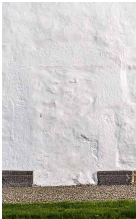
Fig. 8. Tilmuret norddør (s. 3309). Foto Arnold Mikkelson 2014. – Bricked-up north door.
