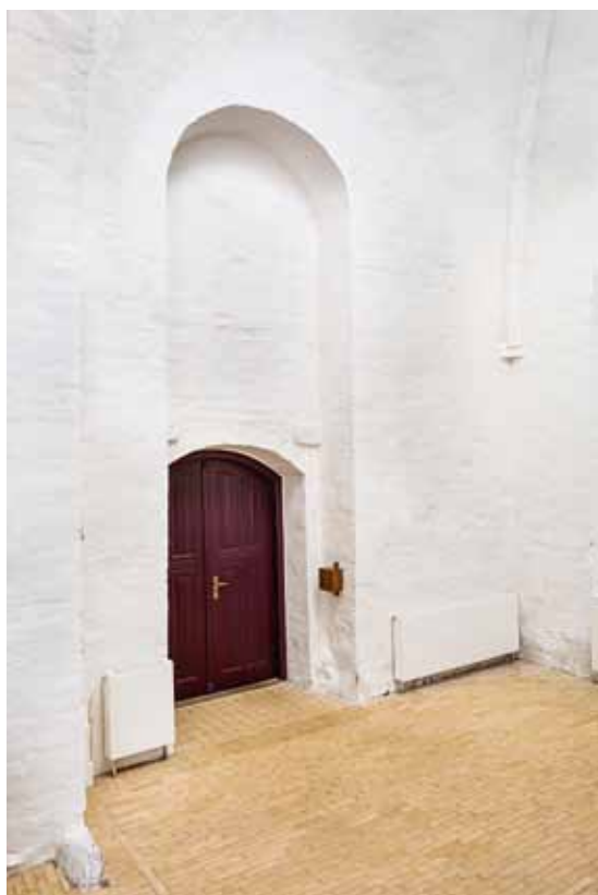
Fig. 12. Tårnets syddørs inderside set mod sydvest (s. 3311). Foto Arnold Mikkelsen 2014. – Inside of south door looking south west.
