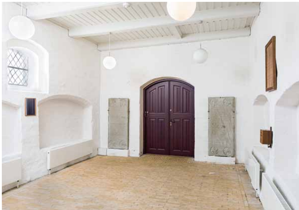
Fig. 14. Våbenhusets indre (s. 3319) set mod syd. Foto Arnold Mikkelsen 2014. – Interior of porch looking south.
