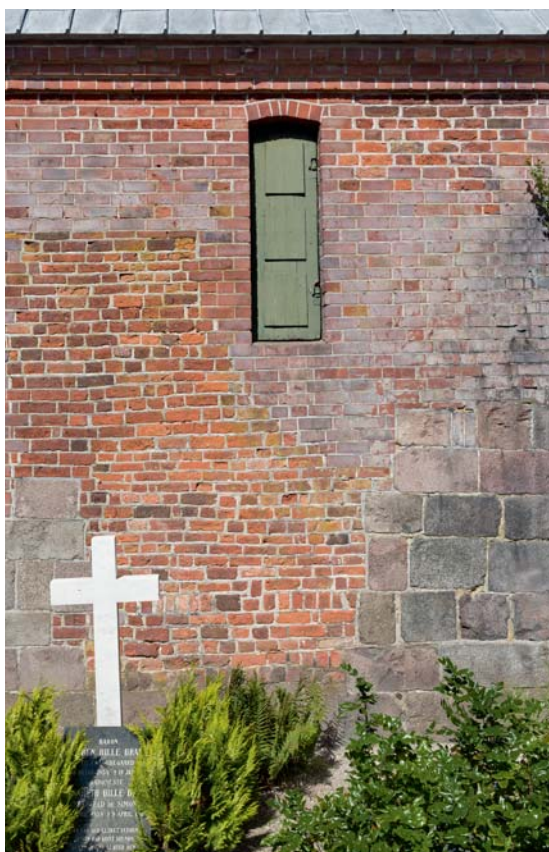
Fig. 10. Højtsiddende dør til skibets loftsrum i vestforlængelsens sydmur (s. 3524). Foto Arnold Mikkelsen 2015. – High-placed door to loft of nave in south wall of western extension.
