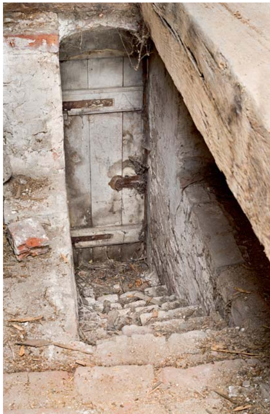
Fig. 11. Dør til skibets loftsrum i vestforlængelsen (s. 3524). Set mod syd. Foto Arnold Mikkelsen 2015. – Door to nave loft in western extension, looking south.
