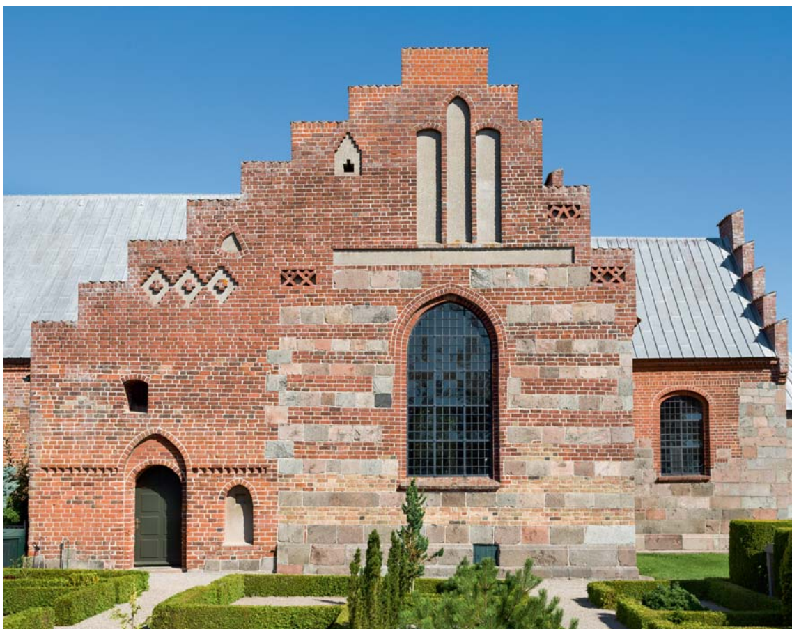
Fig. 13. Søndre korsarm sammenbygget med våbenhuset (s. 3522). Foto Arnold Mikkelsen 2015. – South transept built together with porch.
