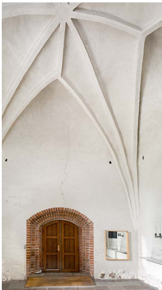
Fig. 22. Tårnrum og tårnrummets hvælv (s. 3528). Foto Arnold Mikkelsen 2015. – Tower interior and tower vault.
