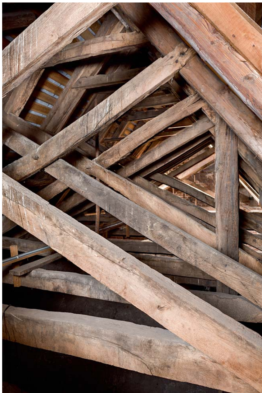
Fig. 26. Skibets tagværk (s. 3538). Foto Arnold Mikkelsen 2015. – Roofing of nave.
