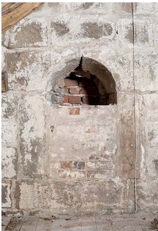
Fig. 7. Blændet romansk vindue i skibets sydmur (s. 3521). Foto Arnold Mikkelsen 2015. – Bricked-up Romanesque window in south wall of nave.
