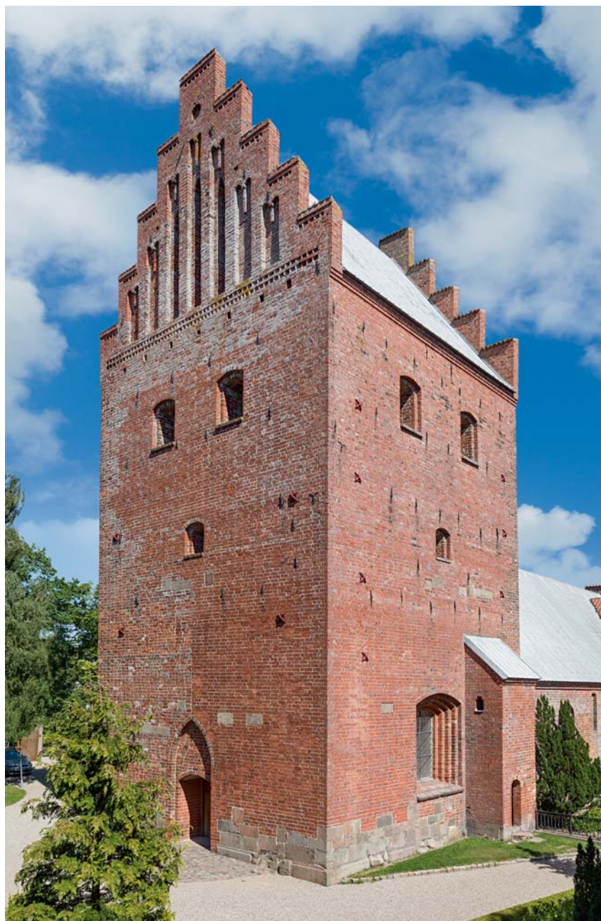
Fig. 20. Tårnet set fra sydvest (s. 3528). Foto Arnold Mikkelsen 2015. – Tower seen from the south west.
