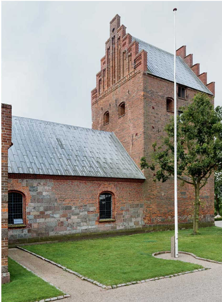
Fig. 19. Vestforlængelse (s. 3523) af skibet og tårn (s. 3528) set mod sydvest. Foto Arnold Mikkelsen 2015. – West extension of nave and tower looking south west.
