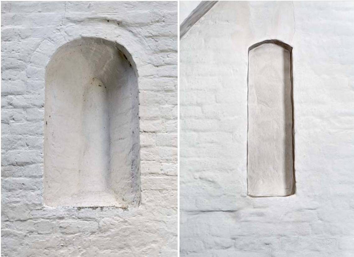
Fig. 11–12. Blændet vindue vestligst i skibets nordside (s. 3617). 11. Ydre. 12. Indre. Foto Arnold Mikkelsen 2015. – Bricked-up window in north side of nave. 11. Exterior. 12. Interior.
