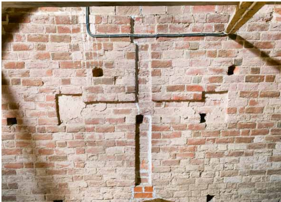
Fig. 11. Korsblænding på det romanske skibs vestgavl (s. 3705). Foto Arnold Mikkelsen 2015. – Cross recess on west gable of Romanesque nave.
