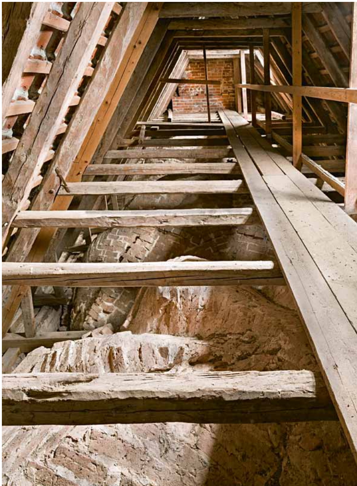
Fig. 18. Skibets tagværk set mod øst (s. 3727). Foto Arnold Mikkelsen 2015. – Roofing of nave looking east.
