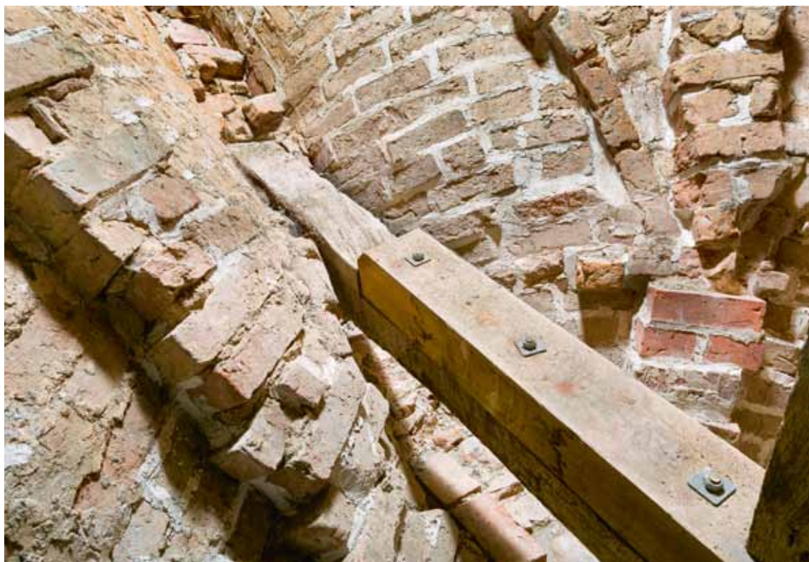
Fig. 99. Bindbjælke i skibet mellem 2. og 3. Hvælvfag. (s. 3729). Foto Arnold Mikkelsen 2015. – Tie beam in nave between 2nd and 3rd vault bay.
