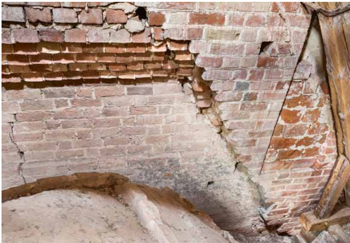
Fig. 31. Det romanske skibs vestgavls indre samt udkragning til tårnets østmur (s. 3709). Til højre tilmuret glamhul. Foto Arnold Mikkelsen 2016. – Inside of west gable of Romanesque nave and corbelling to east wall of tower. Right: bricked-up belfry light.
