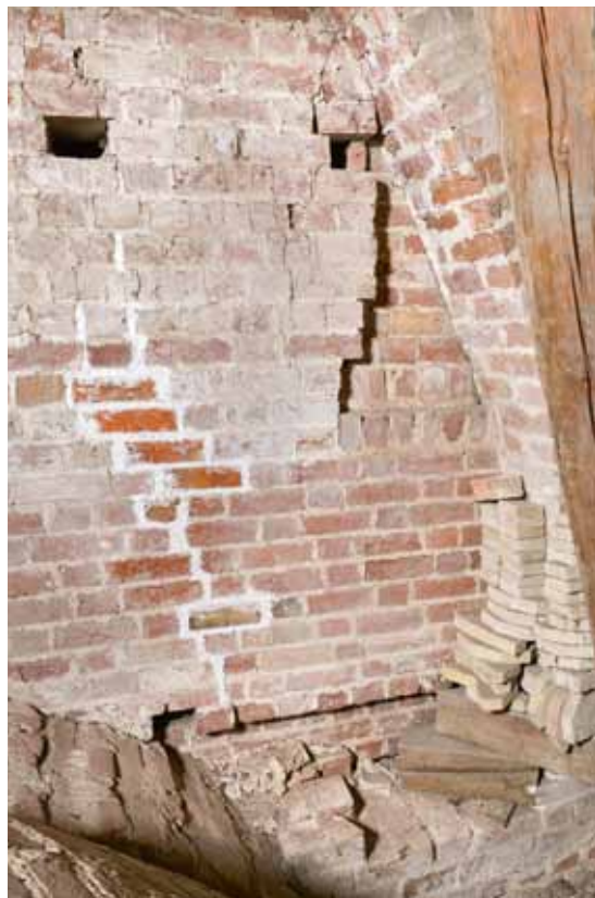
Fig. 102. Detalje af sydvæg i tårnets mellemstokværk set mod sydvest med skalmur og del af tilmuret glamhul (s. 3711). Foto Arnold Mikkelsen 2015. – Detail of south wall on middle floor of tower looking south west with facing and part of bricked-up belfry light.
