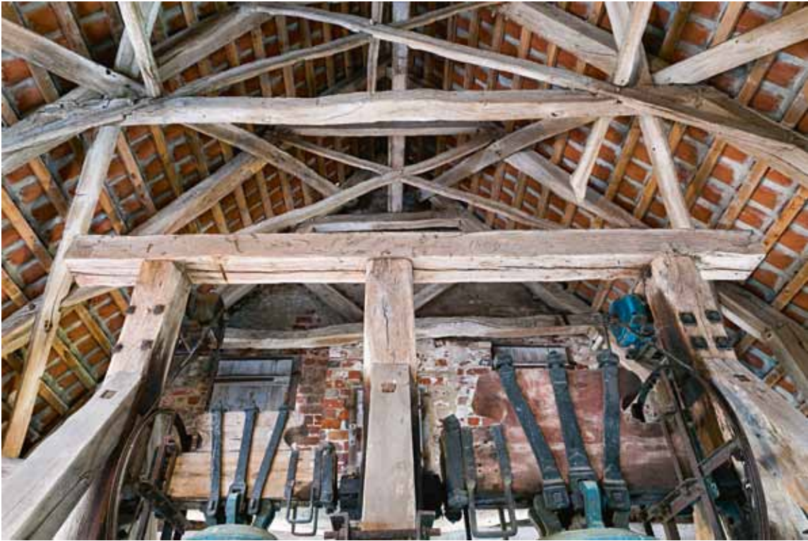
Fig. 29. Klokkestokværkets tagværk set mod vest (s. 3727), med klokkestol fra 1866 (s. 3728). Foto Arnold Mikkelsen 2015. – Roofing of belfry floor looking west, with bell frame from 1866.
