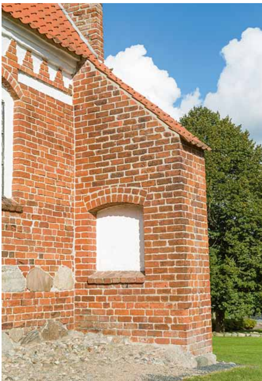
Fig. 25. Støttepille med niche på skibets sydøsthjørne set fra sydvest (s. 3722). Foto Arnold Mikkelsen 2015. – Buttress with niche on south west corner of nave, seen from the south west.
