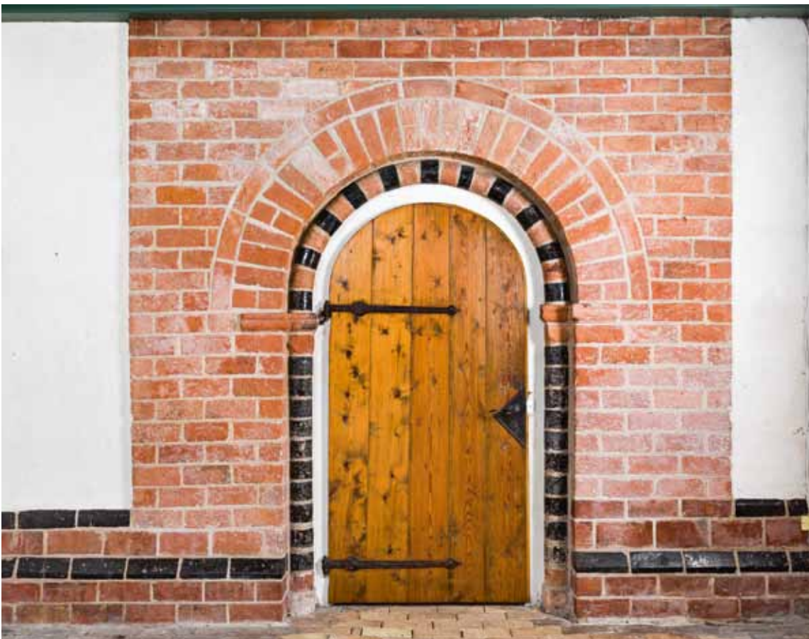
Fig. 10. Det romanske skibs syddør med portalfremspring (s. 3705), set fra syd. Foto Arnold Mikkelsen 2015. – South door of Romanesque nave with portal projection.
