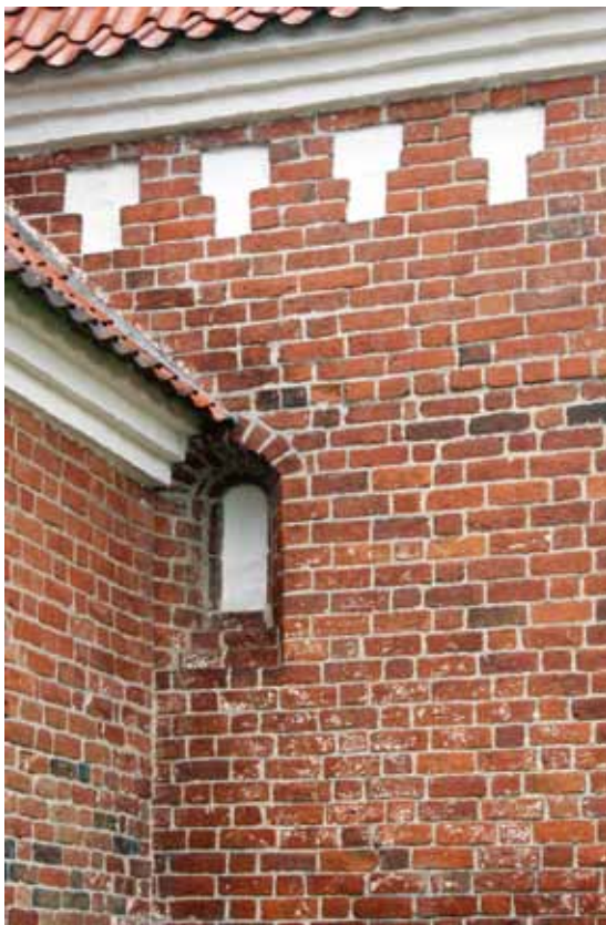
Fig. 97. Skibets sydmur med romanske vindue (s. 3706); herover forhøjelse med blændingsfrise (s. 3711). Foto Kirstin Eliassen 2016. – South wall of nave with Romanesque window; above it the heightening with recess frieze.
