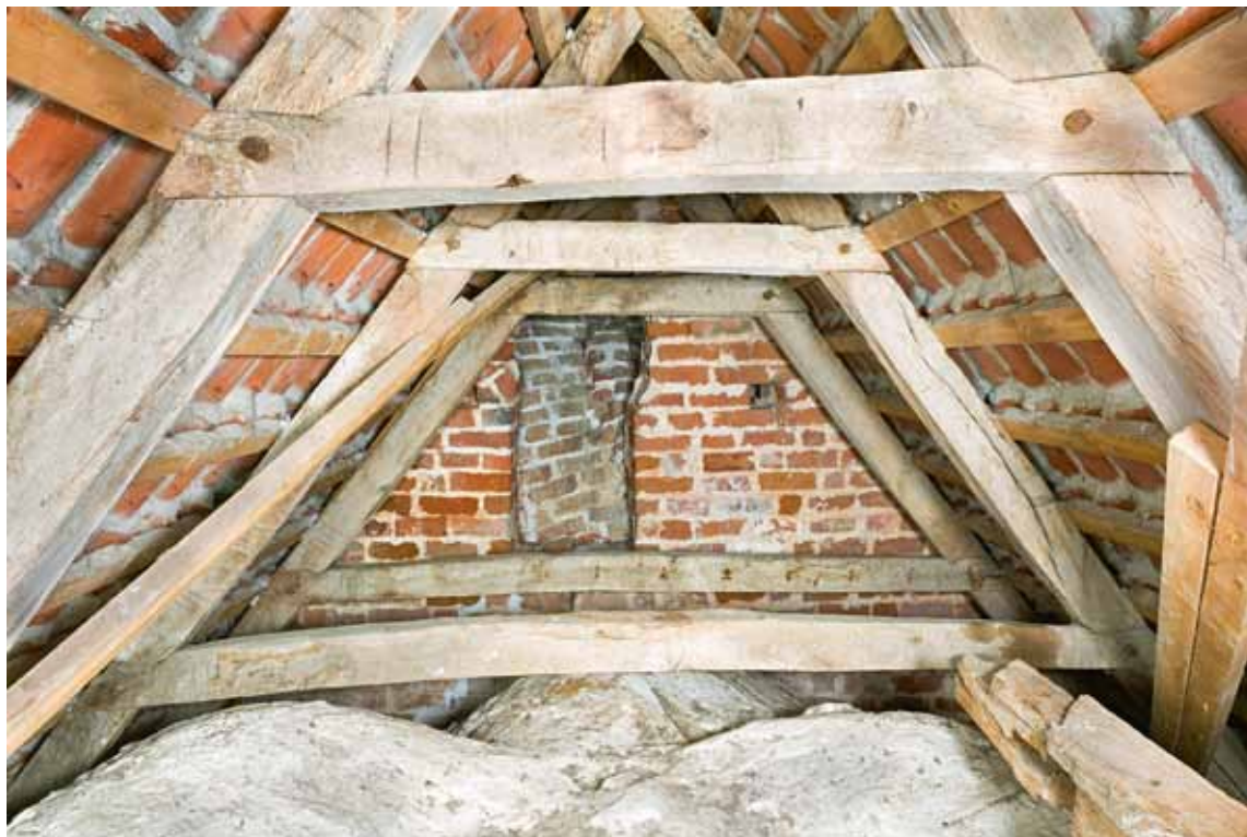
Fig. 28. Korets tagværk set mod vest (s. 3727). I baggrunden åbning mellem kor og skib (jf. fig. 98) Foto Arnold Mikkelsen 2015. – Roofing of chancel looking west. In the background opening between chancel and nave (cf. fig. 98).
