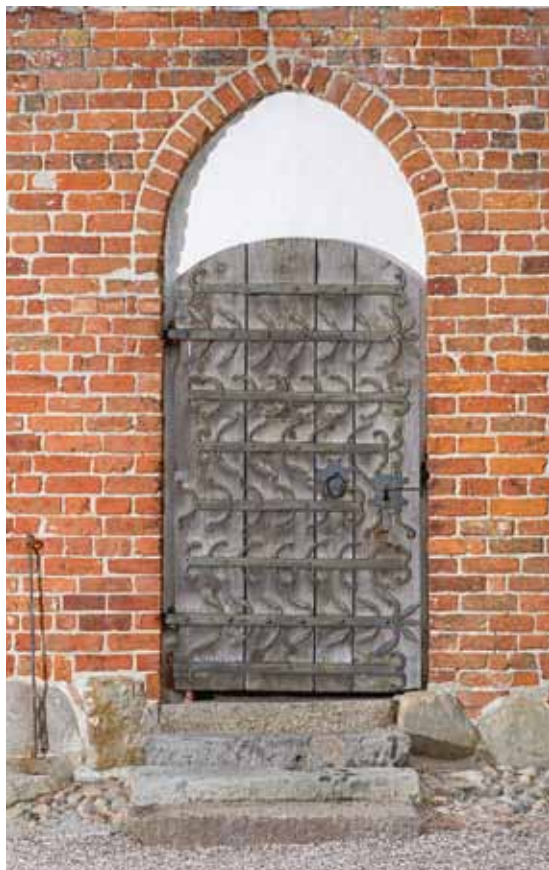
Fig. 79. Dør i våbenhusets sydside (s. 3708), dørfløj nr. 1 (s. 3761). Foto Arnold Mikkelsen 2015. – Door in south side of porch, door wing no. 1.
