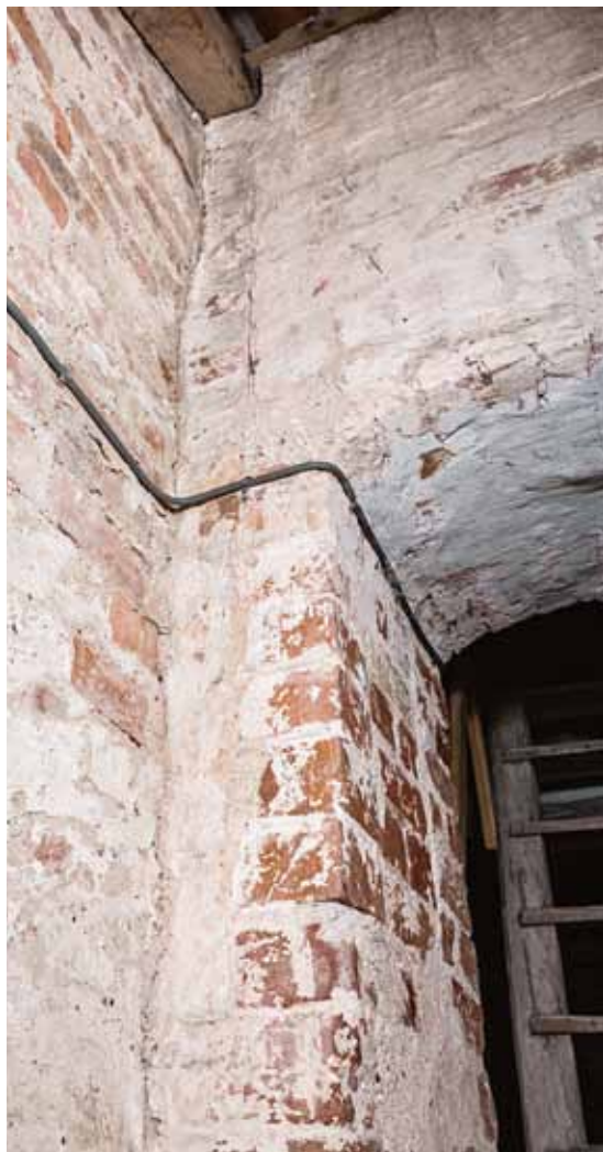
Fig. 101. Indgang til tårnets mellemstokværk gennem tilmuring af glamhul (s. 3718). Foto Arnold Mikkelsen 2015. – Entrance to middle floor of tower through bricked-up belfry light.
