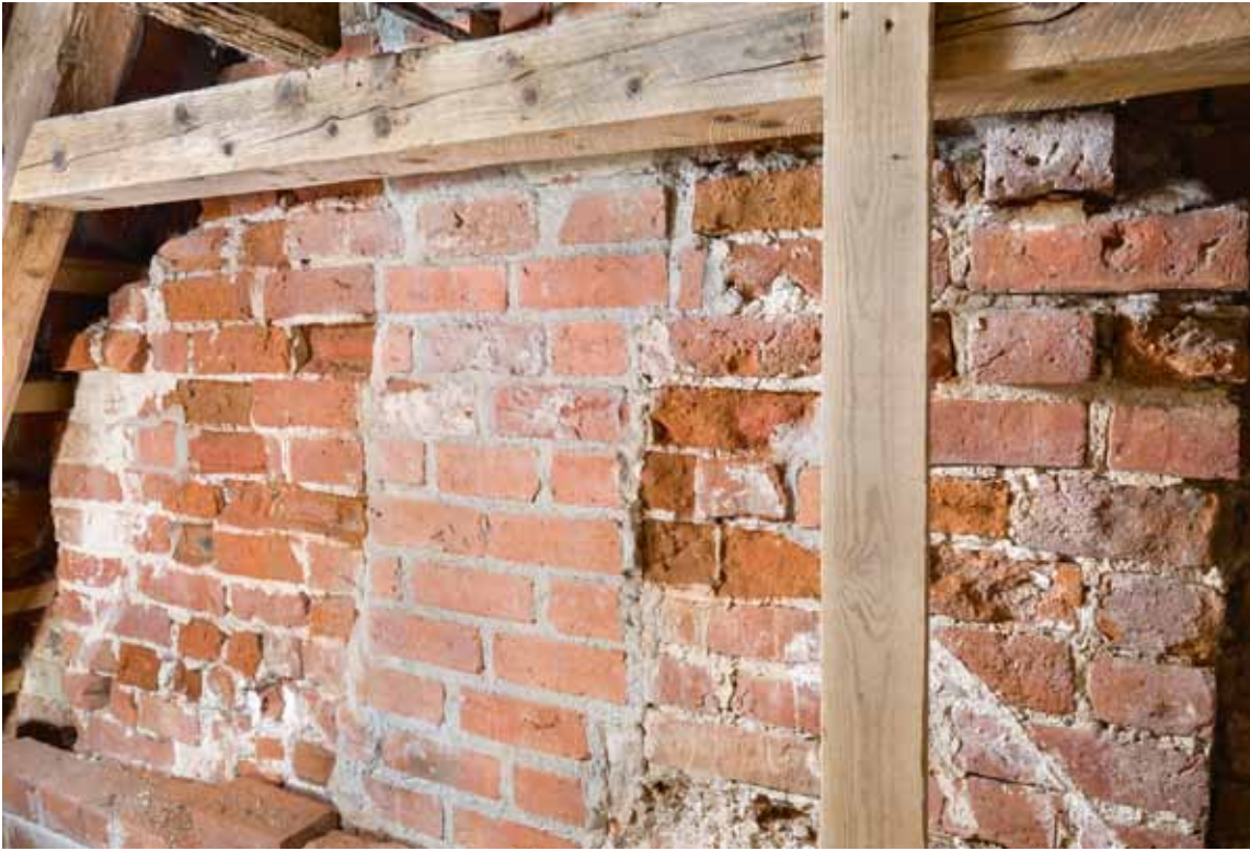
Fig. 100. Det senmiddelalderlige skibs østforlængelses gavl med toptinde med spor af konsoller til bæring af en klokkekam (s. 3714). Foto Arnold Mikkelsen 2016. – Gable of eastern extension of Late Medieval nave with merlon and traces of brackets for a bell cot.
