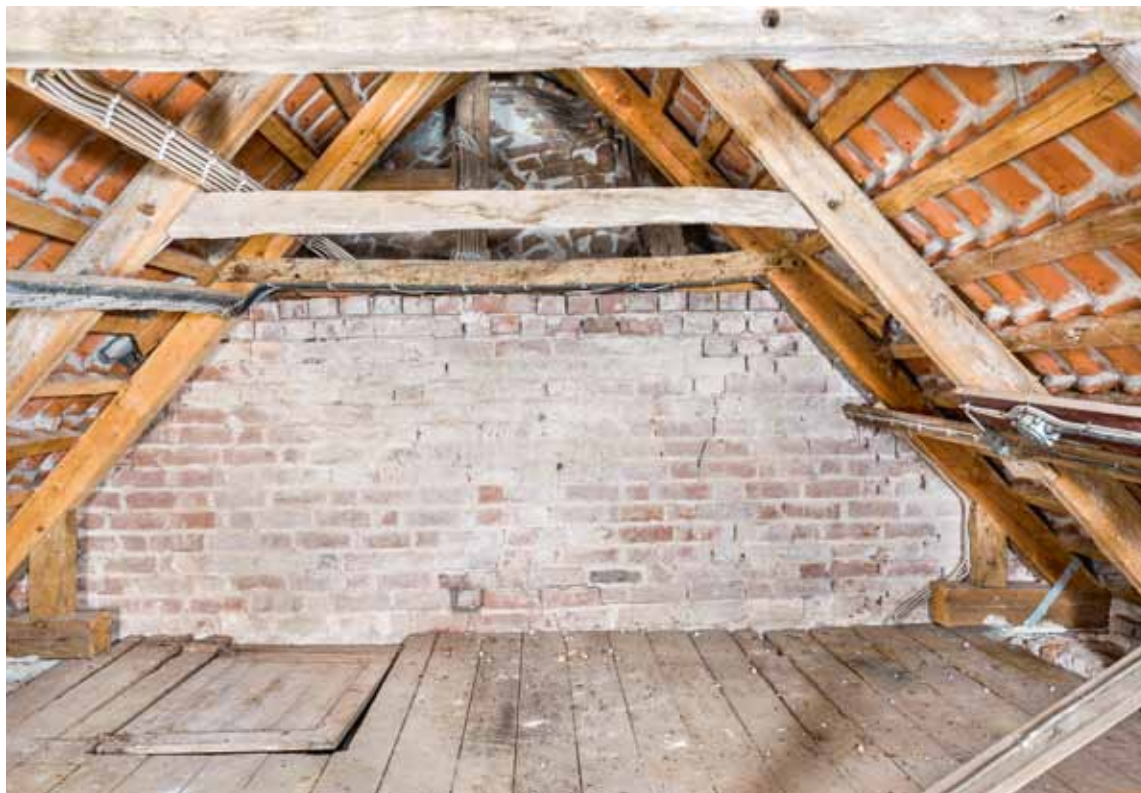
Fig. 30. Våbenhusets tagværk (s. 3728) samt overmuren af det forhøjede skib (s. 3711), set mod nord. Foto Arnold Mikkelsen 2015. – Roofing of porch and upper wall of heightened nave, looking north.
