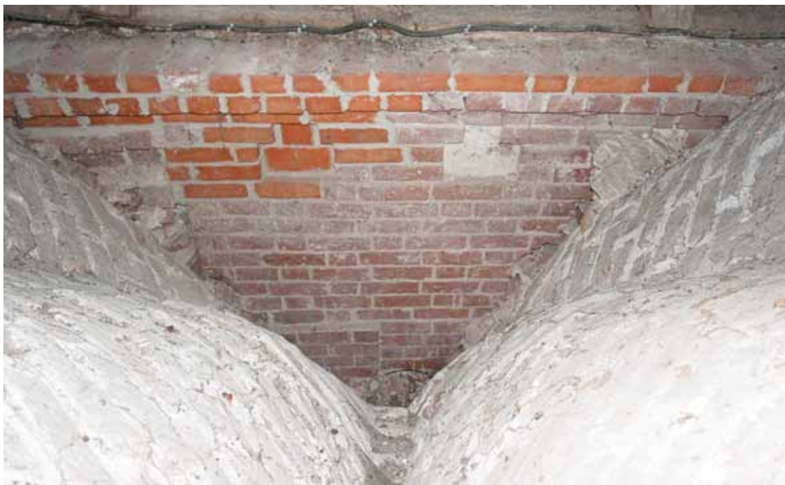
Fig. 96. Skibets nordmur set fra nordkappellets loftsrums. I bunden af hvælvlokken ses den nordøstre, romanske hjørnelisen (s. 3700); herover (th.) skibets forhøjelse med blændingsfrise (s. 3711) og skibets østforlængelse (tv.) med båndblending (s. 3713). Foto Mogens Vedsø 2016. – North wall of nave seen from loft of north chapel. At the bottom of the vault pocket, the northeastern Romanesque corner pilaster; above it the heightening of the nave with recess frieze.
