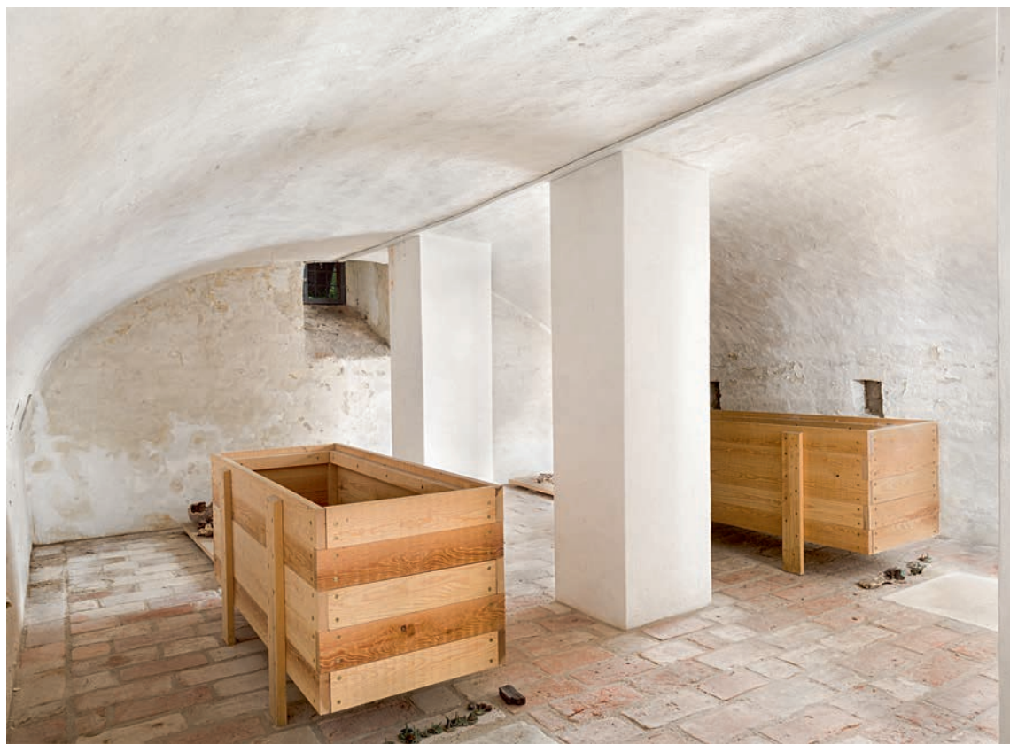
Fig. 11. Krypten under koret (s. 4027), set mod sydøst Foto Arnold Mikkelsen 2016. – The crypt beneath the chancel looking south east.
