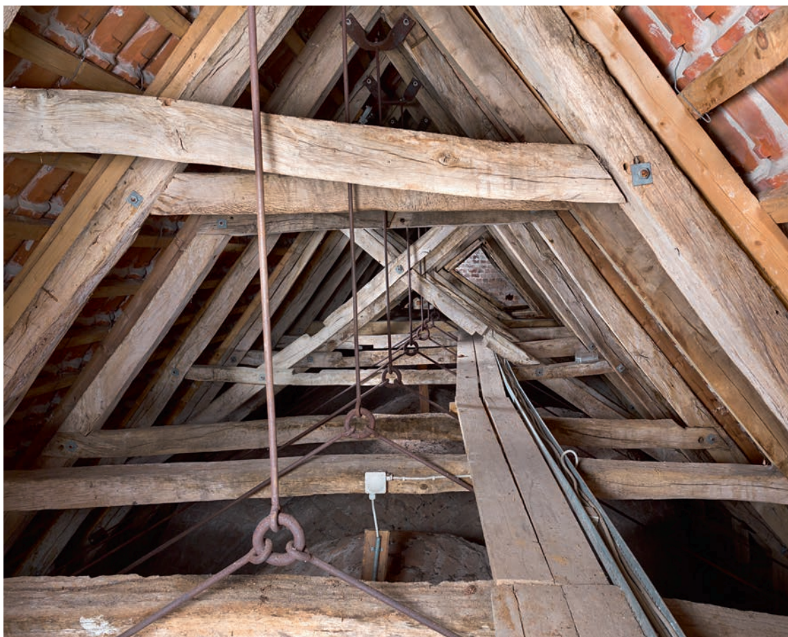
Fig. 12. Langhusets tagværk set mod øst (s. 4030). Foto Arnold Mikkelsen 2016. – Roofing of nave looking east.
