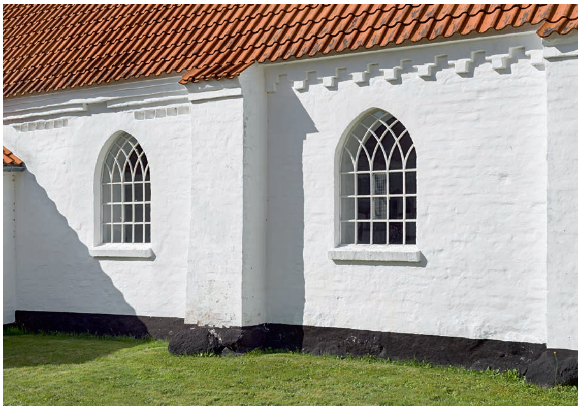
Fig. 7. Skellet mellem skib og langhuskor. Foto Arnold Mikkelsen 2016. – Boundary between nave and nave-chancel.
