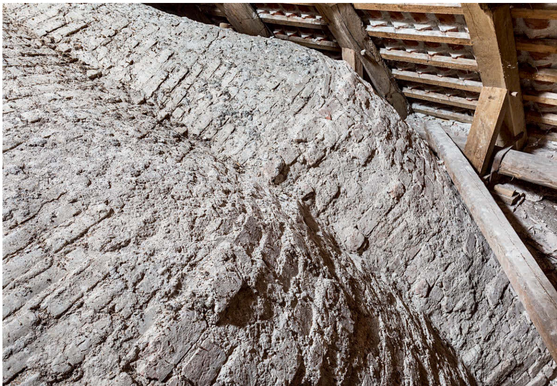
Fig. 17. Skibets vestre hvælv (s. 4087) med ommuring. Foto Arnold Mikkelsen 2016. – Western vault of nave with renovation.
