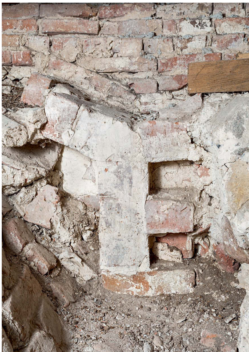
Fig. 62. Senmiddelalderligt vindue (s. 4088) i skibets sydmur set fra skibets tagrum. Foto Arnold Mikkelsen 2016. – Late medieval window in south wall of nave, seen from nave loft.
