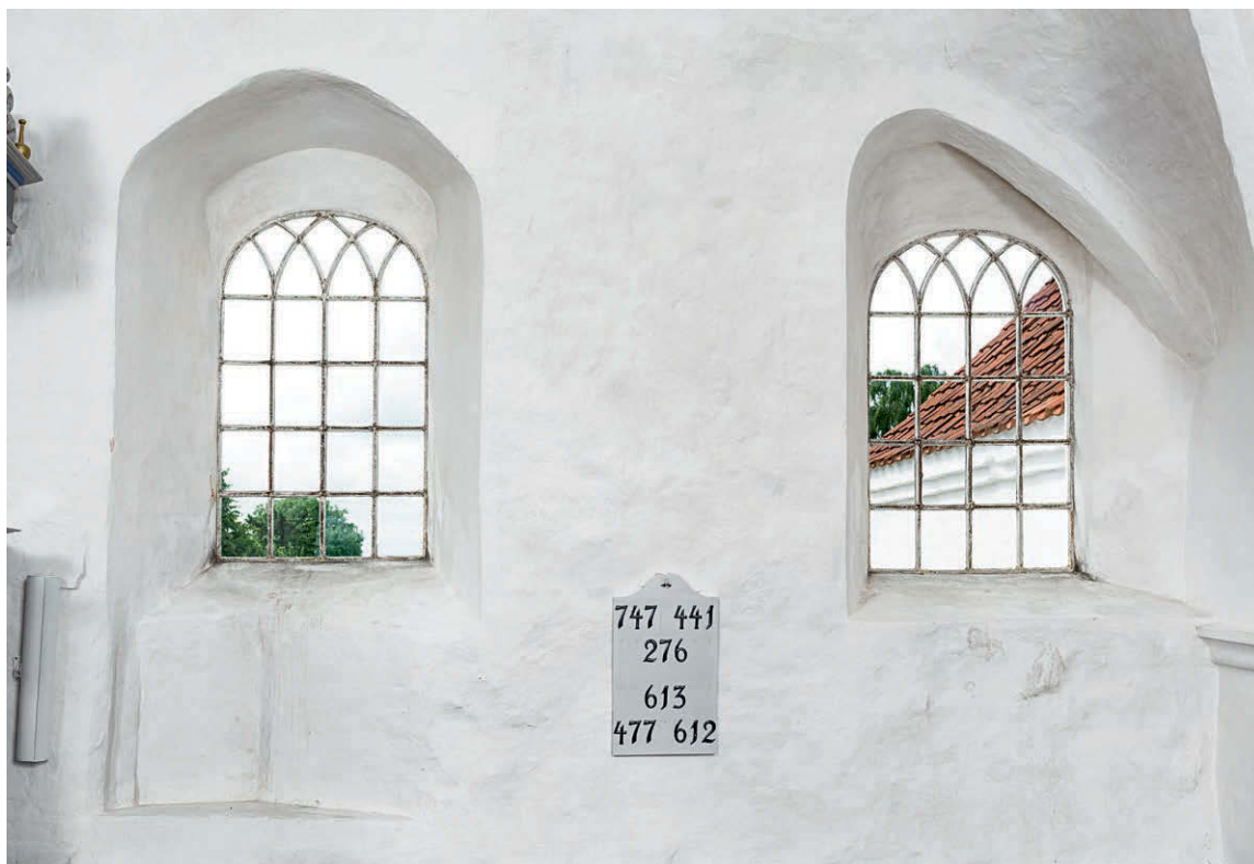
Fig. 18. Skibets sydvinduer, inderside. Foto Arnold Mikkelsen 2016. – South windows of nave, inside.
