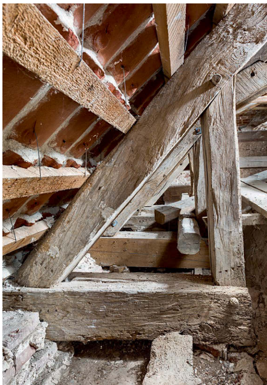
Fig. 22. Skibets tagværk. 4. spærfag; spær, spærstiver og spærfod med nummerering (s. 4090). Foto Arnold Mikkelsen 2016. – Roofing of nave. 4. Truss; rafter, post and rafter foot with numbering.
