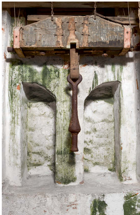
Fig. 14. Glug under glamhullet i klokkestokværkets nordside (s. 4083). Foto Arnold Mikkelsen 2016. – Peephole beneath belfry light in north side of belfry floor.
