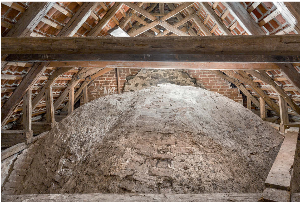
Fig. 60. Korets tagværk (s. 4090) og hvælv (s. 4079) set mod øst. Foto Arnold Mikkelsen 2016. – Roofing and vault of chancel.
