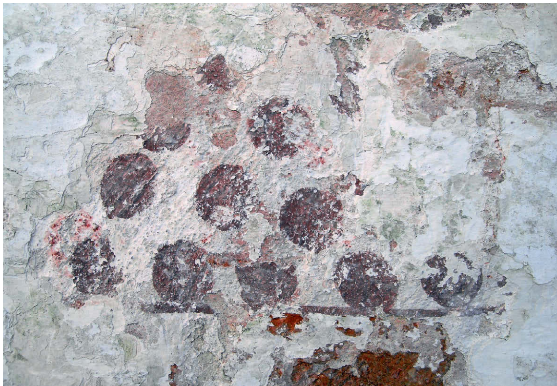
Fig. 24. Bemaling af tårnet (s. 4092). Foto Bent Longmose Jakobsen 2008. – Paintwork in tower.
