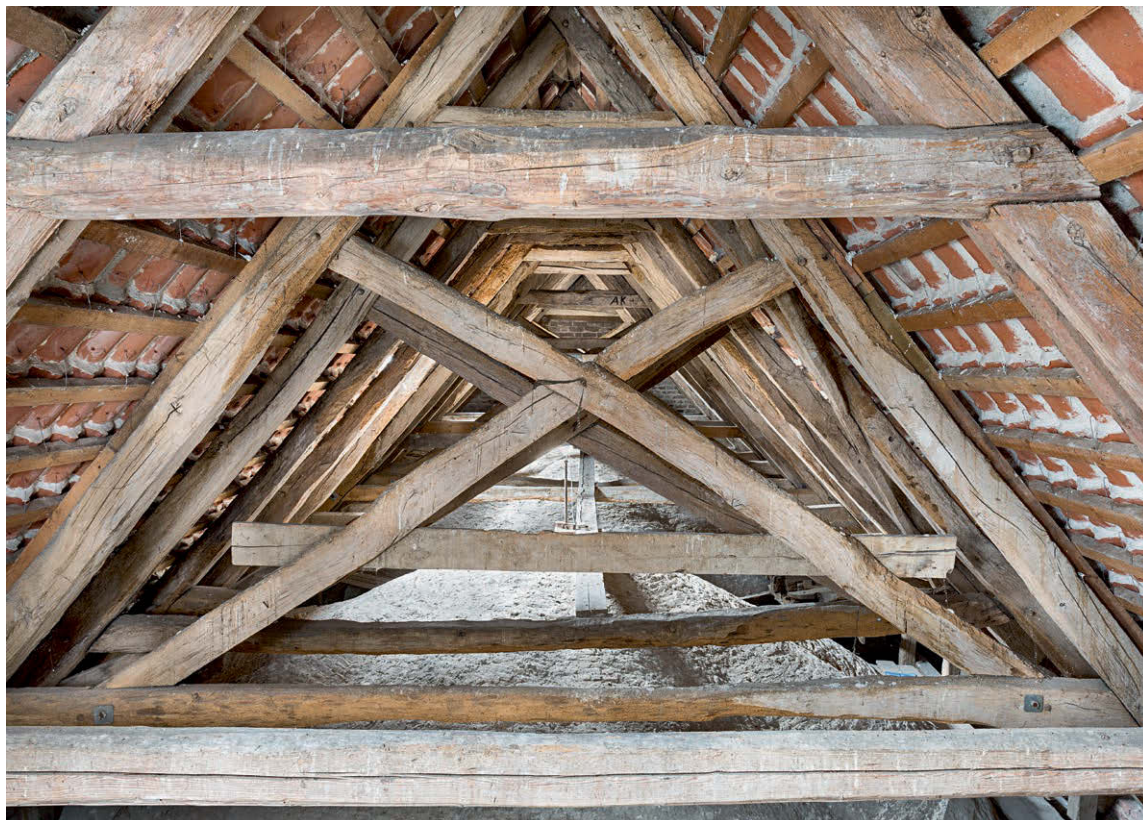
Fig. 21. Skibets tagværk (s. 4090) set mod vest. Foto Arnold Mikkelsen 2016. – Roofing of nave looking west.
