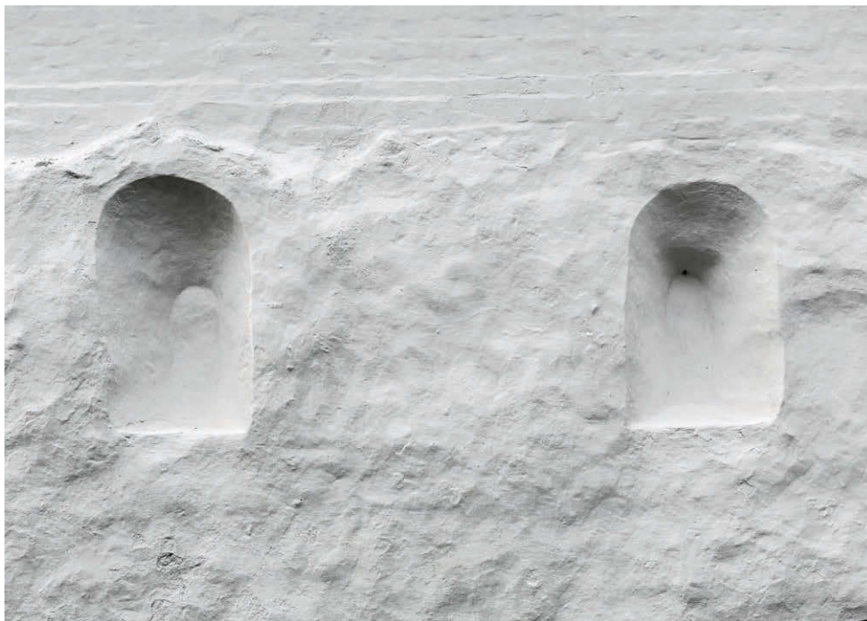
Fig. 9. Romanske \uparrow vinduer i korets nordside (s. 4197). Foto Arnold Mikkelsen 2016. – Romanesque \uparrow windows in the north side of the chancel.
