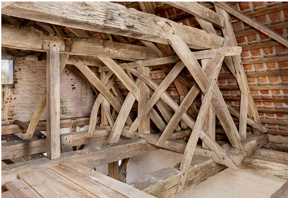
Fig. 26. Middelalderlig klokkestol (s. 4211), detalje set fra sydvest. Foto Arnold Mikkelsen 2016. – Medieval bell frame, detail seen from south west.
