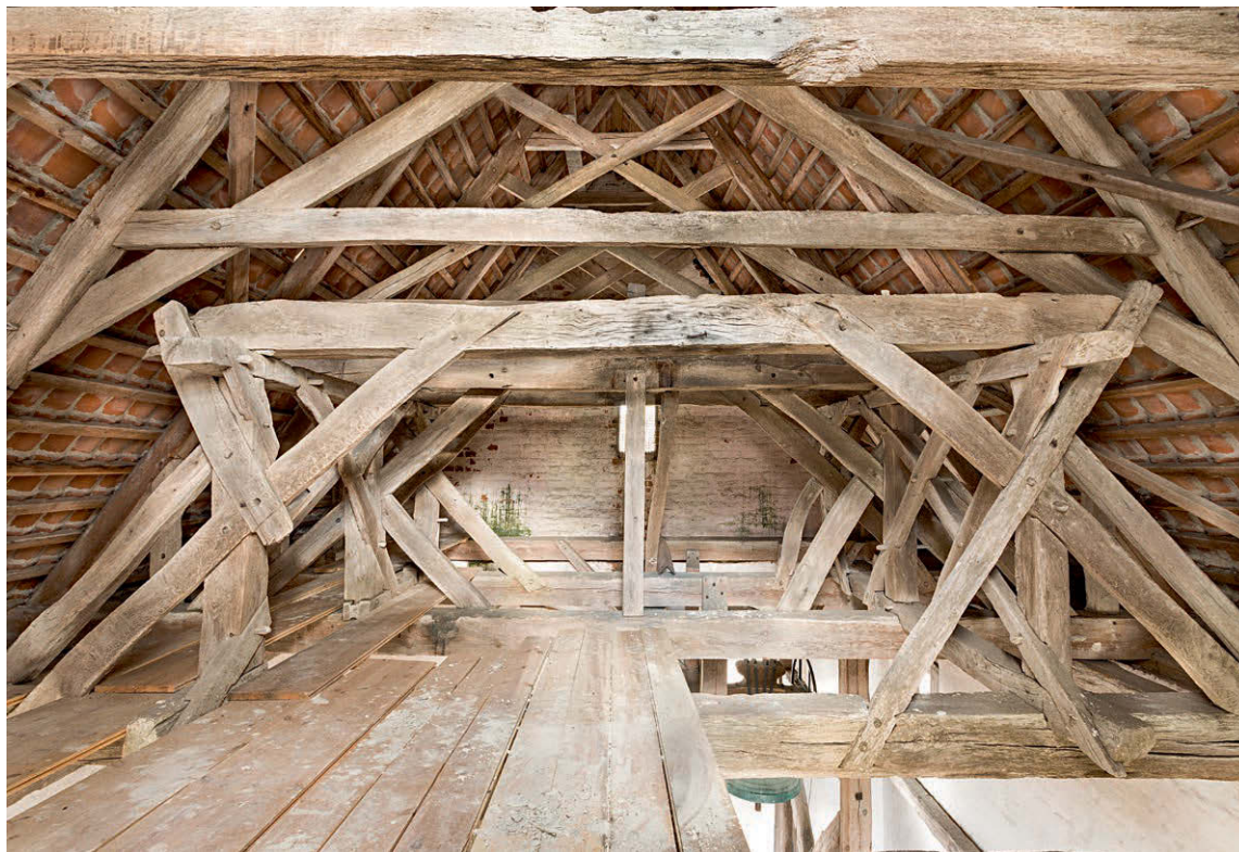
Fig. 25. Middelalderlig klokkestol (s. 4211) set fra syd. Foto Arnold Mikkelsen 2016. – Medieval bell frame seen from the south.
