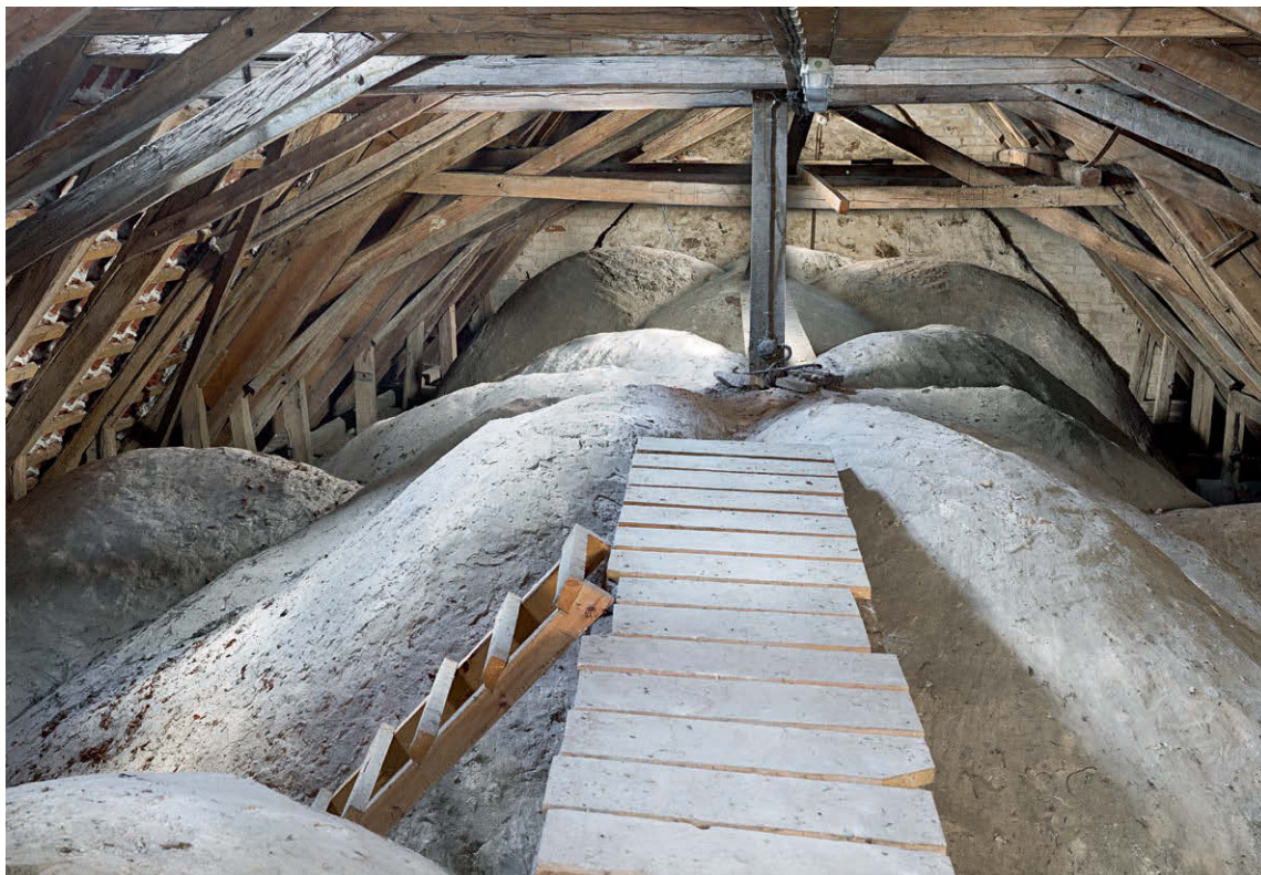
Fig. 28. Skibets hvælv (s. 4205) set mod øst. Foto Arnold Mikkelsen 2016. – Vault of the nave looking east.
