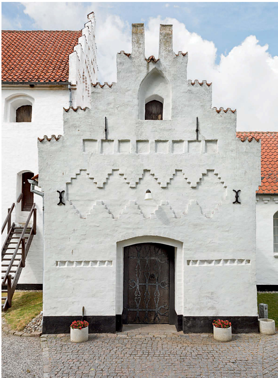
Fig. 10. Våbenhuset set fra syd (s. 4271). Foto Arnold Mikkelsen 2016. – The porch seen from the south.
