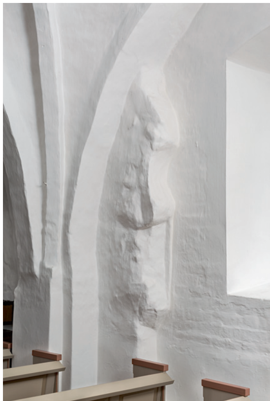
Fig. 12. Sammenstødet i sydsiden mellem skibets vestende og vestforlængelsen (s. 4489). Foto Arnold Mikkelsen 2017. – The meeting in the south side between the western end of the nave and the western extension.
