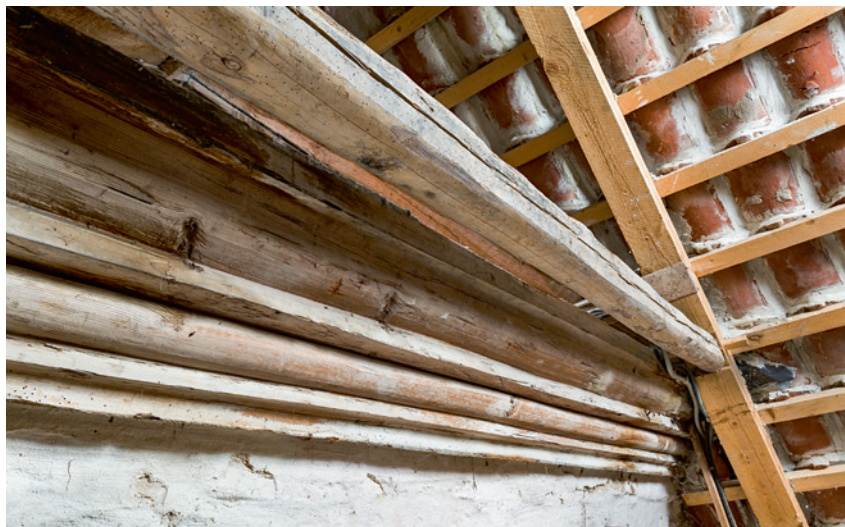
Fig. 17. Trægesims i fyr set fra våbenhusets loftsrums (s. 4497). Foto Arnold Mikkelsen 2017. – Timbered pine cornice.
