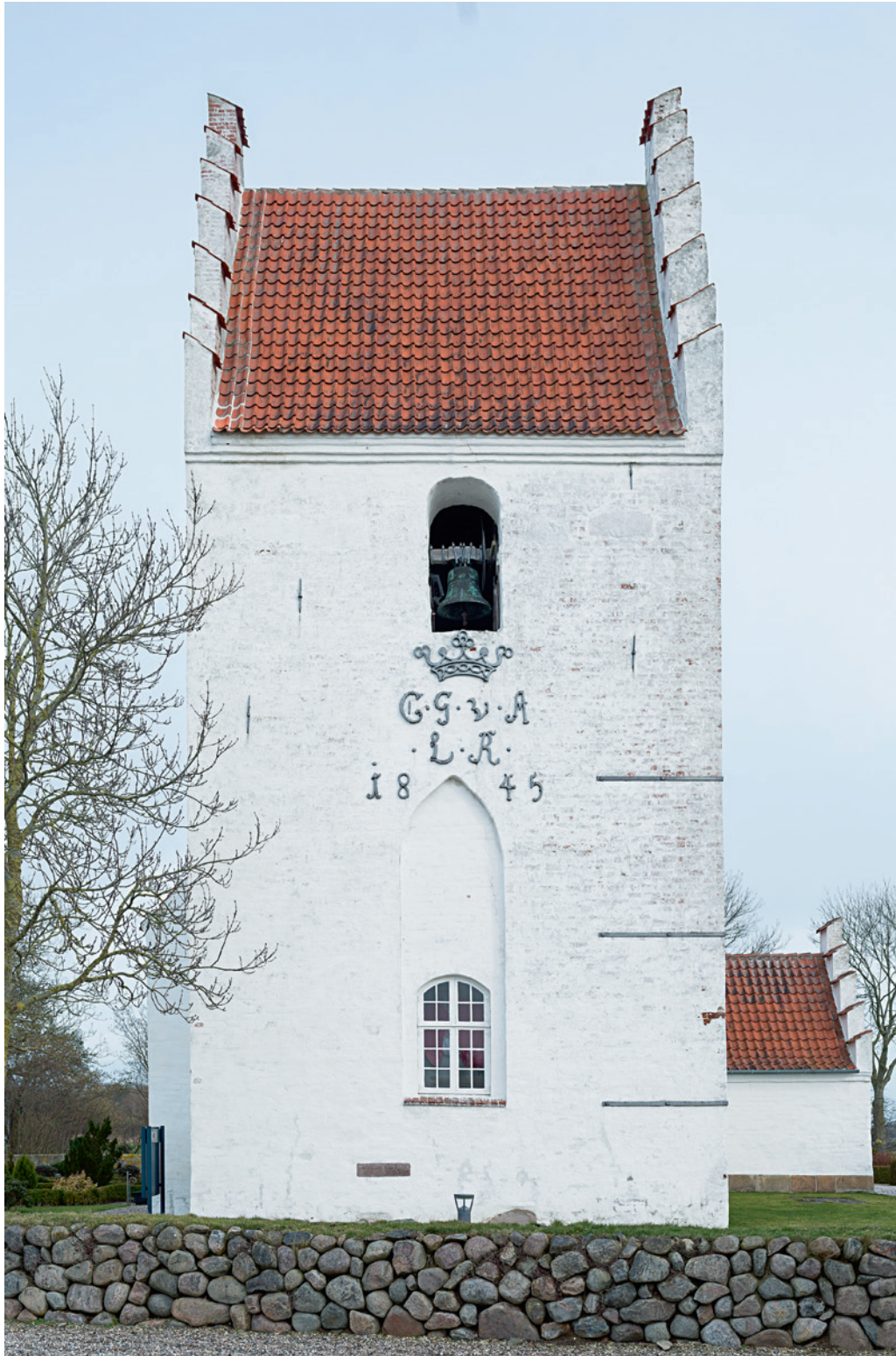
Fig. 14. Tårnet set fra vest (s. 4492). Foto Arnold Mikkelsen 2017. – The tower seen from the west.
