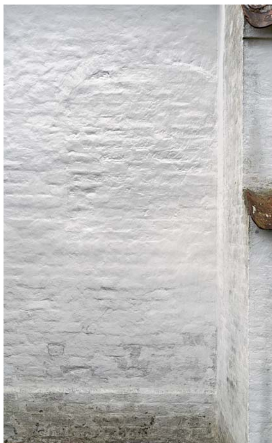
Fig. 64. †Vindue i vestforlængelsens nordside (s. 4529). Foto Arnold Mikkelsen 2017. – †Window in the north facade of the western extension.
