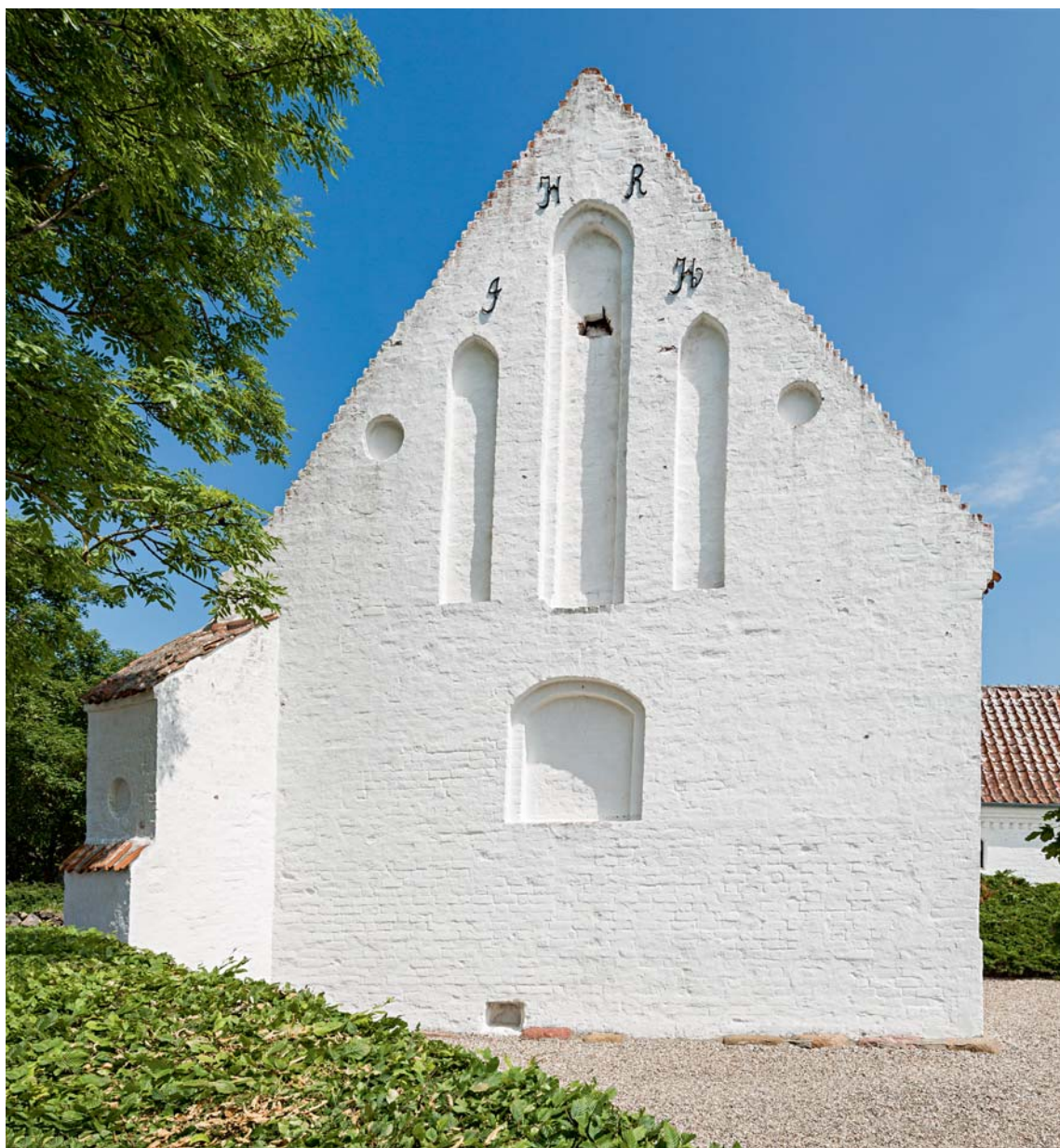
Fig. 20. Vestforlængelsens vestgavl (s. 4533). Foto Arnold Mikkelsen 2017. – West gable of western extension.
