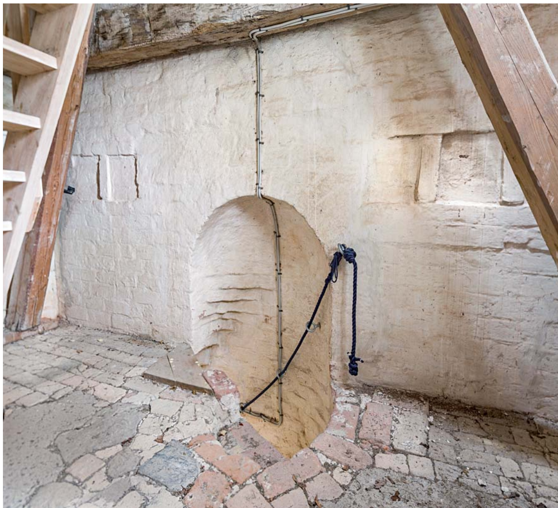
Fig. 18. Korets østgavl (s. 4527) med trappeudløb (s. 4528), set fra østtårnets overetage mod sydvest. Foto Arnold Mikkelsen 2017. – East gable of chancel with stairway exit, seen from the top floor of the east tower looking south west.
