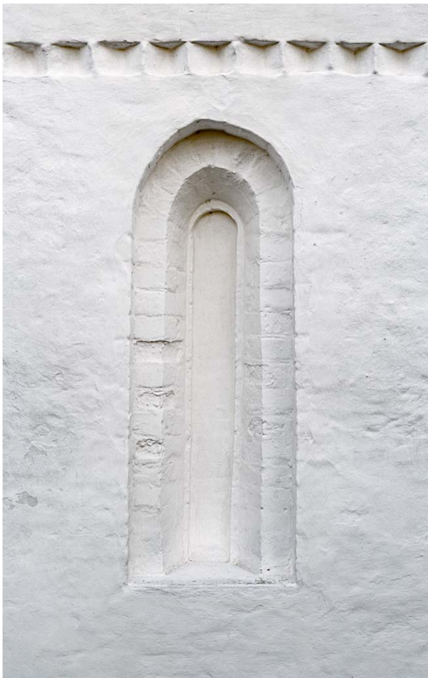
Fig. 8. Unggotisk (†)vindue i skibets nordside (s. 4525). Foto Arnold Mikkelsen 2017. – Bricked up Early Gothic (†)window in north facade of nave.
