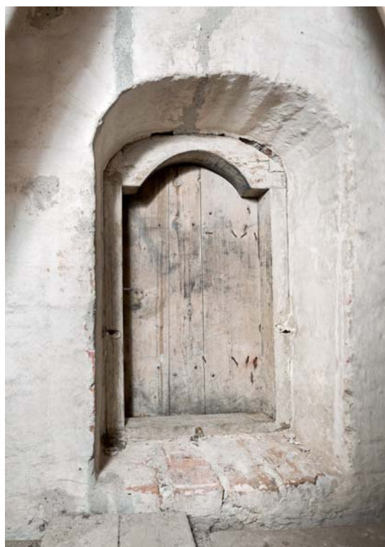
Fig. 29. Korforlængelsens østgavl med dør til tagværk (s. 4539). Foto Arnold Mikkelsen 2017. – East gable of chancel extension with door to roofing.
