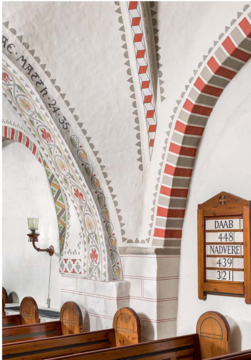
Fig. 11. Hvælpille i korets nordvesthjørne (s. 4539), set fra sydøst. Foto Arnold Mik-kelsen 2017. – Vault pillar in the northwestern corner of the chancel, seen from the south east.
