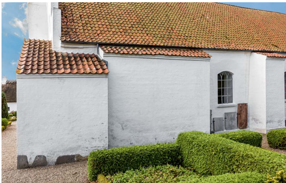
Fig. 29. Langhuskoret nordøsthjørne med forstærkning (s. 4602) og piller (s. 4611) set fra nord. Foto Arnold Mikelsen 2017. – Northeastern corner of nave-chancel with reinforcement and pillars seen from the north.
