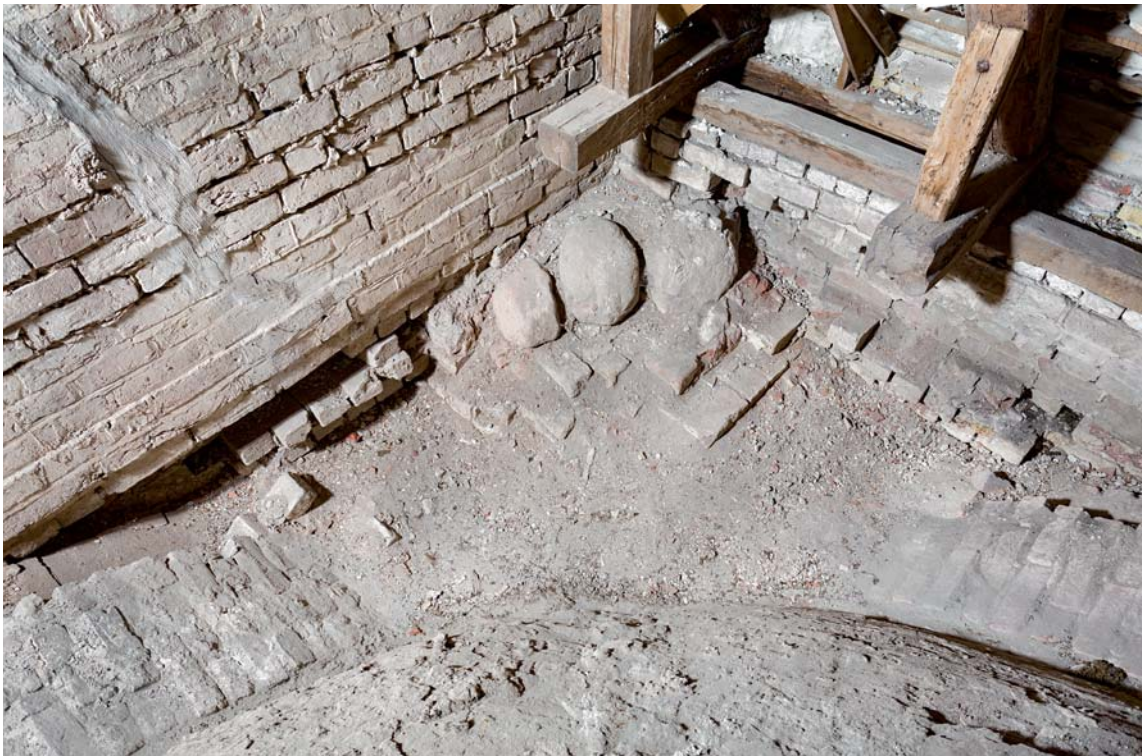
Fig. 15. Hvælvfortanding i vestforlængelsens nordvestre hjørne (s. 4587). Foto Arnold Mikkelsen 2017. – Vault tothing in northwestern corner of western extension.
