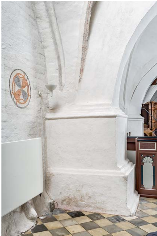
Fig. 95. Forstærket pille i korets sydside (s. 4602). Foto Arnold Mikkelsen 2017. – Reinforced pillar in south side of chancel.
