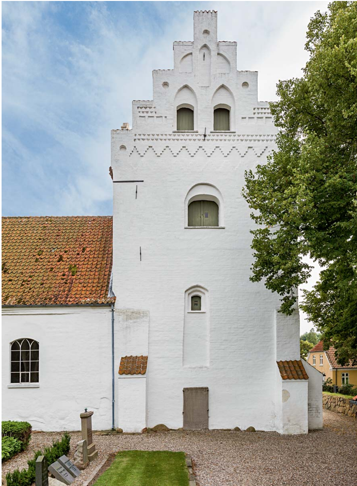
Fig. 17. Tårnet (s. 4588) set fra nord. Foto Arnold Mikkelsen 2017. – Tower seen from the north.
