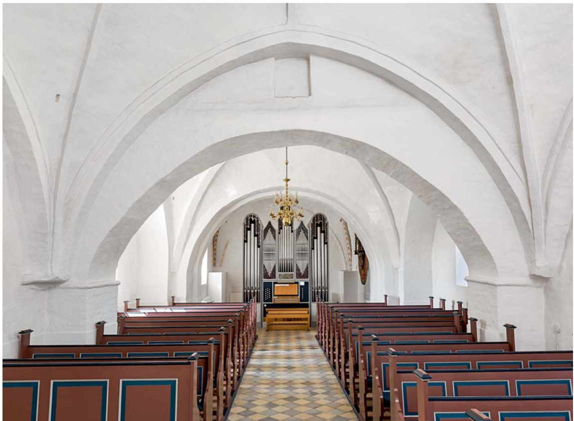
Fig. 13. Bue mellem det oprindelige skibs vestre fag og vestforlængelsen (s. 4587) samt †luge (s. 4598, jf. fig. 26) til skibets tagværk (s. 4607). Foto Arnold Mikkelsen 2017. – Arch between the west bay of the original nave and the western extension, and †hatch (cf. fig. 26) to the roofing of the nave.
