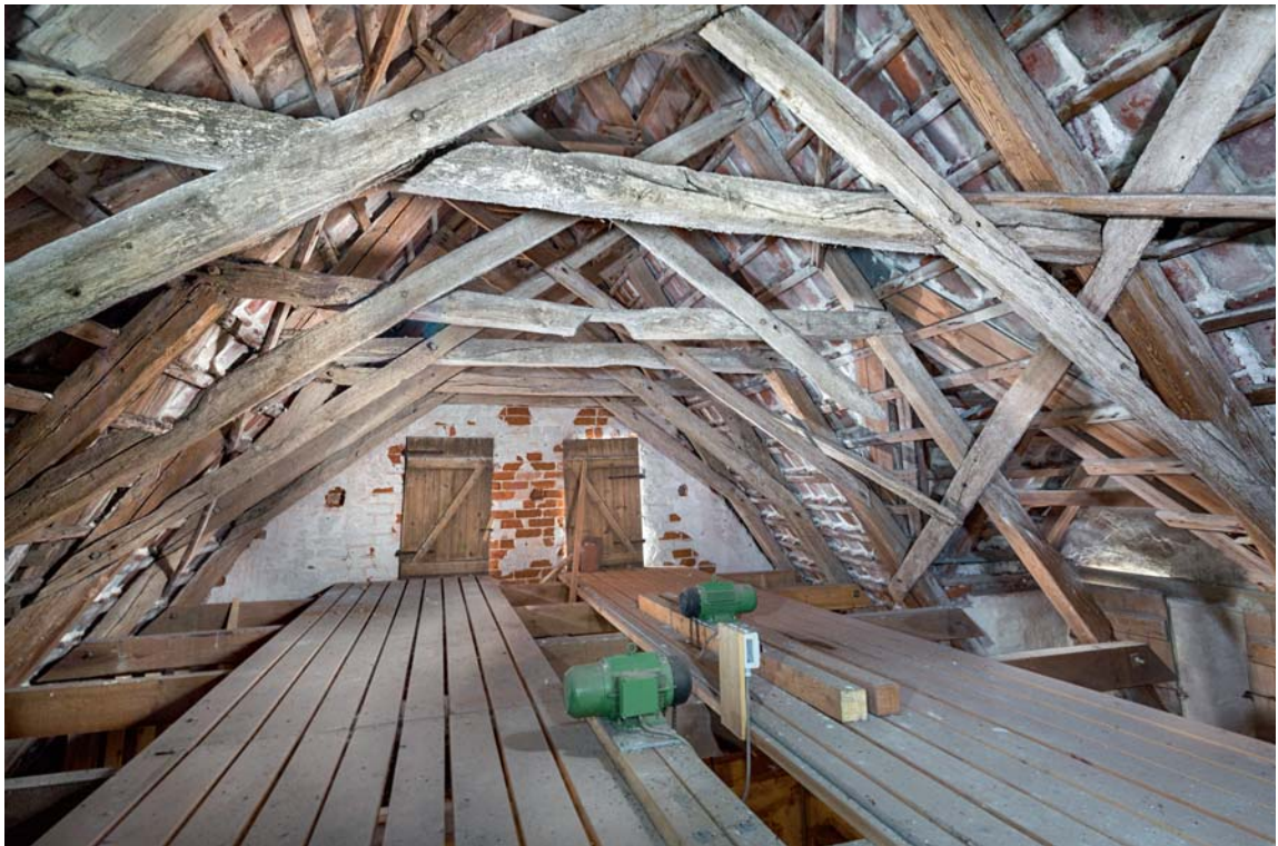
Fig. 35. Tårnets tagværk (s. 4606), set mod nord. Foto Arnold Mikkelsen 2017. – Roofing of tower looking north.
