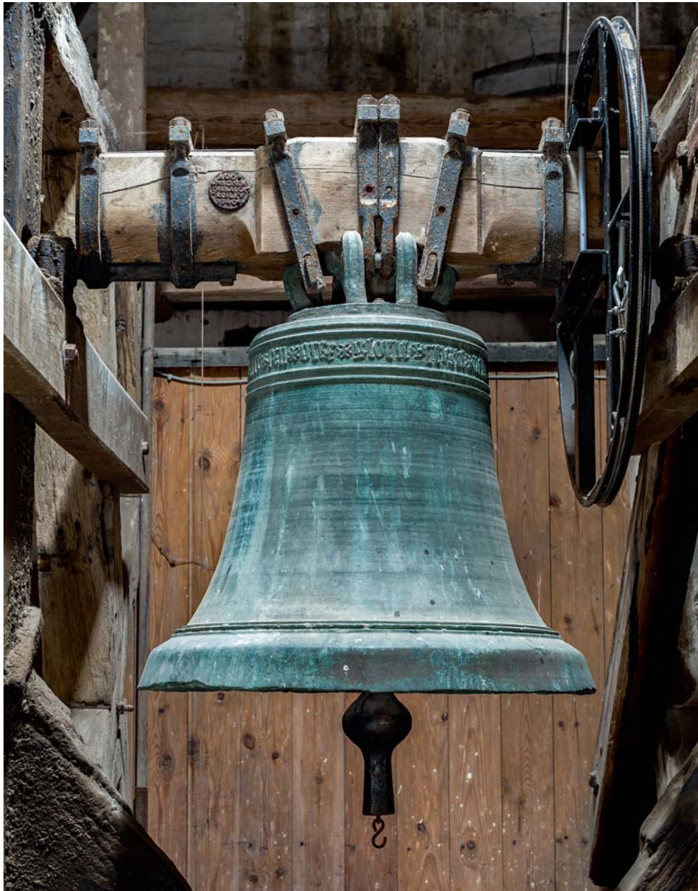
Fig. 75. Klokke nr. 1, støbt 1462 af mester Laurinsius (s. 4641). Foto Arnold Mikkelsen 2017. – Bell no. 1, cast in 1462 by Master Laurinsius.
