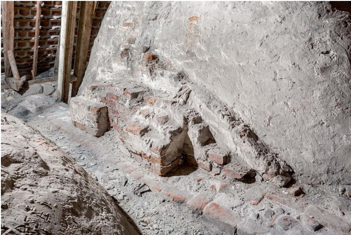
Fig. 26. Det oprindelige skibs vestre hvælv med \dagger luge (s. 4598, jf. fig. 13). Foto Arnold Mikkelsen 2017. – Western vault of the original nave with \dagger hatch (cf. fig. 13).
