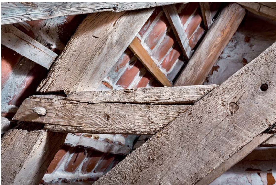
Fig. 36. Tårnets tagværk (s. 4606), eksempel på nummerering (s. 4606). Foto Arnold Mikkelsen 2017. – Roofing of tower, example of numbering.
