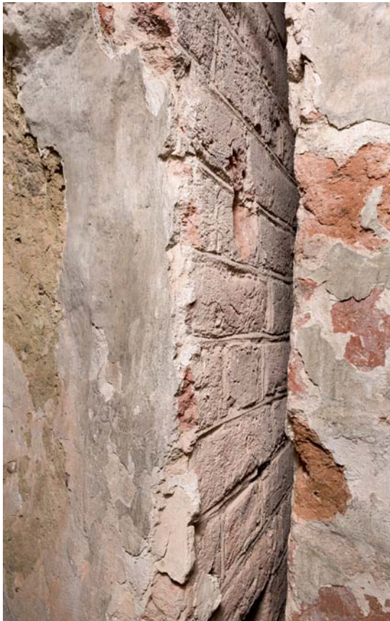
Fig. 93. Fugebehandling på tårnets sydside (s. 4588), set fra trappehuset. Foto Arnold Mikkelsen 2017. – Jointing on south side of tower seen from the stairwell.
