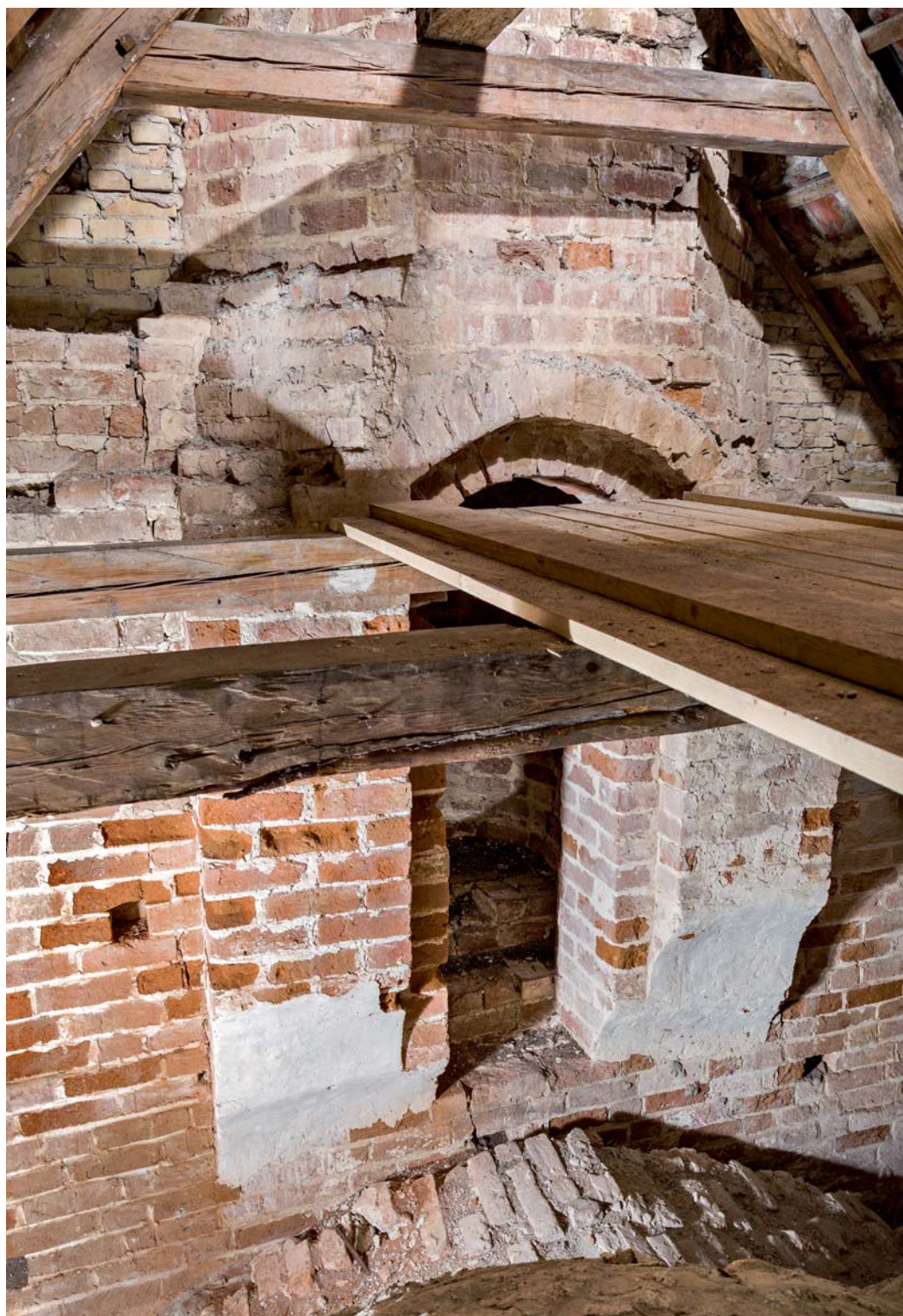
Fig. 23. Messeklokkespirets (s. 4595) sammenstød med korgavlens (s. 4595). Foto Arnold Mikkelsen 2017. – Meeting point of mass bell spire with chancel gable.
