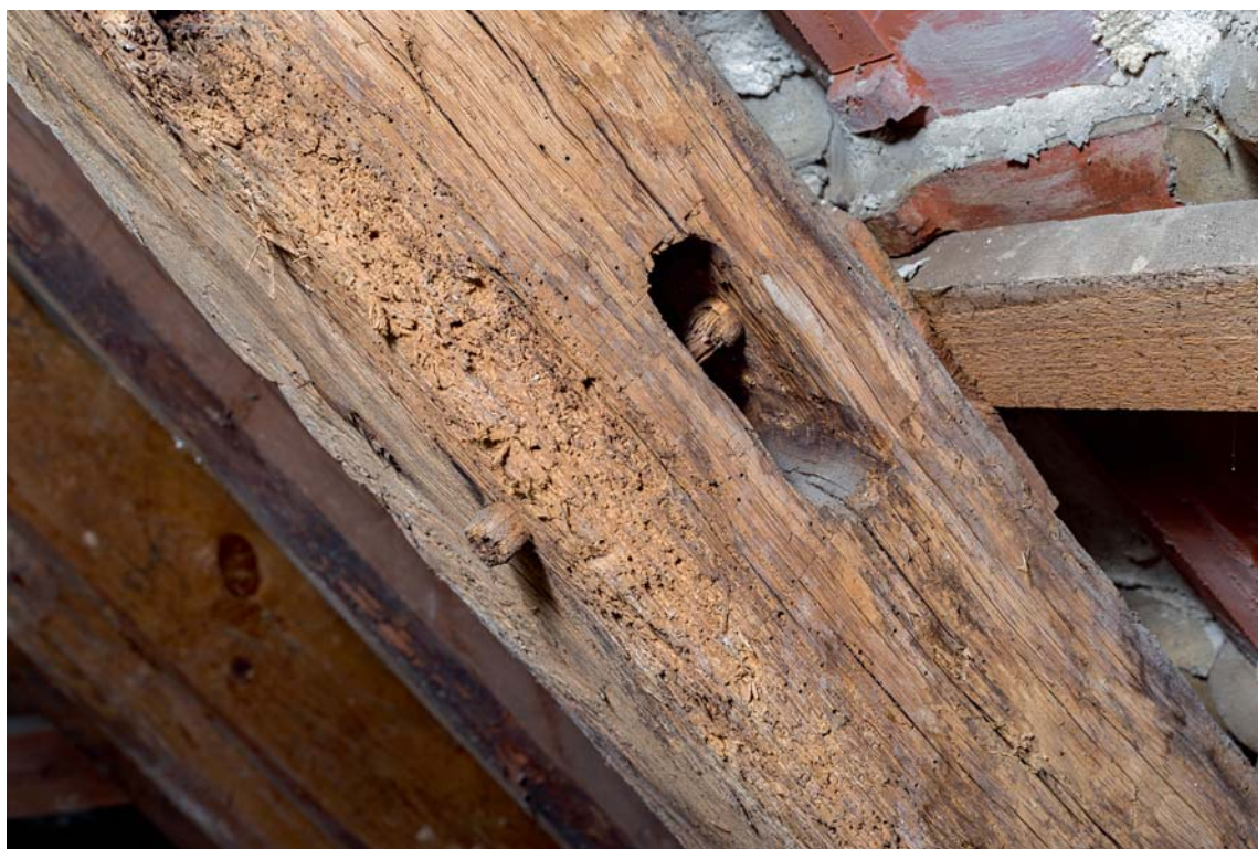
Fig. 38. Spær med ovalt hul (til et skråbånd) med en isiddende nagle (s. 4607). Foto Arnold Mikkelsen 2017. – Rafter with oval hole (for a cross-brace) with a remaining rivet.
