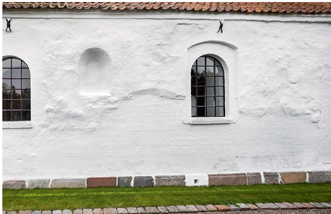
Fig. 53. Detalje af det romanske skibs nordside (s. 4668). Foto Arnold Mikkelsen 2017. – Detail of the north side of the Romanesque nave.
