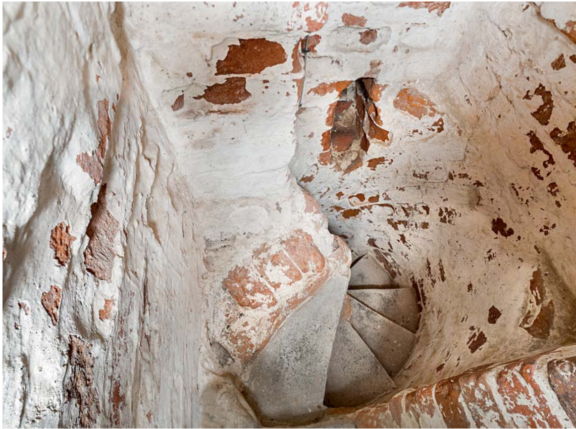
Fig. 15. Trappehusets indre med trappeløb (s. 4676). Foto Arnold Mikkelsen 2017. – Interior of the stairwell with stairs.
