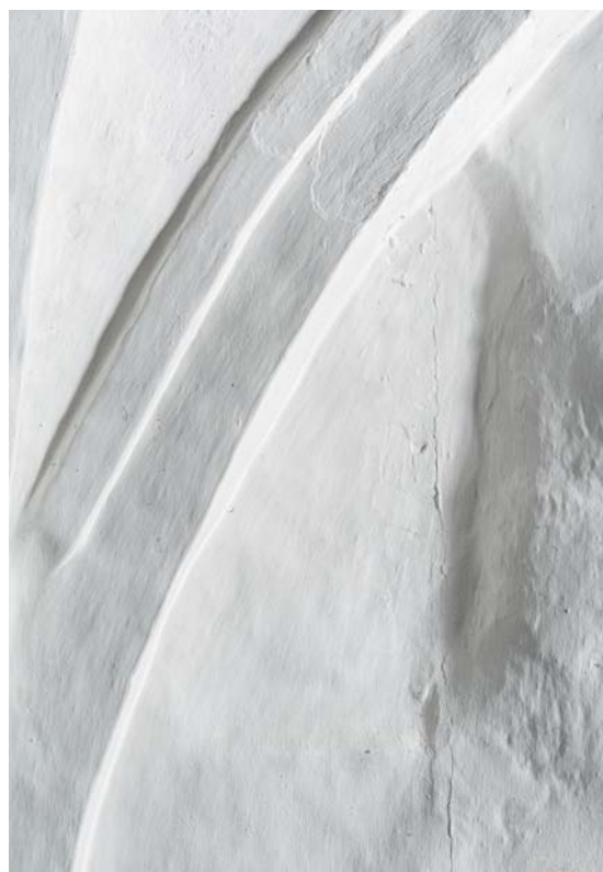
Fig. 52. Rest af romansk \uparrow vindue på skibets nordvæg (s. 4668). Foto Arnold Mikkelsen 2017. – Fragment of Romanesque window on north wall of nave.
