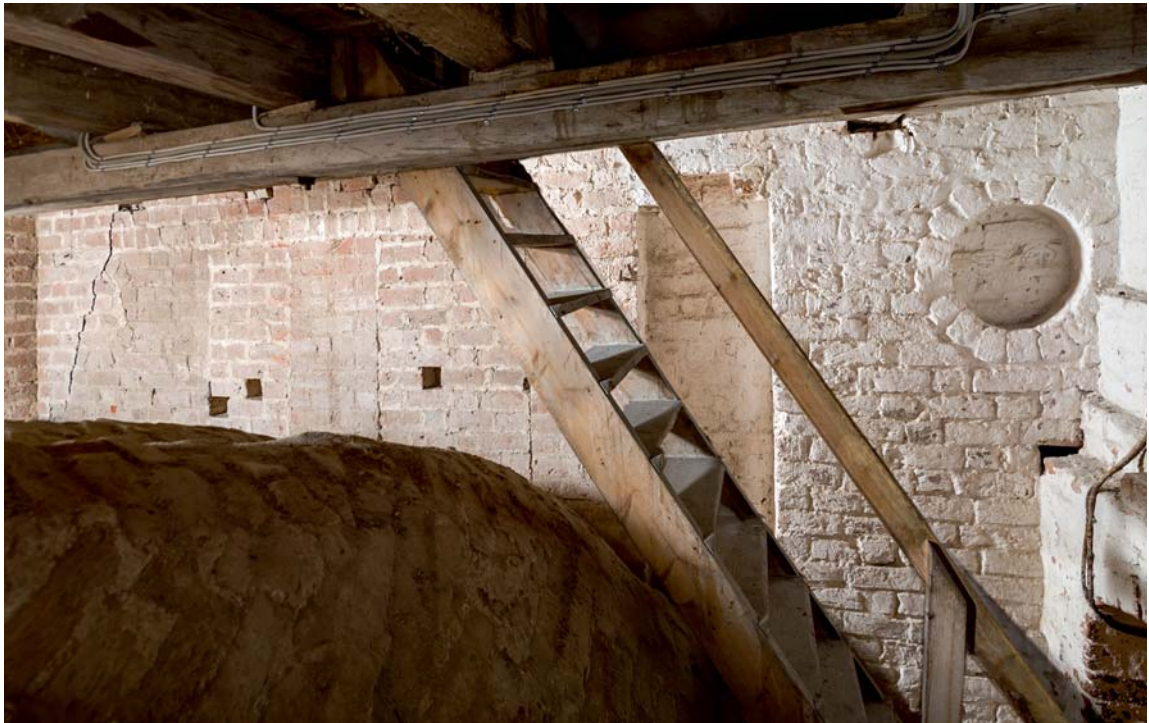
Fig. 9. Vestforlængelsens vestgavl (s. 4670) set fra tårnets mellemstokværk. Foto Arnold Mikkelsen 2017. – West gable of the western extension seen from the middle storey of the tower.
