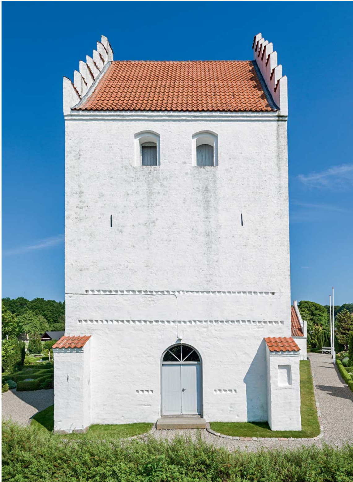
Fig. 13. Tårnet (s. 4671) set fra vest. Foto Arnold Mikkelsen 2017. – The tower seen from the west.
