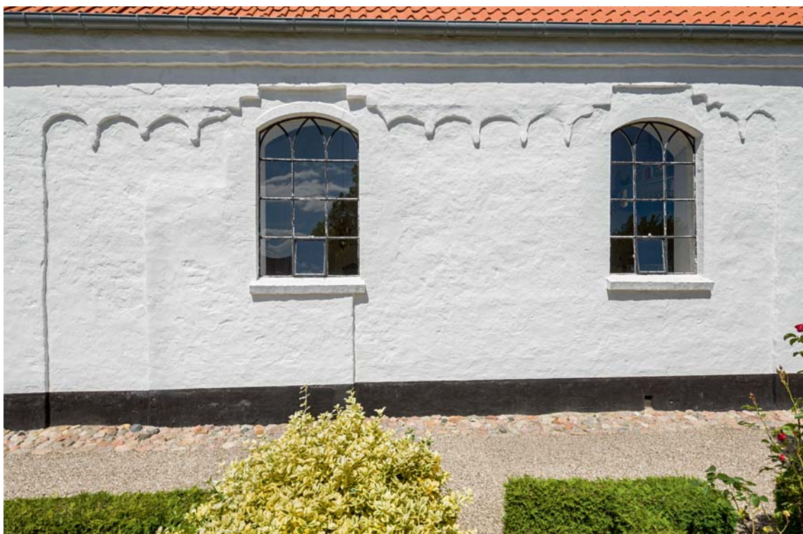
Fig. 7. Det romanske skibs sydside (s. 4733). Foto Arnold Mikkelsen 2017. – South side of the Romanesque nave.
