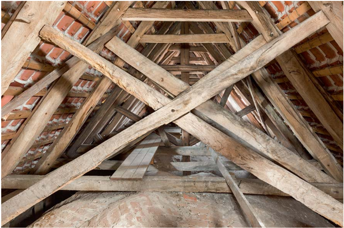
Fig. 21. Spærfag 6, 7 og 8 (s. 4746), set fra vest. Foto Arnold Mikkelsen 2017. – Truss bays 6, 7 and 8, seen from the west.
