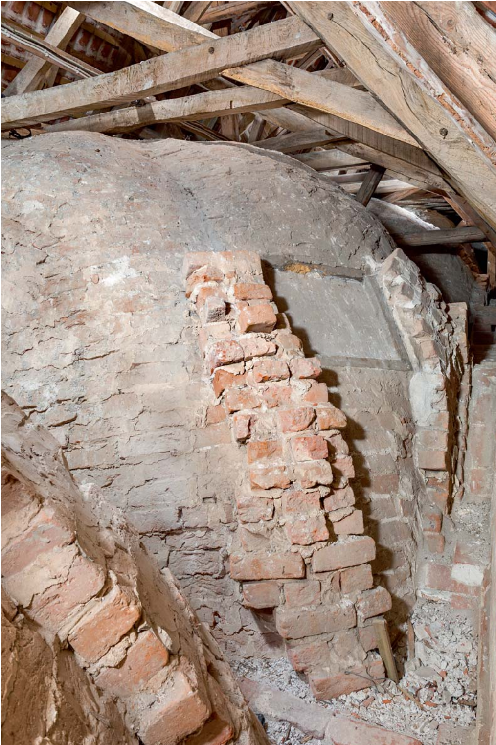
Fig. 24. Lem i skibets tredje spærfags hvælv (jf. fig. 25-26, s. 4736). Foto Arnold Mikkelsen 2017. – Hatch in the vault of the third truss bay of the nave.
