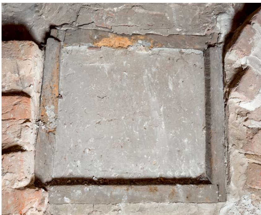
Fig. 26. Lem i skibets tredje spærfags hvælv (s. 4736, jf. fig. 24-25), detalje. Foto Arnold Mikkelsen 2017. – Hatch in the vault of the third truss bay of the nave, detail.
