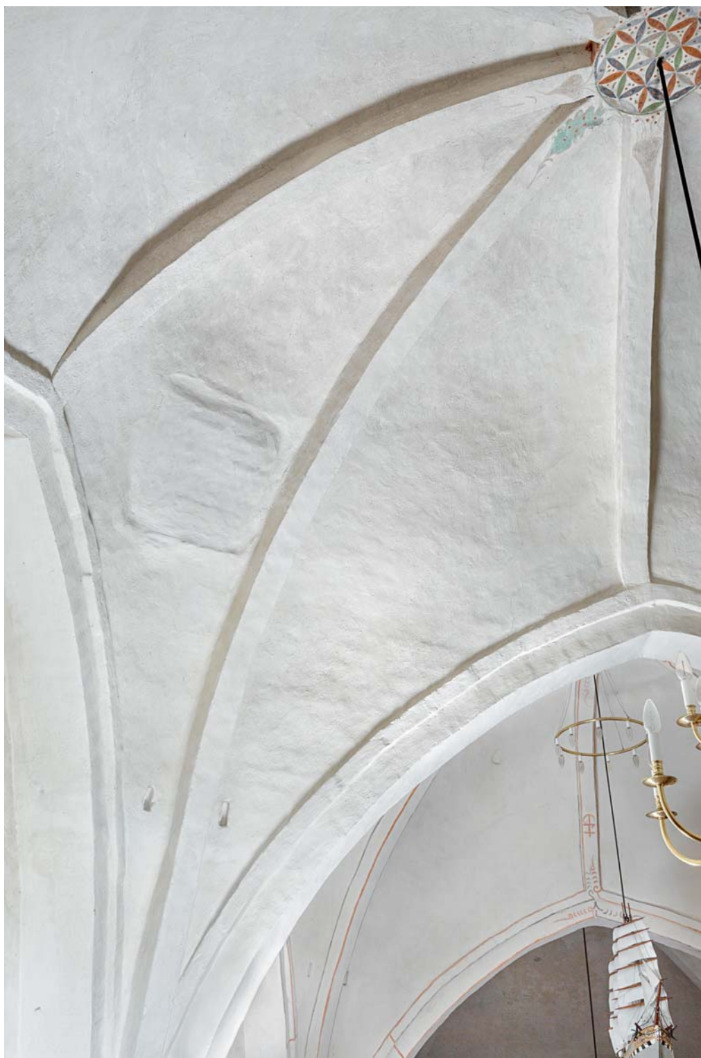
Fig. 25. †Lem i skibets 2. hvælvfag (s. 4736, jf. fig. 24 og 26). Foto Arnold Mikkelsen 2017. – †Hatch in the second vault bay of the nave.
