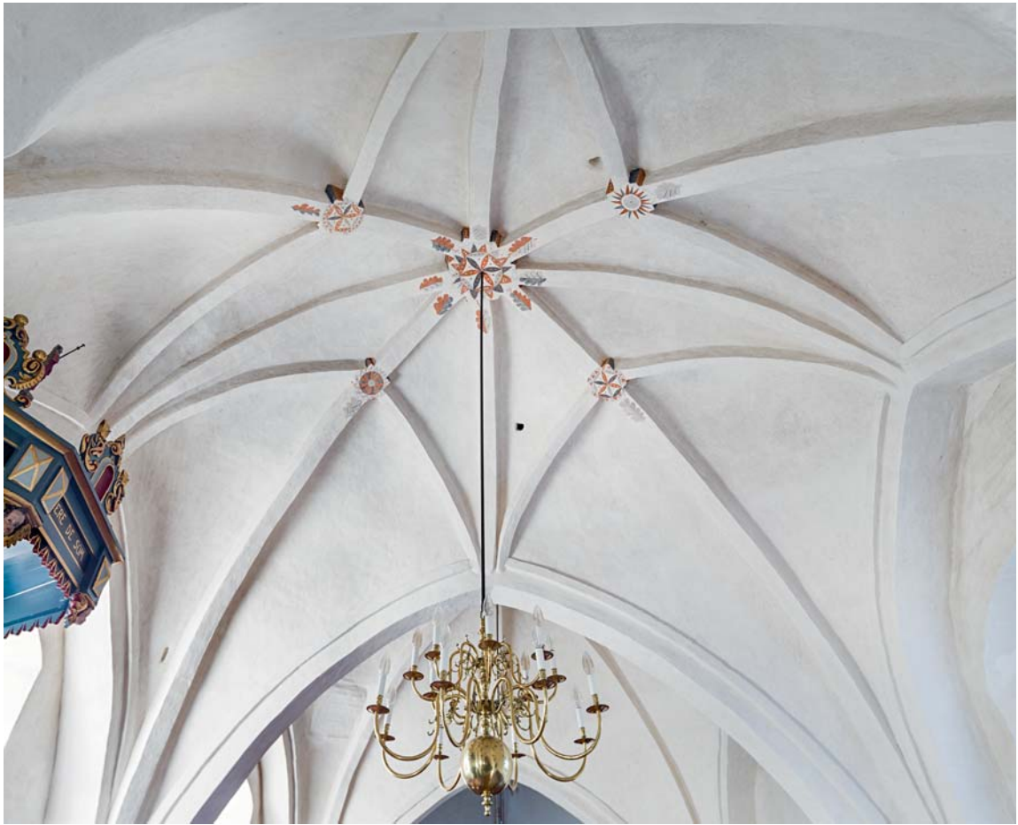
Fig. 12. Hvælv i skibets østligste fag. (s. 4736), set mod vest. Foto Arnold Mikkelsen 2017. – Vault in the easternmost bay of the nave, looking west.
