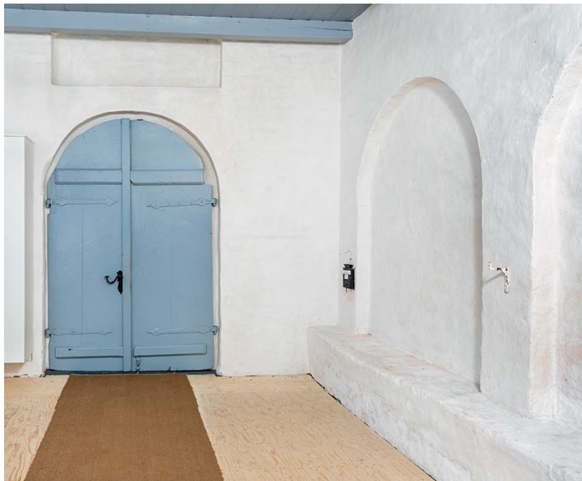
Fig. 18. Våbenhuset indre set mod nordøst med dør (s. 4735), †vindue (s. 4735), muret bæk (s. 4739) og nicher (s. 4739). Foto Arnold Mikkelsen 2017. – Interior of porch looking north west with door, †window, masonry bench and niches.
