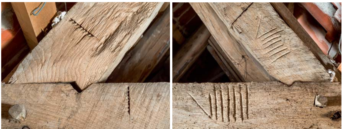
Fig. 22–23. 22. Nummerering på spær og øvre hanebånd, spærfag 6, syd (s. 4747). 23. Nummerering på spær og øvre hanebånd, spærfag 7, nord (s. 4746). Foto Arnold Mikkelsen 2017. – 22. Numbering on truss and upper collar beam, truss 6, south. 23. Numbering on truss and upper collar beam, truss 7, north.
