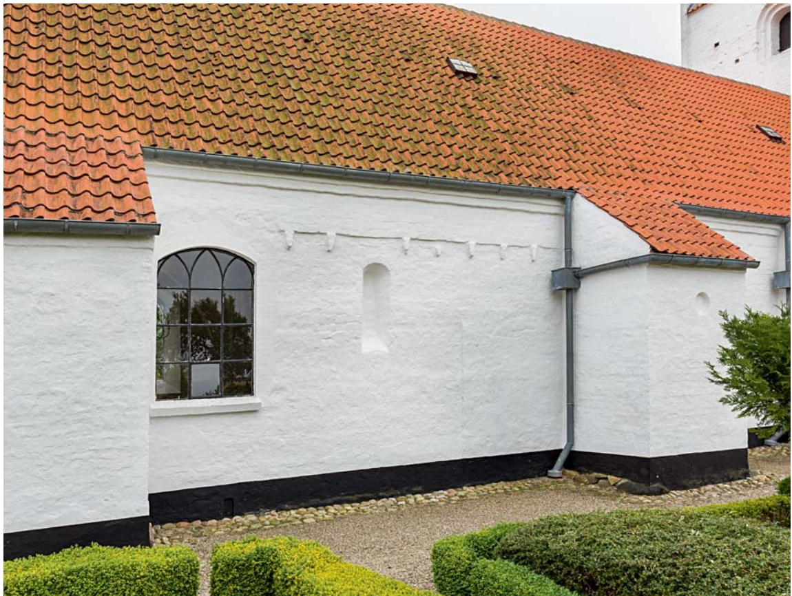
Fig. 27. Det romanske skibs nordside med senere tilføjede støttestøtter (s. 4750), set fra nordøst. Foto Arnold Mikelsen 2017. – North side of the Romanesque nave with later added buttresses, seen from the north east.
