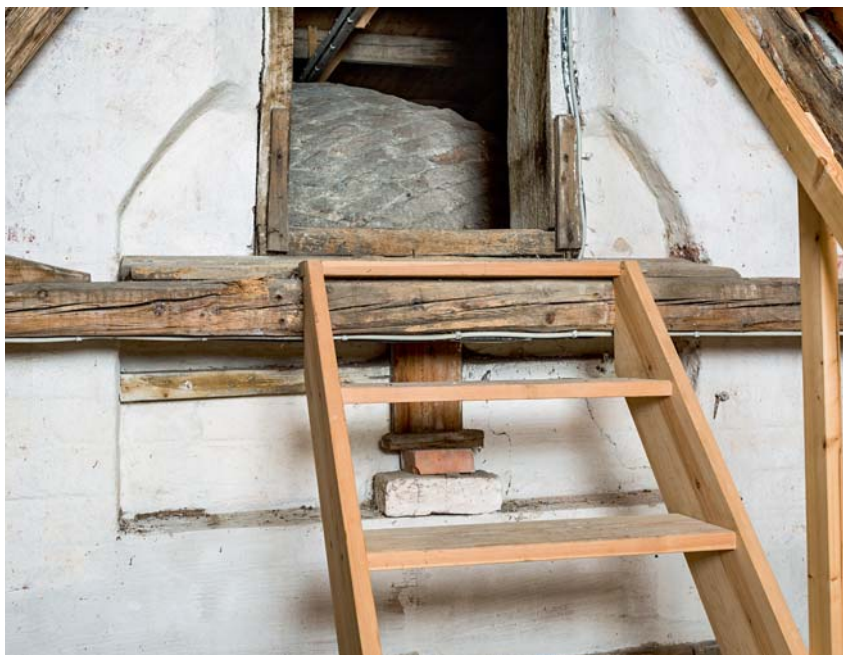
Fig. 10. Rest af et let spidsbuet spejl, der har indrammet et vindue i vestforlængelsens vestgavl (s. 4958). Foto Arnold Mikkelsen 2018. – Remains of a slightly pointed-arched mirror, which once framed a window in the west gable of the western extension.
