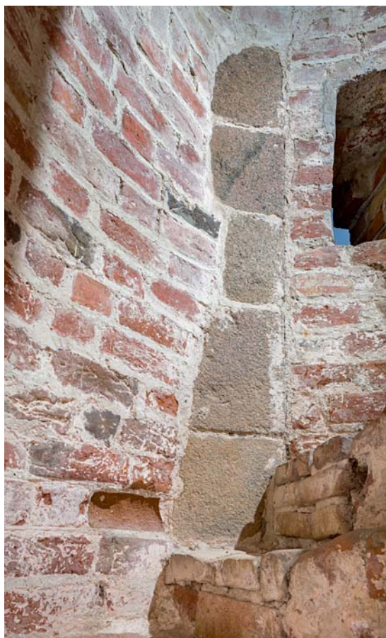
Fig. 50. Indre af trappehus (s. 5038) med synlig hjørnekæde på det romanske skibs sydvesthjørne (s. 5032). Foto Arnold Mikkelsen 2019. – Interior of stairwell with visible corner chain from the south western corner of the romanesque nave.
