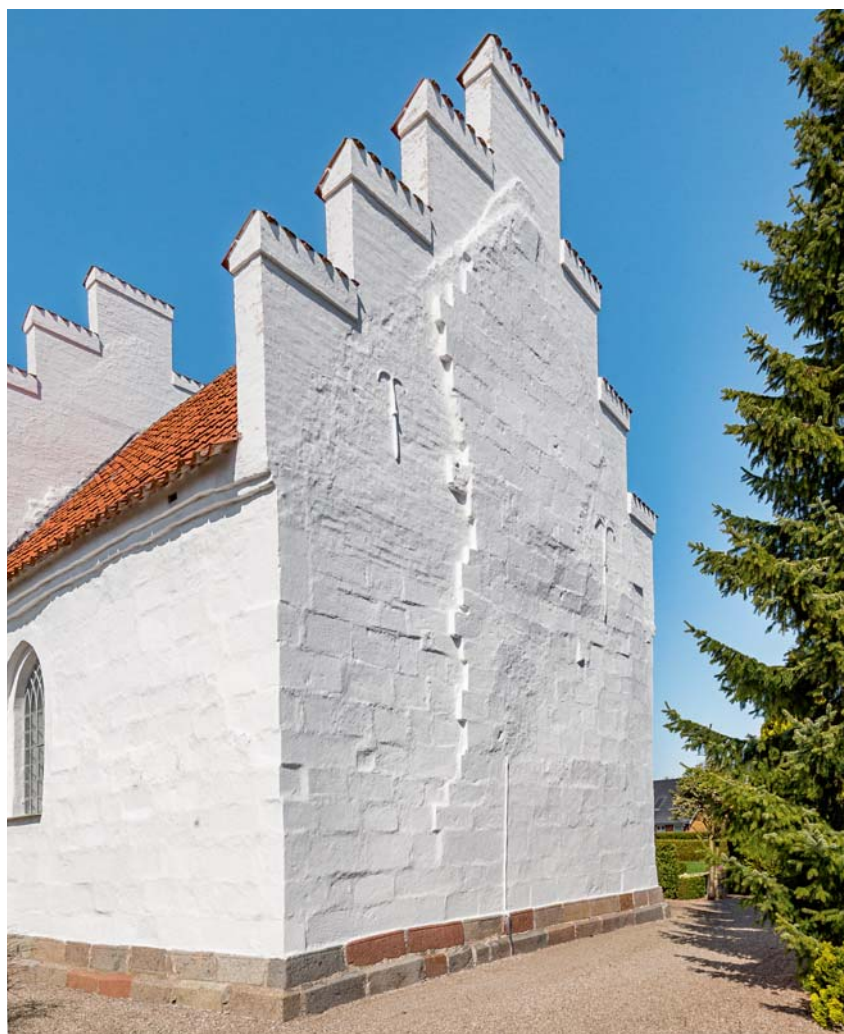
Fig. 10. Koret set fra sydøst. Foto Arnold Mikkelsen 2018. – The chancel from the south east.
