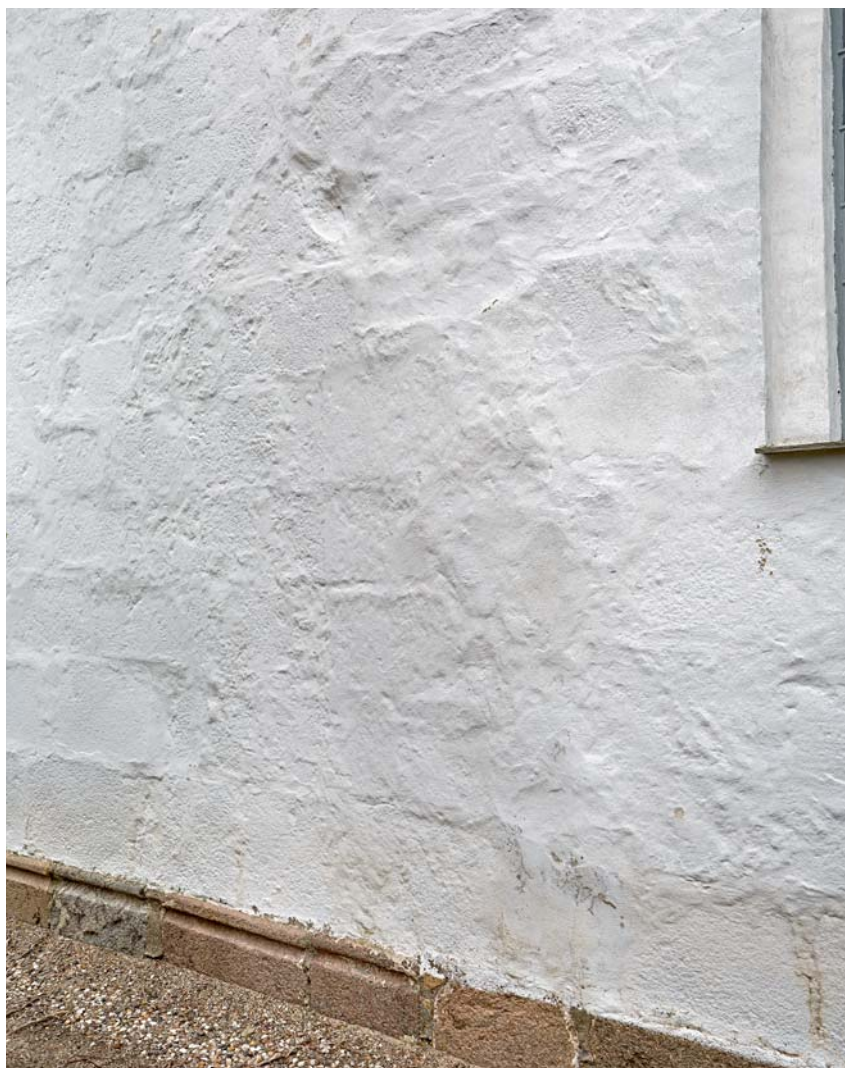
Fig. 51. Spor af vestmur og tag fra \ddagger våbenhus på skibets sydside (s. 5035). Foto Arnold Mikkelsen 2019. – Traces of western wall and roof from \ddagger porch.
