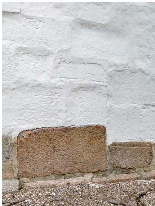
Fig. 53. Vange fra \dagger arkade til \dagger kapel(?) (s. 5039) på skibets sydside. Foto Arnold Mikkelsen 2019. – Remains of \dagger Arcade of \dagger chapel(?) on the southern side of the nave.
