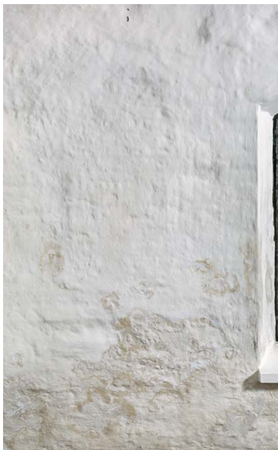
Fig. 48. †Vindue i skibets sydmur (s. 5174). Foto Arnold Mikkelsen 2018. – †Window in the south wall of the nave.
