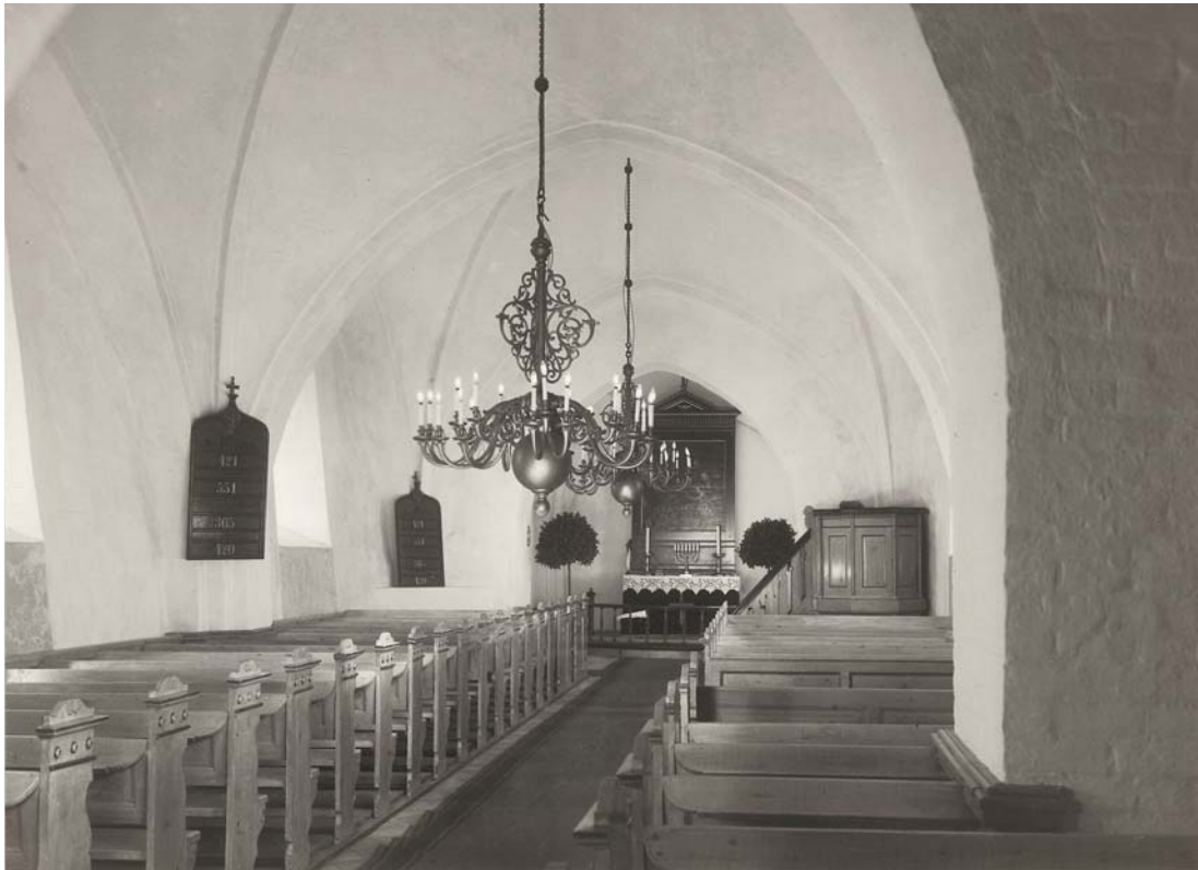
Fig. 16. Indre set mod øst. Foto C. Andreasen 1934. – The interior looking east.
