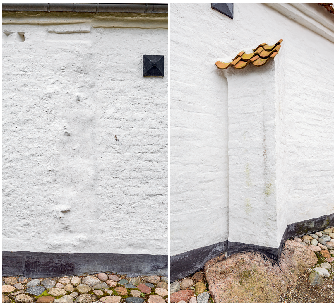
Fig. 11-12. 11. †Støttestøtte på skibets sydøsthjørne (s. 5379). 12. Oprindelig støttestøtte på skibets nordøsthjørne (s. 5378). Foto Arnold Mikkelsen 2019. – 11. †Supporting pillar in the south-east corner of the nave. 12. Original supporting pillar in the north-east corner of the nave.
