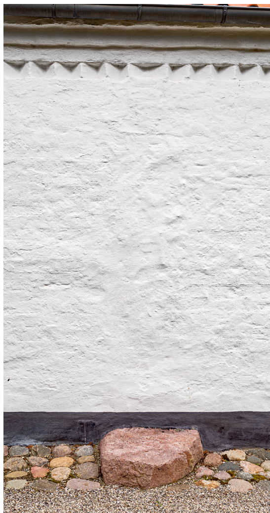
Fig. 13. †Støttestøtte på skibets sydside (s. 5379). Foto Arnold Mikkelsen 2019. – †Supporting pillar on the south side of the nave.
