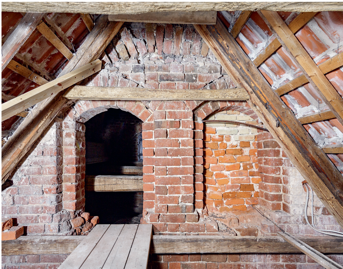
Fig. 10. Det oprindelige tårns østgavl (s. 5378) med glamhuller set fra skibets tagrum (s. 5379). Foto Arnold Mikkelsen 2019. – The eastern gable of the original tower with openings, seen from the loft of the nave.
