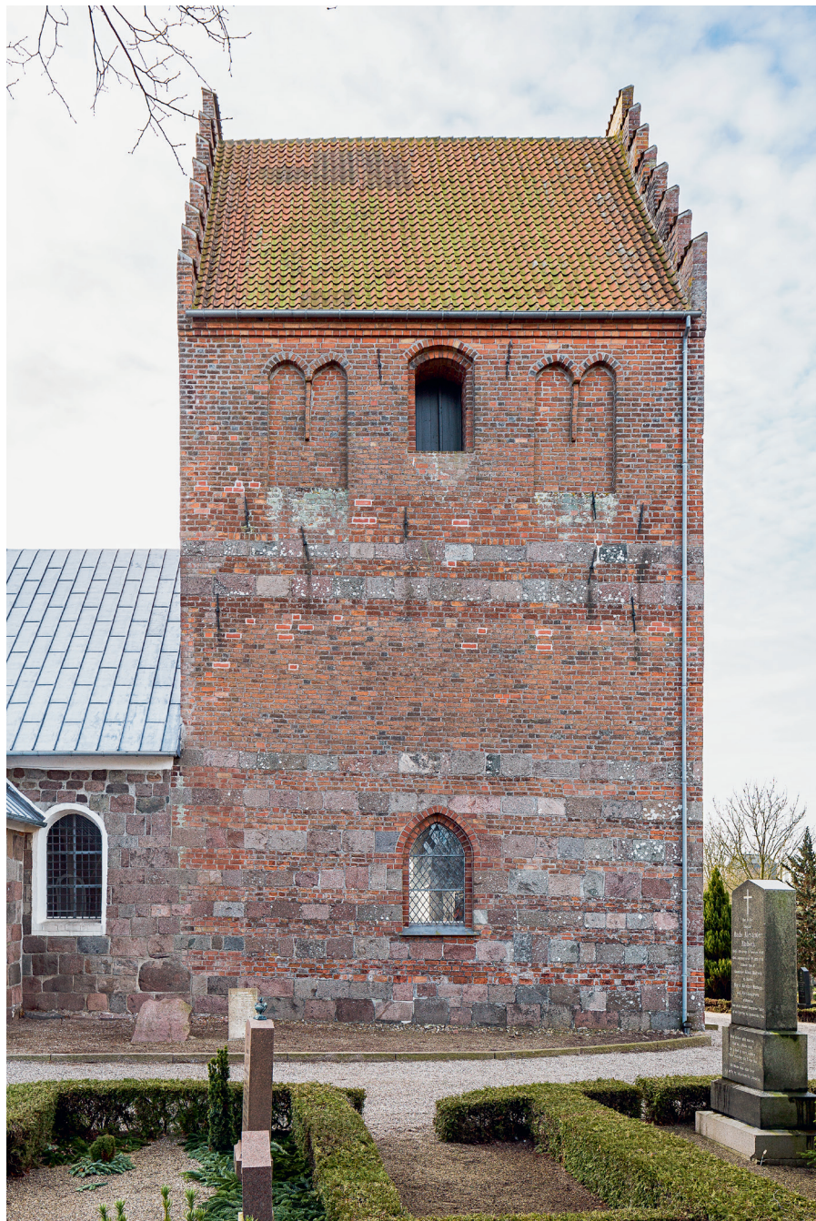
Fig. 13. Tårnet set fra nord (s. 5422). Foto Arnold Mikkelsen 2019. – The tower seen from the north.
