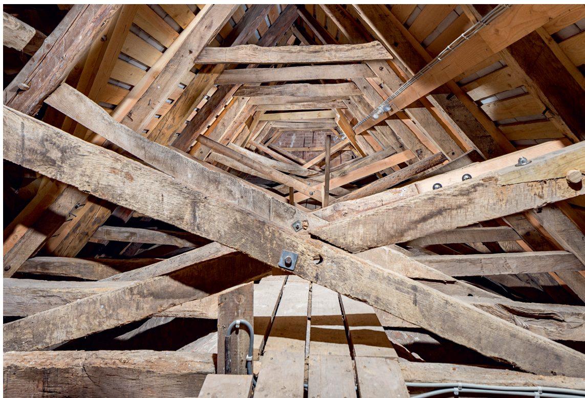
Fig. 30. Skibets tagværk set mod vest (s. 5440). Foto Arnold Mikkelsen 2019. – The roof structure of the nave looking west.
