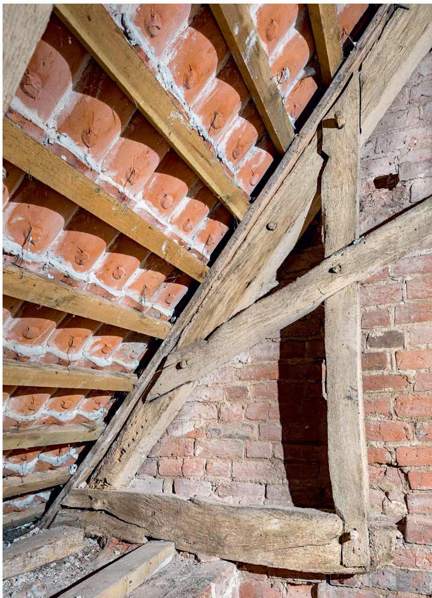
Fig. 31. Søndre kapels sydligste spærfag i øst. Spær, krydsbånd, spærstiver og spærfod (s. 5440). Foto Arnold Mikkelsen 2019. – The south chapel's southernmost truss in the east. Rafter, cross timber, rafter post and foot.
