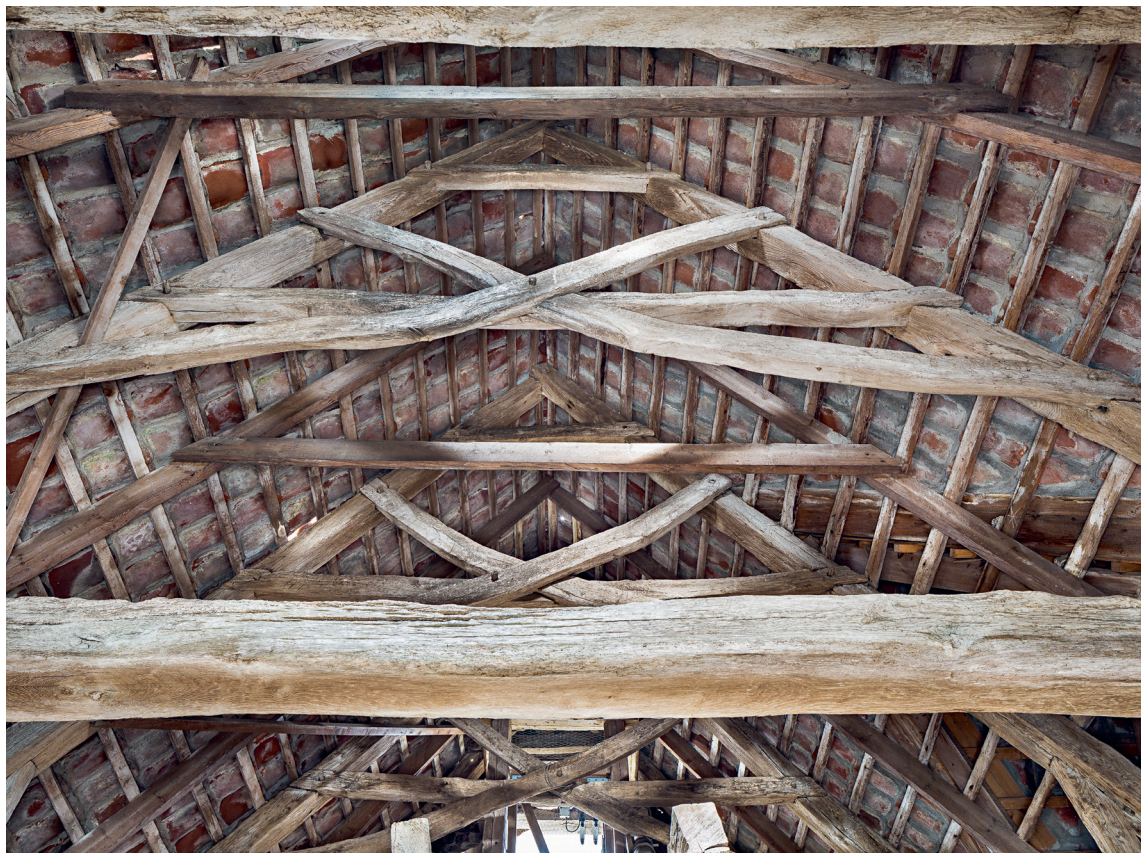
Fig. 33. Tårnets tagværk (s. 5531) set mod nord. Foto Arnold Mikkelsen 2019. – Roofing of the tower looking north.
