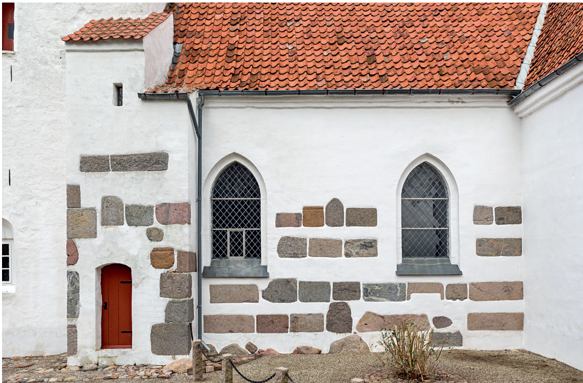
Fig. 14. Skibets sydsides vestlige del (s. 5514) samt trappehus (s. 5515). Foto Arnold Mikkelsen 2018. – Western part of the south side of the nave, plus stairwell.
