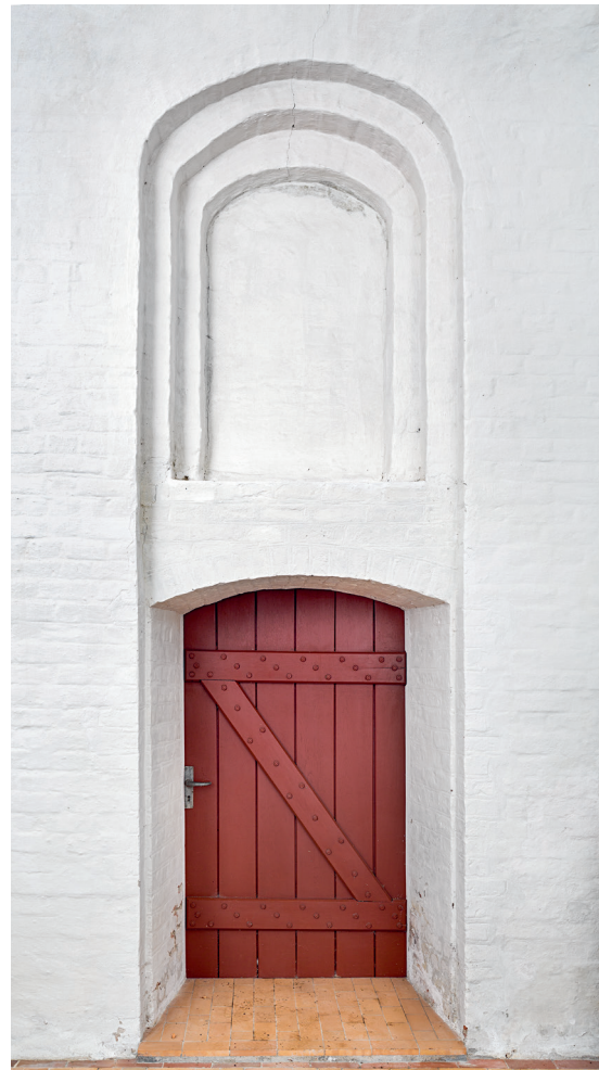
Fig. 28. Nordkapellets nordmur set fra kapellets indre med triforium (s. 5524) samt sekundær dør (s. 5529). Foto Arnold Mikkelsen 2018. – North wall of north chapel seen from the interior of the chapel with triforium and secondary door.
