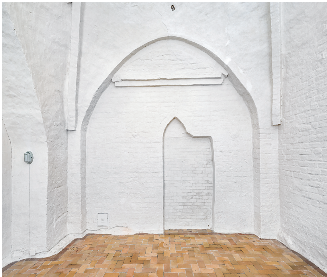
Fig. 24. Våbenhusets østre flankemur med †vindue (s. 5523) samt †dør (s. 5522) set fra nordkapellet. Foto Arnold Mikkelsen 2018. – Eastern flanking wall of the porch with †window and †door seen from the north chapel.
