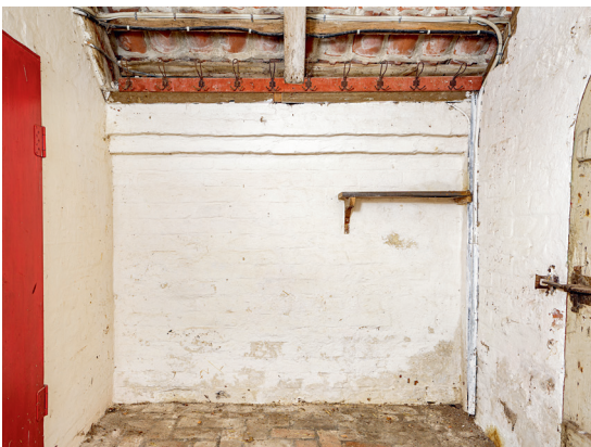
Fig. 70. Våbenhusets indre med vestre flankemur (s. 5520). Foto Arnold Mikkelsen 2019. – Interior of porch with western flanking wall.
