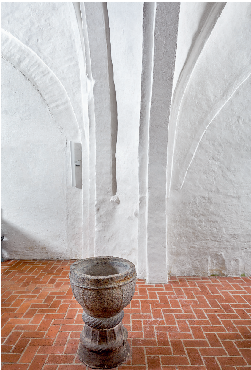
Fig. 16. Overgangen mellem skib og kor med respektive skjoldbuer og mellemfaldende udfyldningshvælv (s. 5517) set mod nord. Foto Arnold Mikkelsen 2018. – Transition between nave and chancel with respective wall ribs and intervening filler vaults, looking north.
