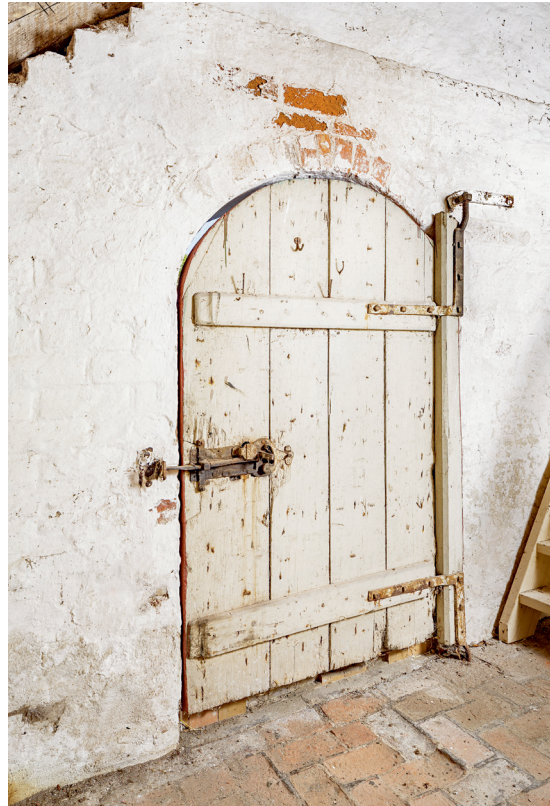
Fig. 71. Våbenhusets dør set mod nord (s. 5520) samt tilbagetrækning af murflugten (s. 5523). Foto Arnold Mikkelsen 2019. – Door of porch, looking north.
