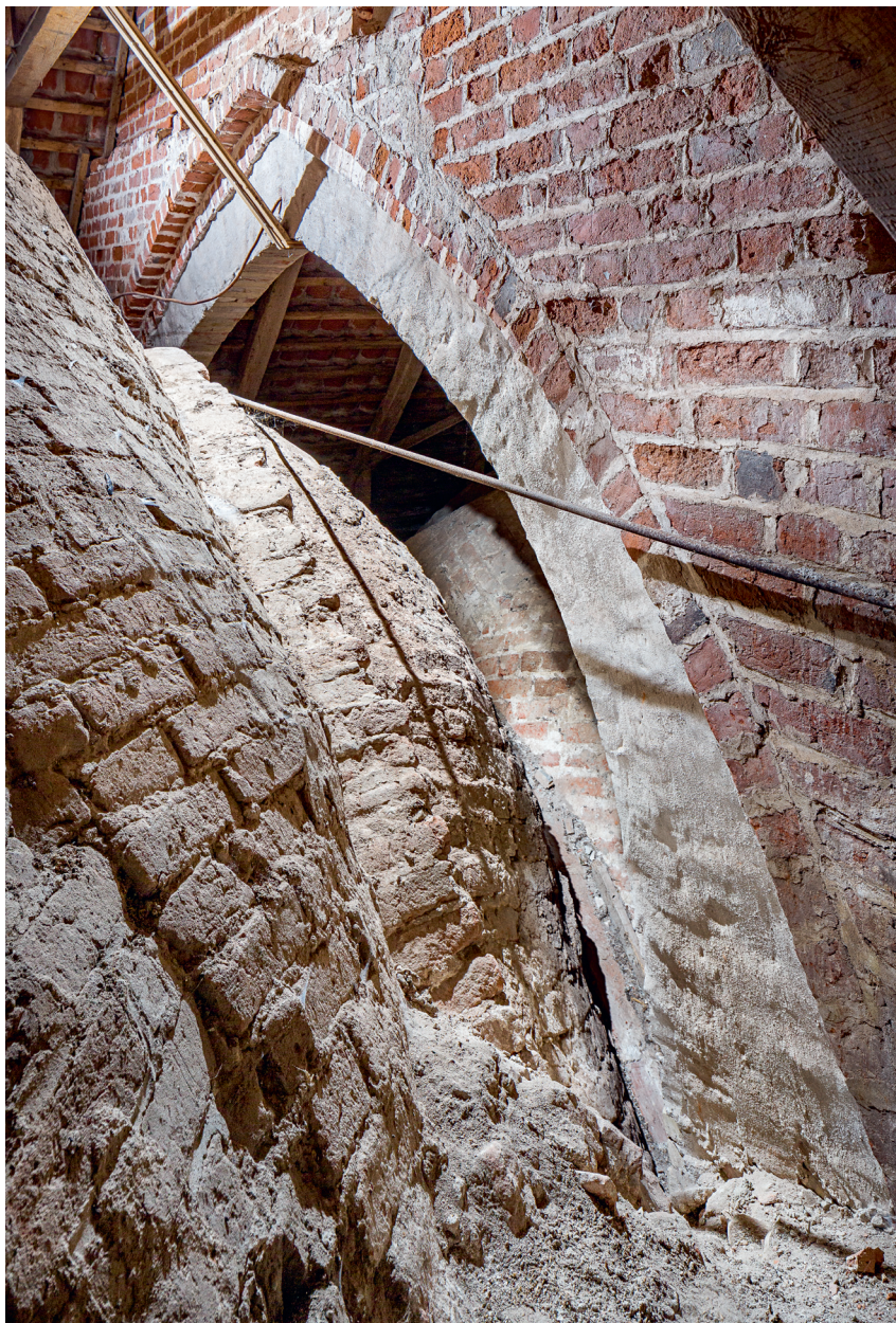
Fig. 18. Overgang mellem korets og skibets hvælv (s. 5517) med, nu undermuret, spidsbuestik, der bærer skibets østgavl (s. 5526). Set fra skibet, fra sydvest, Foto Arnold Mikkelsen 2019. – Transition between vaults of nave and chancel with relieving arch bearing the east gable of the nave. Seen from the nave, from the south west.
