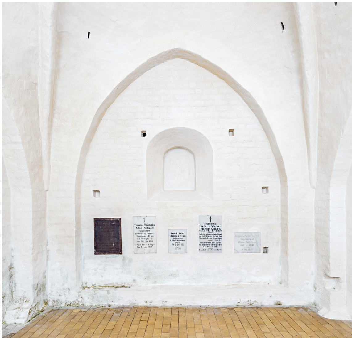
Fig. 11. Tårnrummets indre set mod nord med †vindue (s. 5512). Foto Arnold Mikkelsen 2018. – Interior of the tower looking north with †window.
