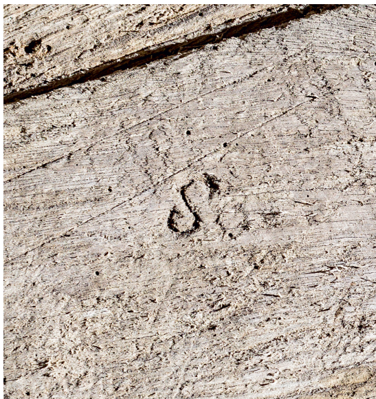
Fig. 75. Tømmermærke i skibets 2. fag, i nordsiden (s. 5531). Foto Arnold Mikkelsen 2019. – Timber mark in the 2th bay of the nave.
