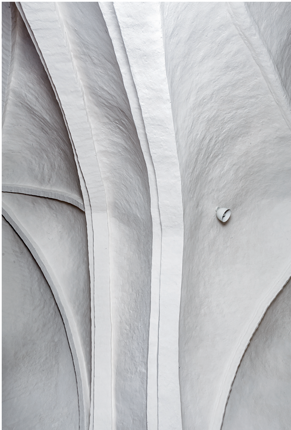
Fig. 73. Overgang mellem kor og skib med skibets og korets skjoldbuer (s. 5515 og 5510) samt mellemfaldende udfyldningshvælv (s. 5517). Foto Arnold Mikkelsen 2018. – Transition between chancel and nave with nave and chancel wall ribs and intervening filler vaults.
