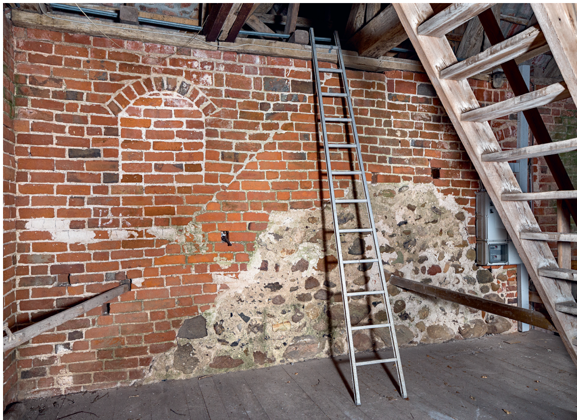
Fig. 13. Skibets romanske vestgavl (s. 5506), gavlens forhøjelse (s. 5511) samt \dagger glamhuller i tårnets østmur (s. 5513). Foto Arnold Mikkelsen 2019. – Romanesque west gable of the nave, heightening of the nave and \dagger belfry lights in east wall of tower.
