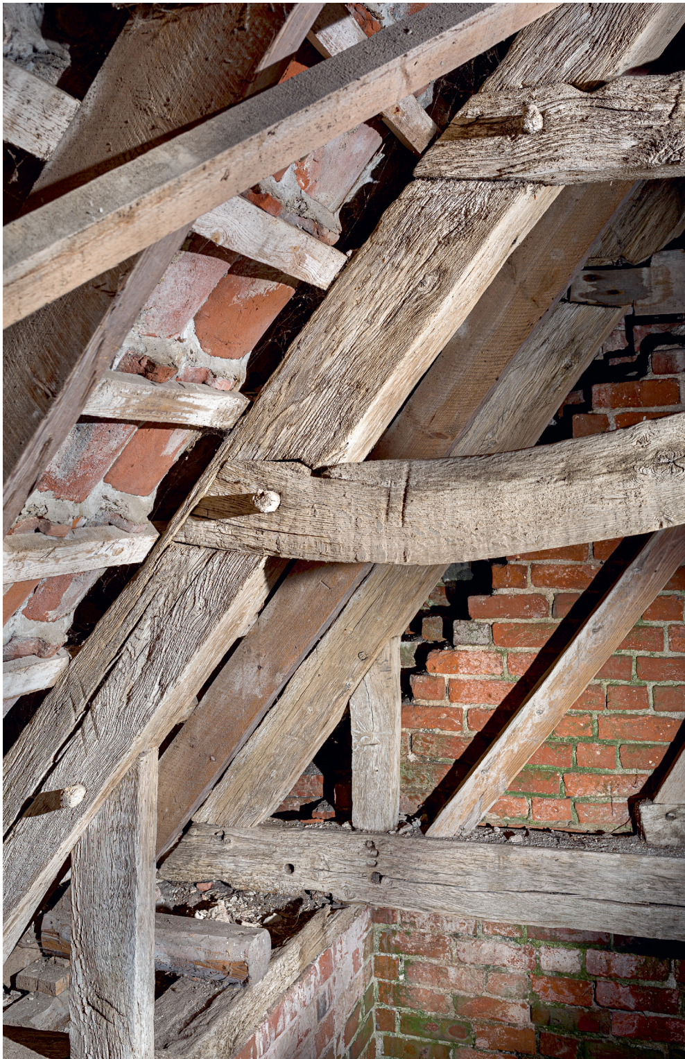
Fig. 34. Tårnets tagværk med store trænegler (s. 5531) set mod nordvest. Foto Arnold Mikkelsen 2020. – Roofing of the tower with large treenails, looking north west.
