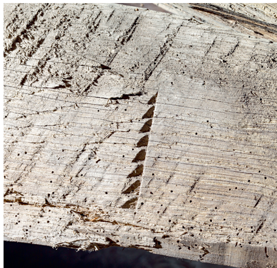
Fig. 37. Tømmernummer i skibets 8. fag, i sydsiden (s. 5531). Foto Arnold Mikkelsen 2019. – Timber number in the 8th bay of the nave.
