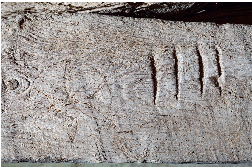
Fig. 36. Tømmernummer og ornament i skibets 4. fag, i nordsiden (s. 5531). Foto Arnold Mikkelsen 2019. – Timber number and ornament in the north side of the 4th bay of the nave.
