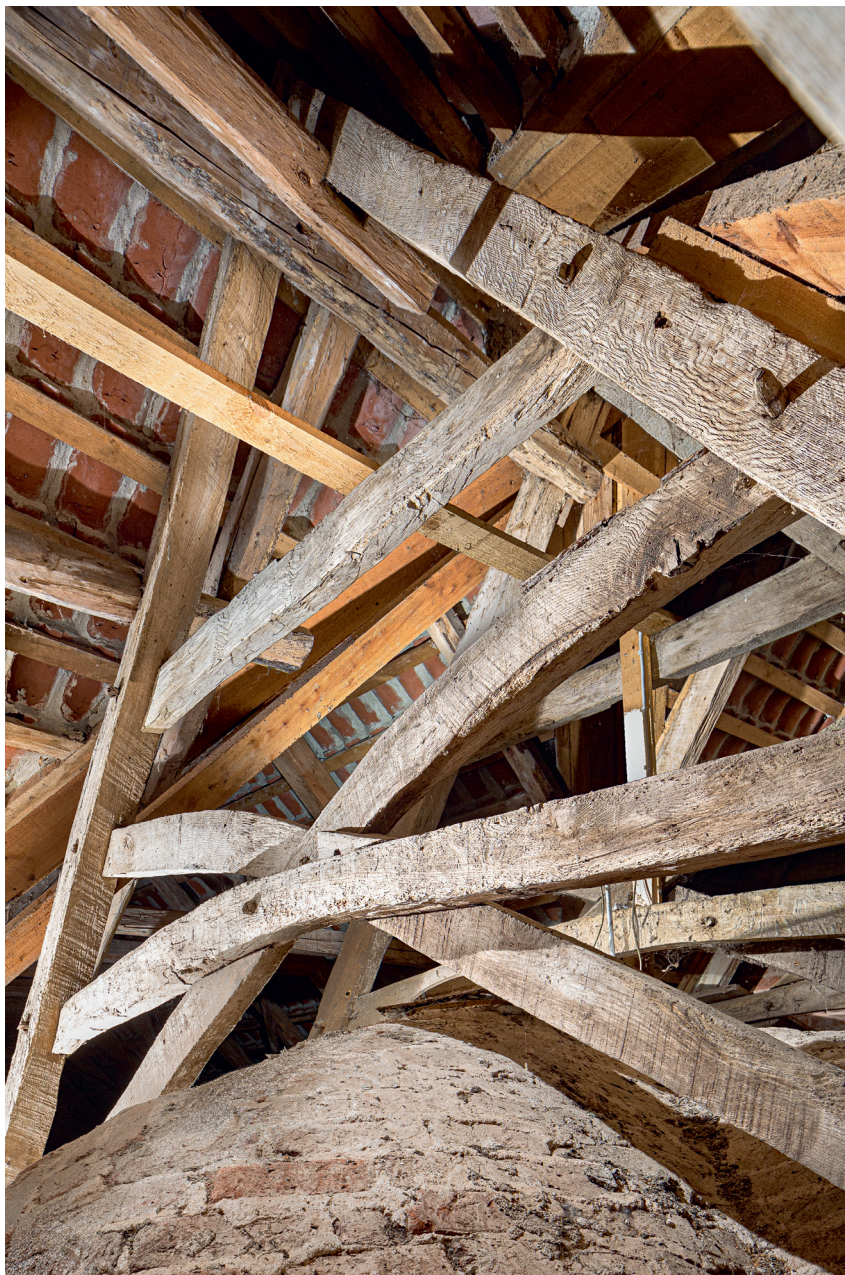
Fig. 18. Korets tagværk (s. 5788). Foto Arnold Mikkelsen 2019. – The roof structure of the chancel.
