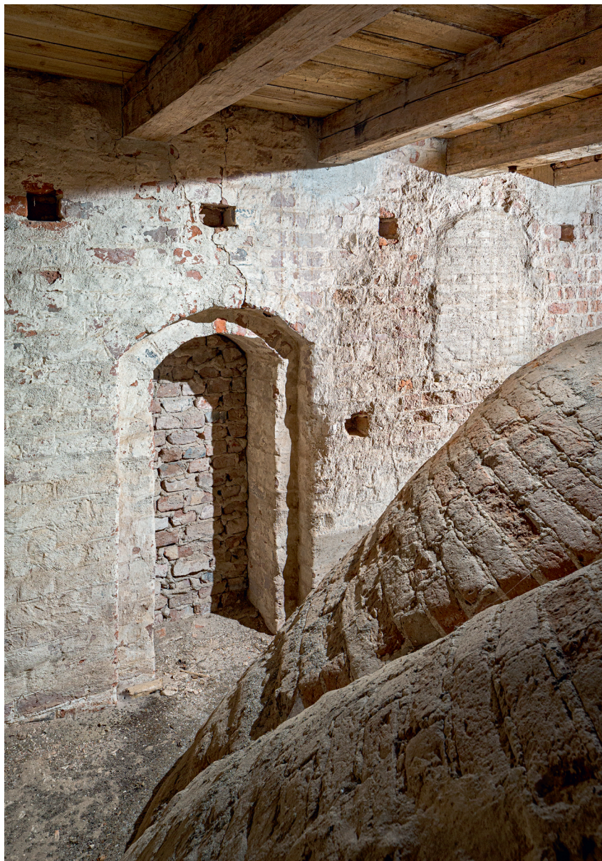
Fig. 12. Blændet dør og vindue i sydsiden af tårnets mellemstokværk (s. 5780). Foto Arnold Mikkelsen 2019. – Bricked-up door and window on the south side of the tower's middle floor.
