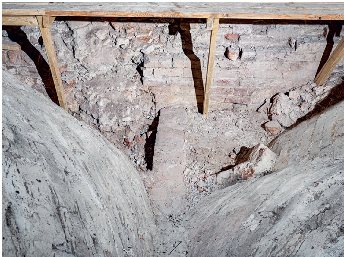
Fig. 92. Kontramuring i syd, i overgangen mellem det ombyggede skib og vestforlængelsen (s. 6018). Foto Arnold Mikkelsen 2020. – Counter masonry in the south, in the transition between the rebuilt nave and the western extension.
