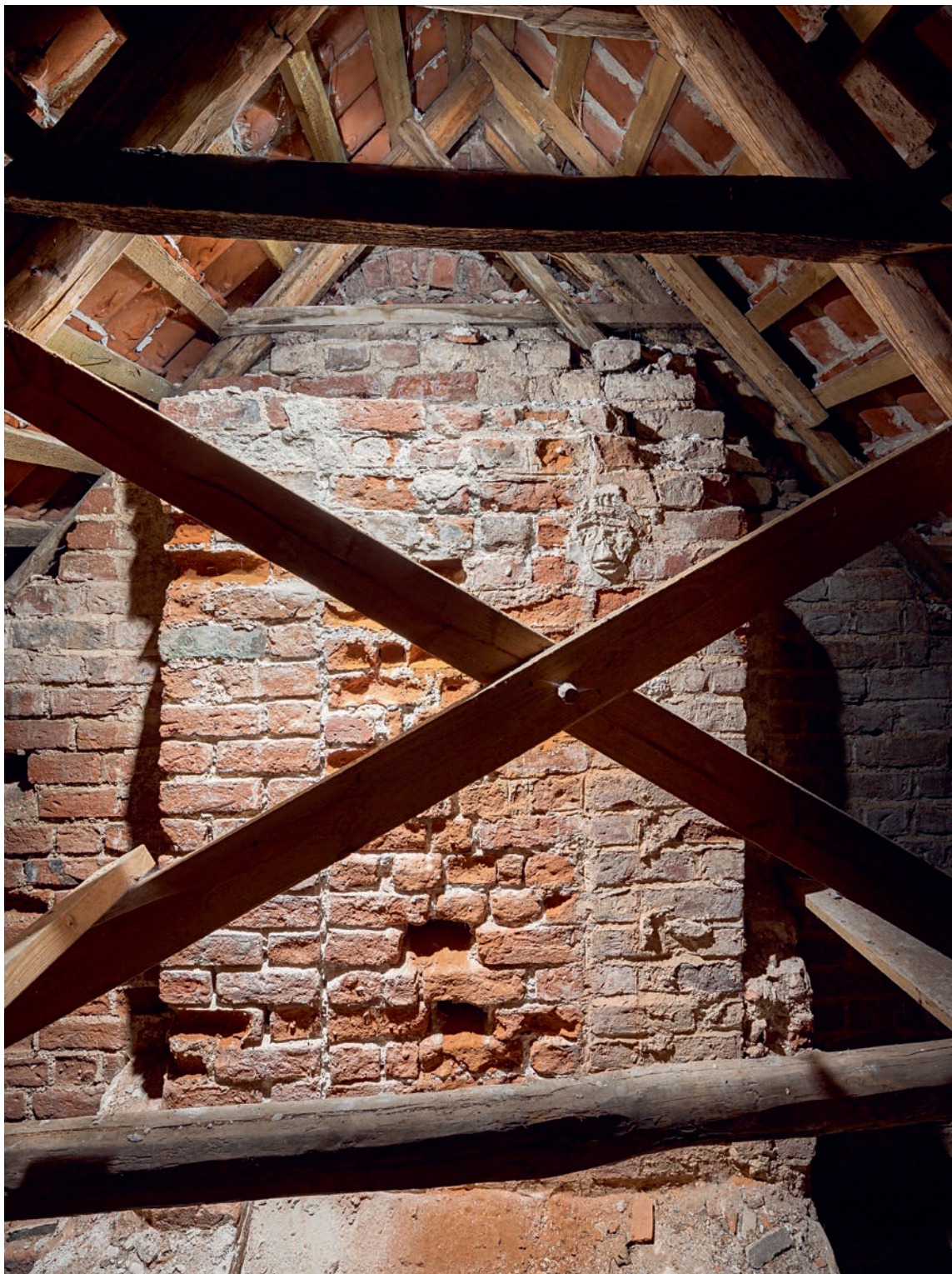
Fig. 27. Forstærkning til \dagger messeklottespir på korgavlens inderside (s. 6015). Foto Arnold Mikkelsen 2020. – Reinforcement for the \dagger belfry spire on the inside of the chancel gable.
