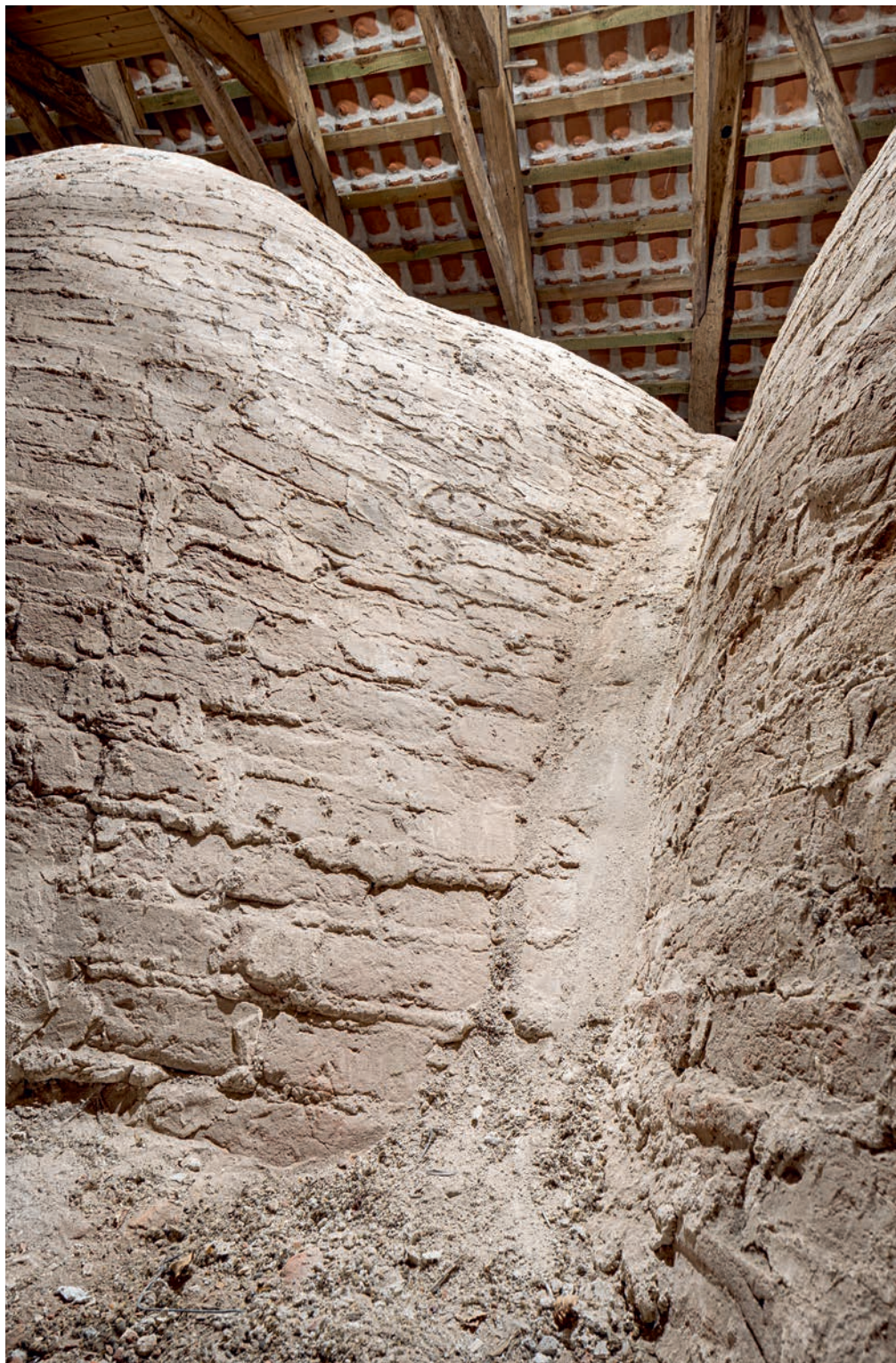
Fig. 26. Korets ommurede østkappe i tagrummet set fra syd (s. 6005 og 6007). Foto Arnold Mikkelsen 2020. – Rebuilt eastern severy in the loft seen from the south.
