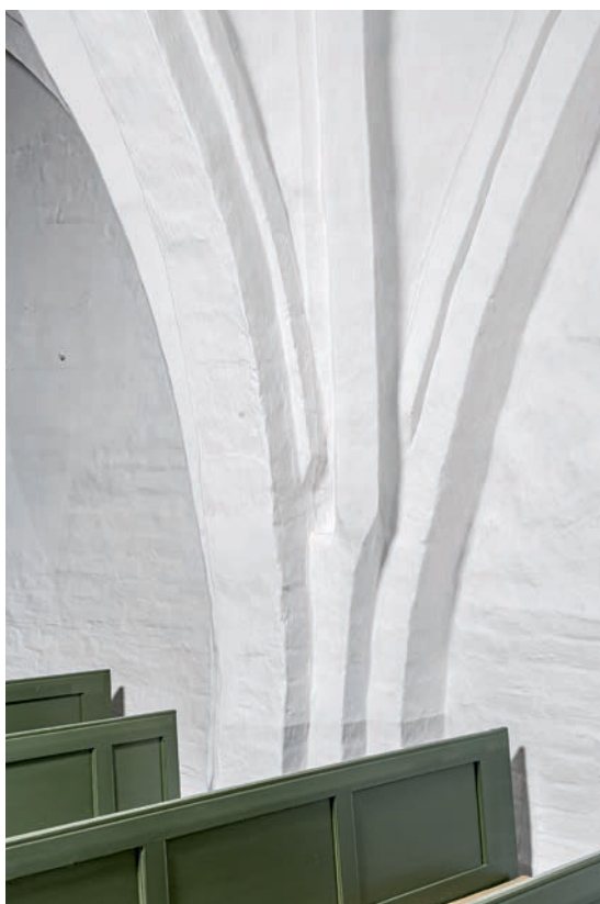
Fig. 34. Hvælpille mellem oprindeligt skib og skibets vestforlængelse i nord (s. 6018). Foto Arnold Mikkelsen 2020. – Vault pier between the original nave and the western extension of the nave in the north.
