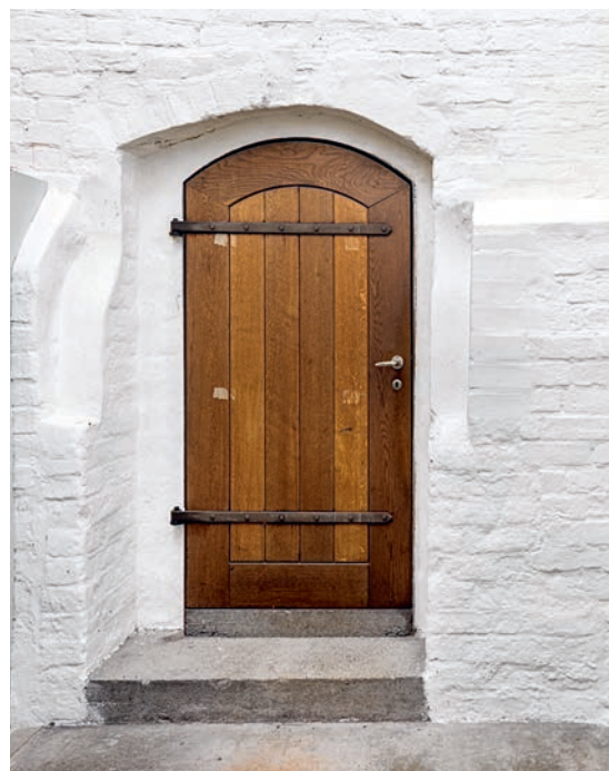
Fig. 40. Sekundær dør i vestforlængelsens vestgavl (s. 6020). Foto Arnold Mikkelsen 2021. – Secondary door in the west gable of the western extension.
