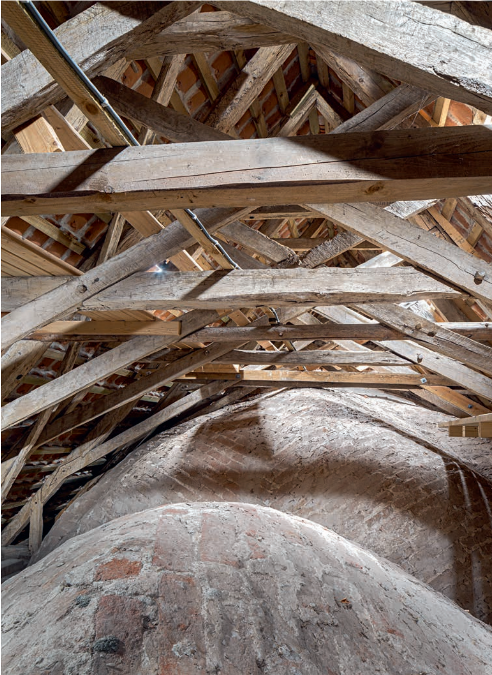
Fig. 46. Korets tagværk, oversigt, set mod øst (s. 6028). Foto Arnold Mikkelsen 2020. – Roofing of the chancel, general view, looking east.
