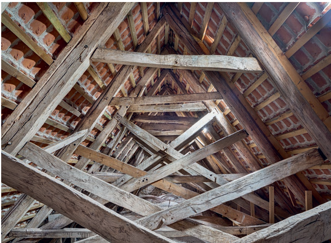
Fig. 47. Skibets tagværk, oversigt, set mod øst (s. 6028). Foto Arnold Mikkelsen 2020. – Roofing of the nave, general view, looking east.
