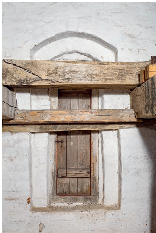
Fig. 39. Det forhøjede tårns klokkestokværk med glamhul med trækarm (s. 6020) samt indmurede remme til klokkestolen (s. 6029). Foto Arnold Mikkelsen 2020. – The belfry floor of the heightened tower with a belfry light with wooden frame plus walled-in straps for the bell frame.
