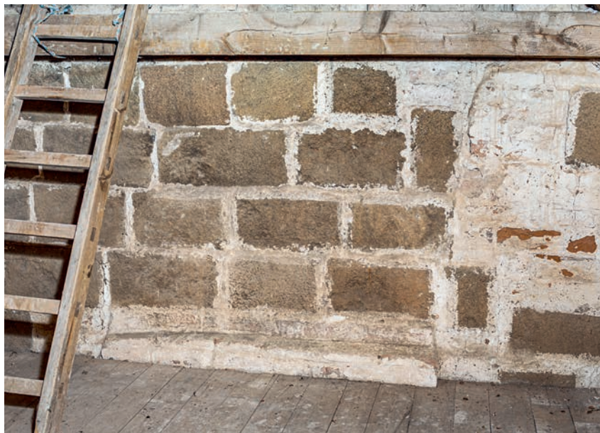
Fig. 11. Skibets ombyggede syddør med portalfremspring (s. 6002), her over våbenhusets loft. Foto Arnold Mikkelsen 2020. – Rebuilt south door of the nave with portal projection, here above the ceiling of the porch.
