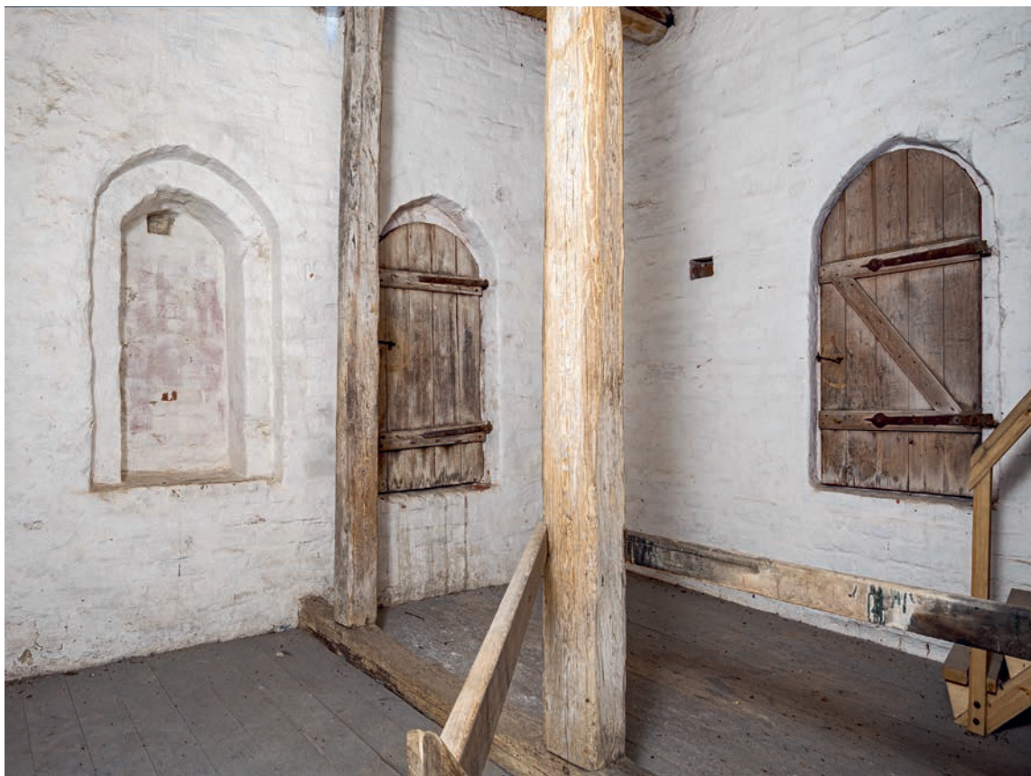
Fig. 20. Tårnets første klokkestokværk med glamhuller, set mod nordvest (s. 6007). Foto Arnold Mikkelsen 2020. – The first belfry floor of the tower with belfry lights, looking north west.
