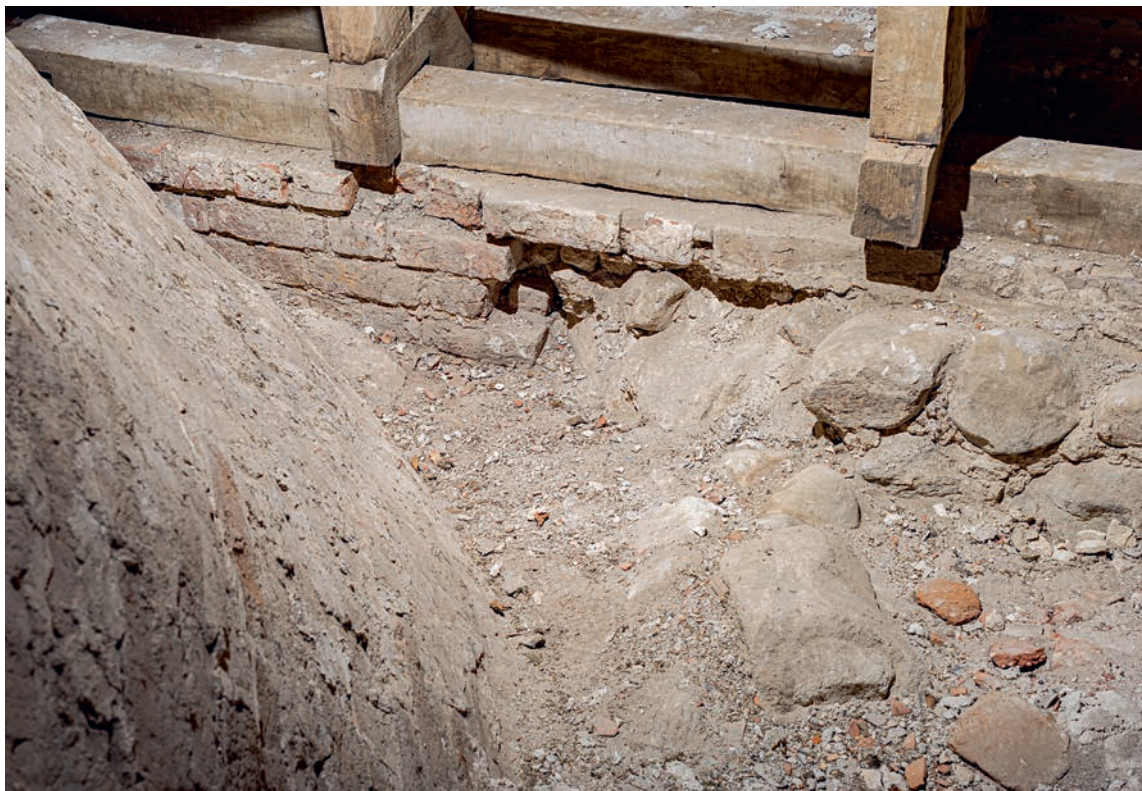
Fig. 28. Overgang mellem kor og korforlængelse i syd i tagrummet (s. 6007). Foto Arnold Mikkelsen 2020. – Transition between chancel and chancel extension in the south of the loft.
