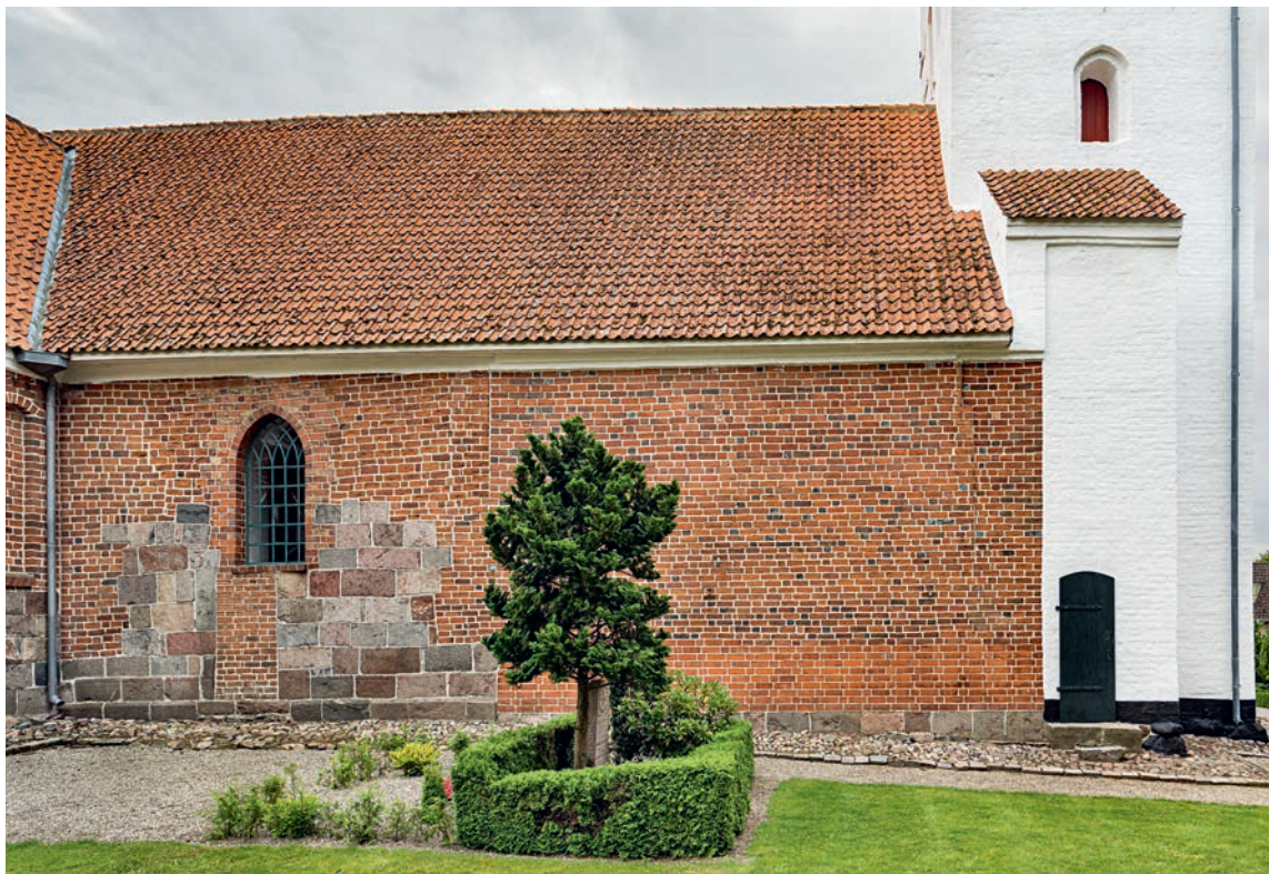
Fig. 14. Skibets nordside med oprindelig \dagger dør (s. 6001), senromansk ombygning (s. 6002), senmiddelalderlig vestforlængelse (s. 6005) samt tårn med trappehus (s. 6007), set fra nord. Foto Arnold Mikkelsen 2020. – North side of the nave with original \dagger door, Late Romanesque rebuilding, Late Medieval western extension and tower with stairwell, seen from the north.
