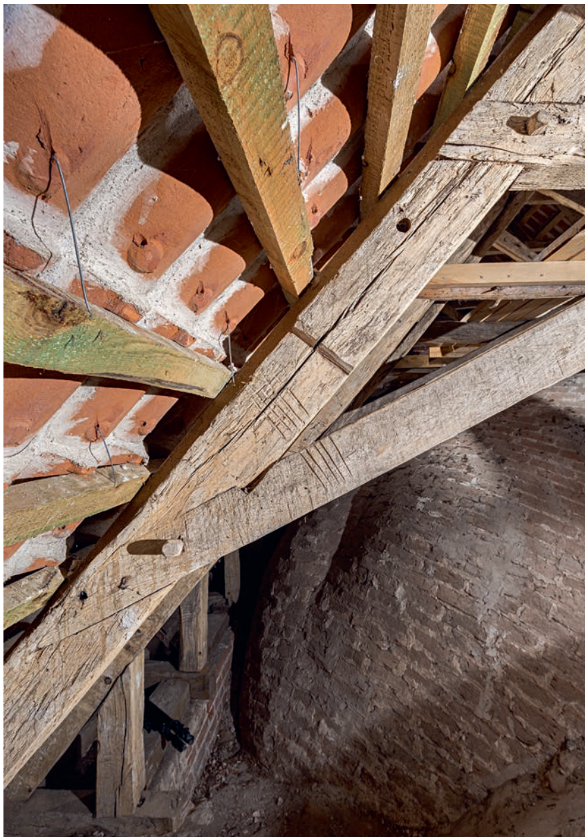
Fig. 95. Korets tagværk, nordside med stregnummerering (s. 6028). Foto Arnold Mikelsen 2020. –Roofing of the chancel, north side with stroke numbering.
