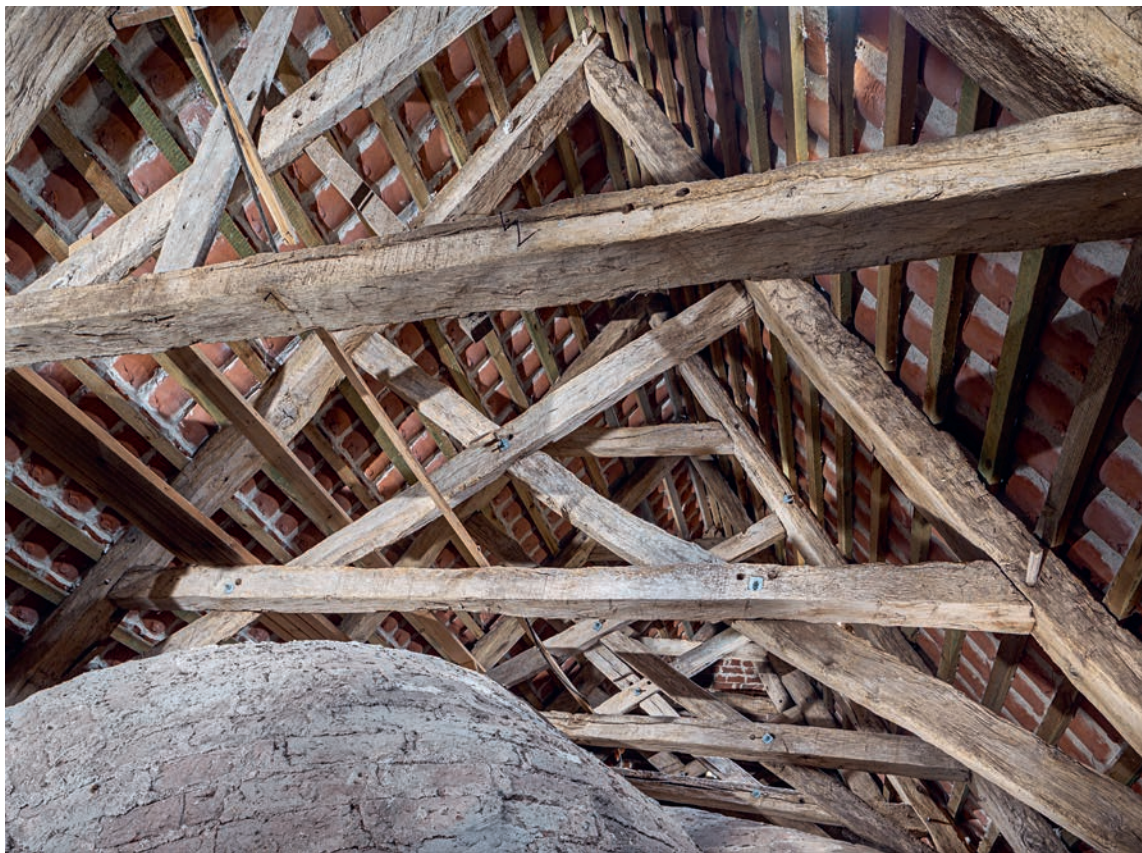
Fig. 93. Kapellets tagværk, oversigt, set mod nord (s. 6028). Foto Arnold Mikkelsen 2020. – Roofing of the chapel, general view, looking north.
