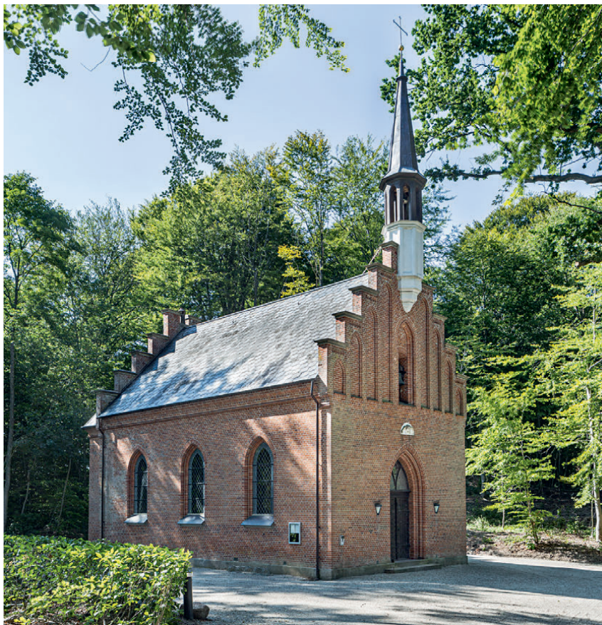
Fig. 1. Kapellet set fra sydøst. Foto Arnold Mikkelsen 2020. – The chapel, seen from the south east.
