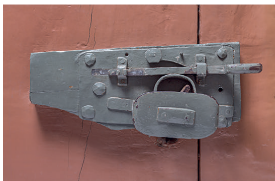
Fig. 57. Låsekasse fra bagsiden af den jernbundne dør (s. 6282). Foto Arnold Mikkelsen 2020. – Lock case from the back of the iron-bound door.
