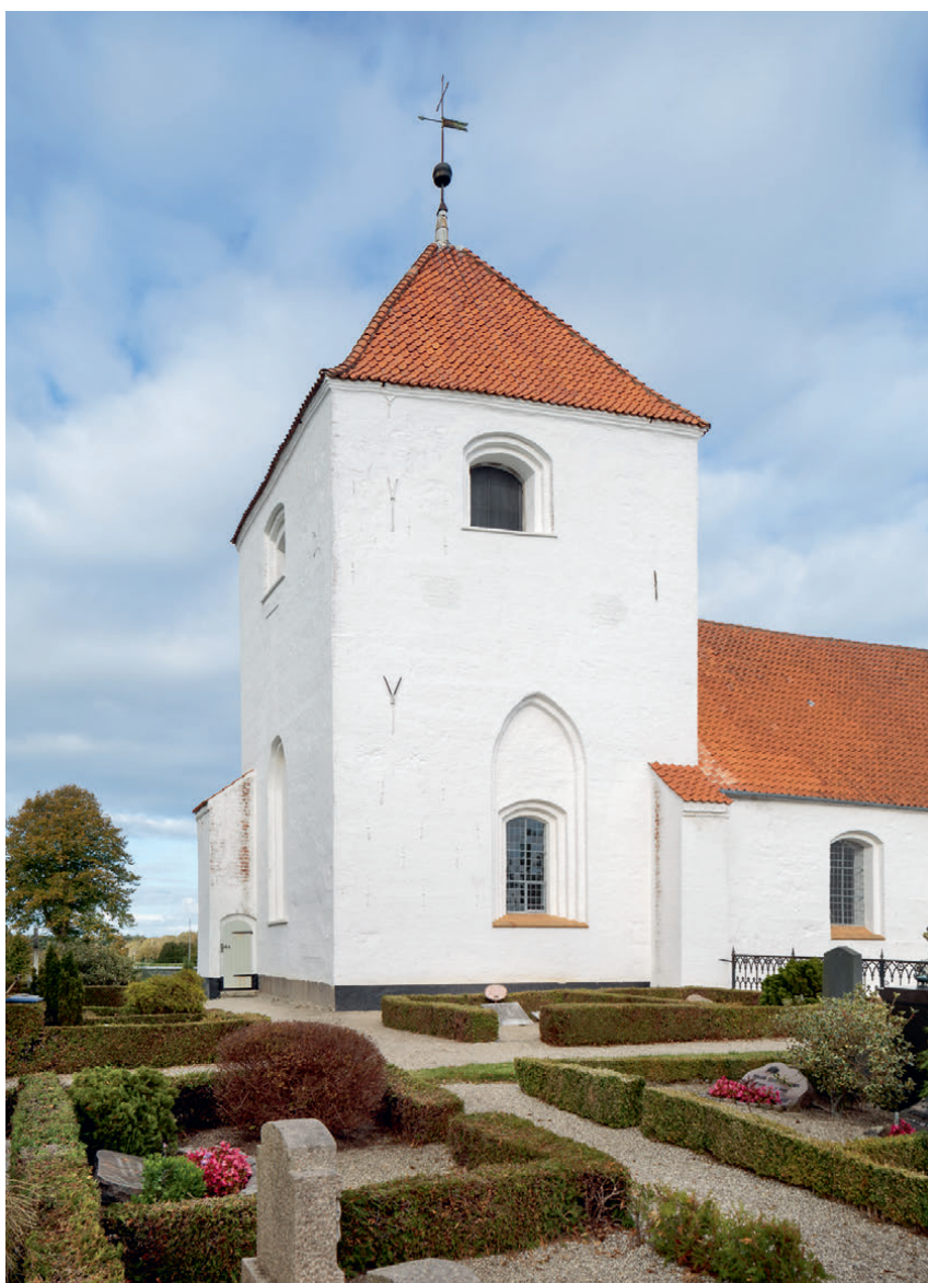
Fig. 15. Tårnet set fra sydvest (s. 6248). Foto Arnold Mikkelsen 2020. – Tower seen from the south west.
