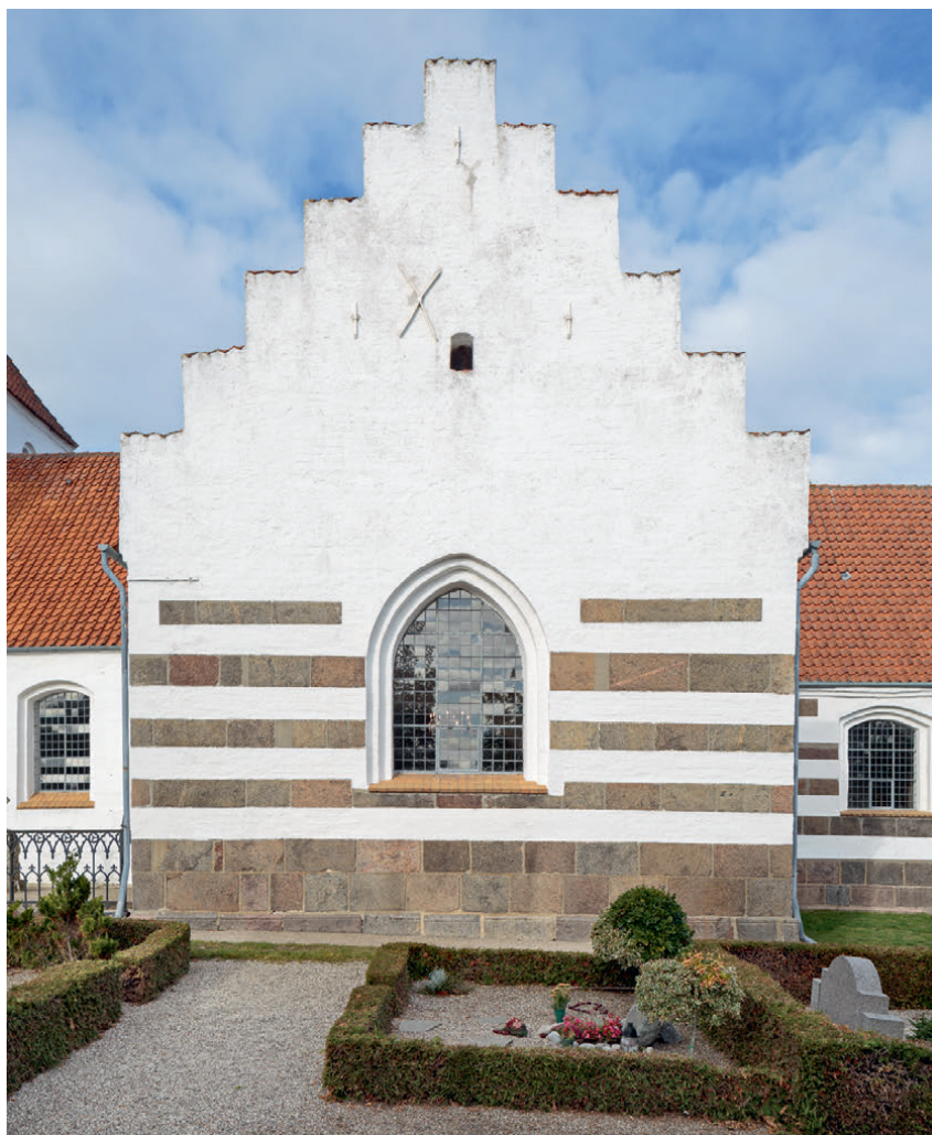
Fig. 12. Søndre kapels sydfacade (s. 6244). Foto Arnold Mikkelsen 2020. — South facade of southern chapel.
