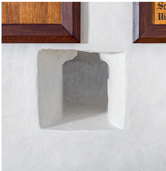
Fig. 10. Blændet glug i våbenhusets vestmur (s. 6243). Foto Arnold Mikkelsen 2020. – Bricked-up peephole in west wall of porch.
