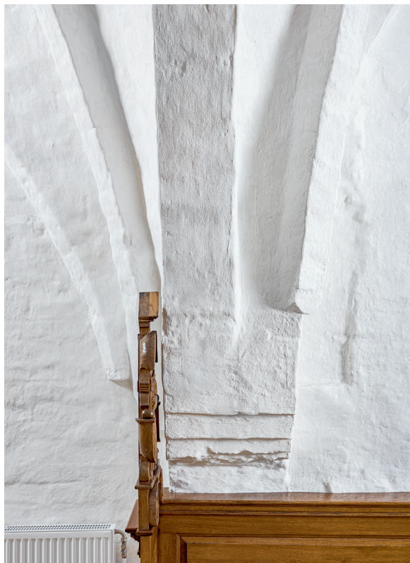
Fig. 19–20. 19. Sammenstødet mellem kor og korforlængelse, indre, syd (s. 6550). 20. Hvælvribber i korets nordøsthjørne (s. 6551). Foto Arnold Mikkelsen 2021. – 19. Meeting of the chancel and chancel extension, interior, south. 20. vault ribs in the chancel's north east corner.
