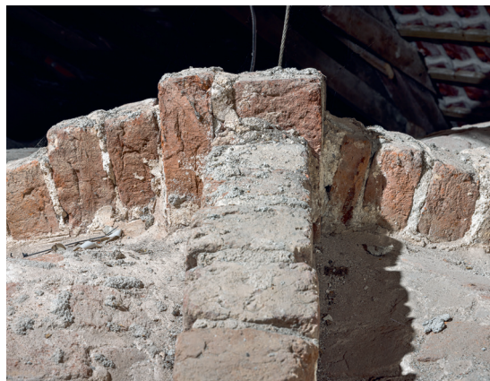
Fig. 114. Det oprindelige kors hvælv med overribber af rulskeftestillede sten, der i toppen mødes i en helstens høj 'slutsten' (s. 6553). Foto Arnold Mikkelsen 2022. – The original chancel vault with upper ribs consisting of rowlock courses of stones that meet at the top with a whole-brick-high 'keystone'.
