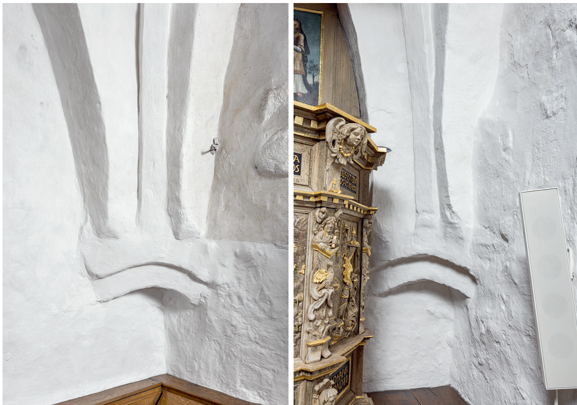
Fig. 33–34. Tromber i skibets østhjørner (s. 6563). 33. Nordøst. 34. Sydøst. Foto Arnold Mikkelsen 2021. – Squinches in the nave's east corners. 33. North east. 34. South east.
