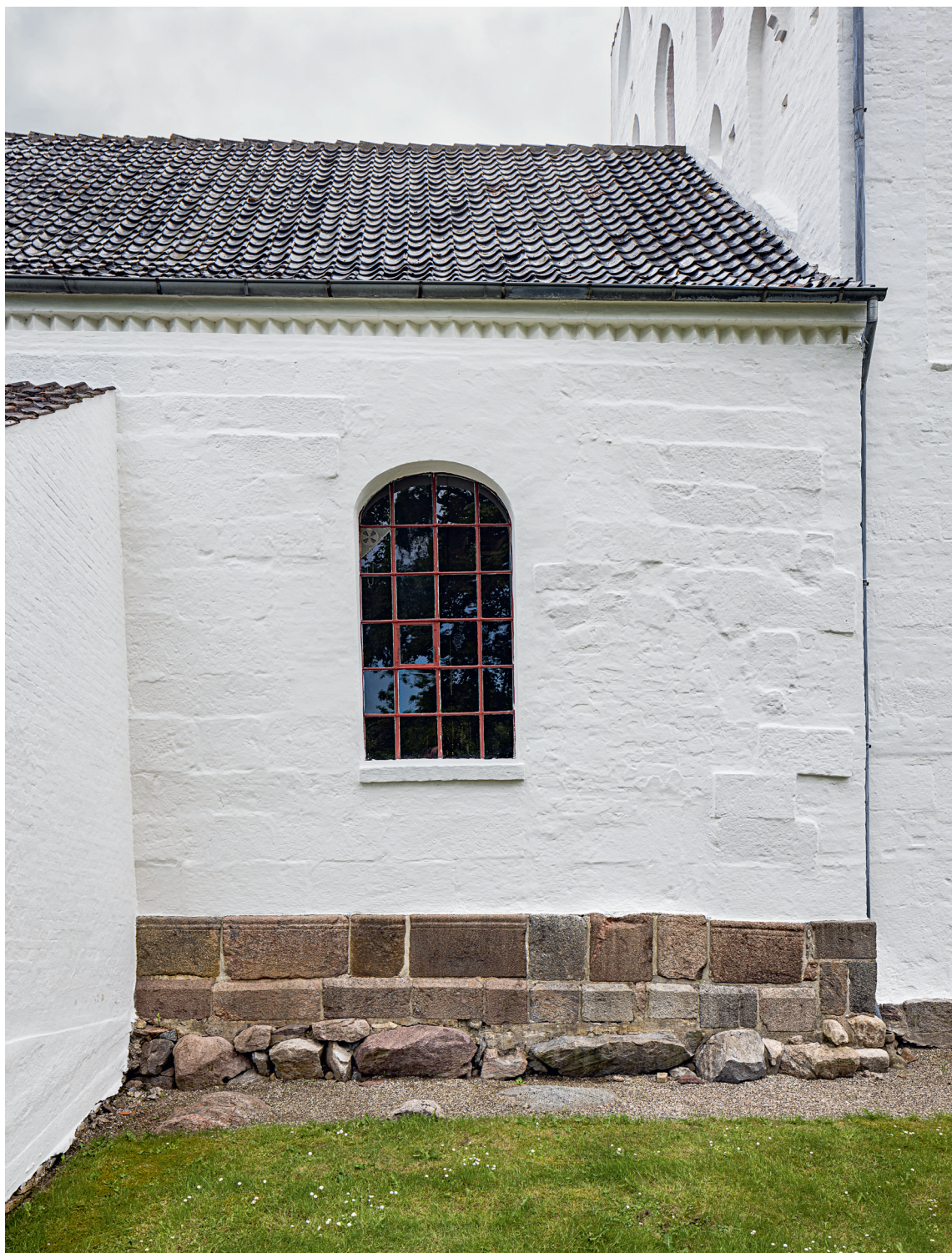
Fig. 10. Vestre del af skibets nordside med ombygning af nordvestre hjørne (s. 6554) samt †norddør (s. 6545), set fra nord. Foto Arnold Mikkelsen 2021. — Western part of the north facade of the nave with rebuilding of the north west corner and the †north door, seen from the north.
