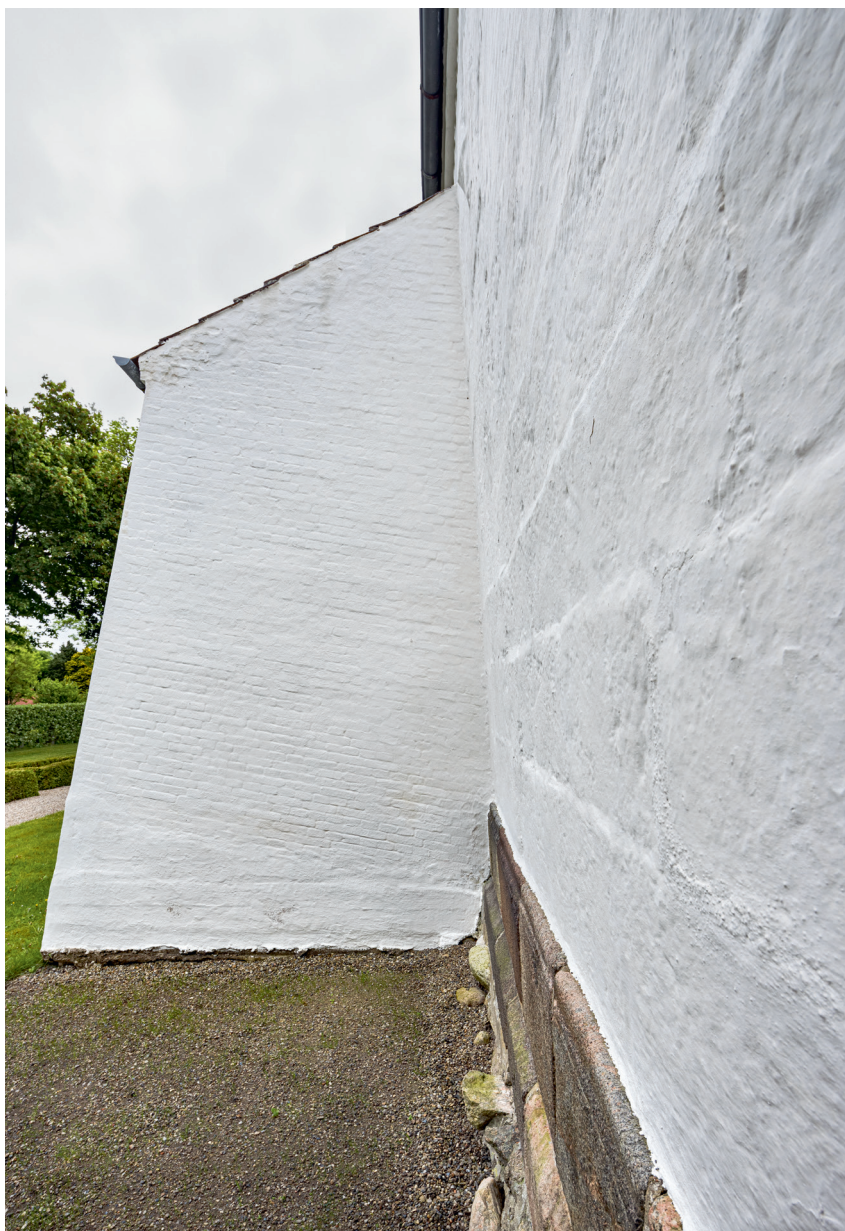
Fig. 38. Skibets udadhældende nordside med støttepille (s. 6572). Foto Arnold Mikkelsen 2022. – The outwardly leaning north side of the nave with buttress.
