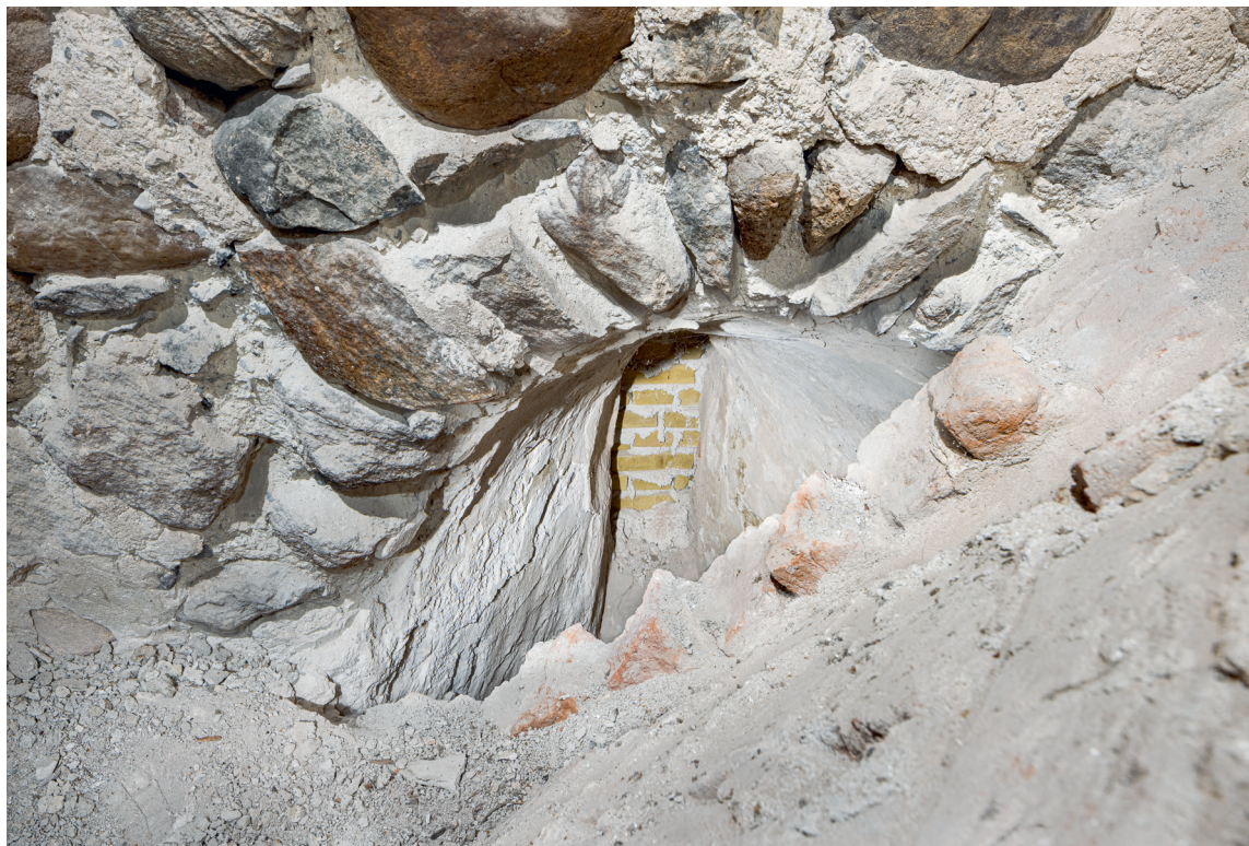
Fig. 13. Romansk \uparrow vindue i skibets sydside (s. 6545), set fra loftet. Foto Arnold Mikkelsen 2022. – Romanesque \uparrow window in the south side of the nave, seen from the loft.
