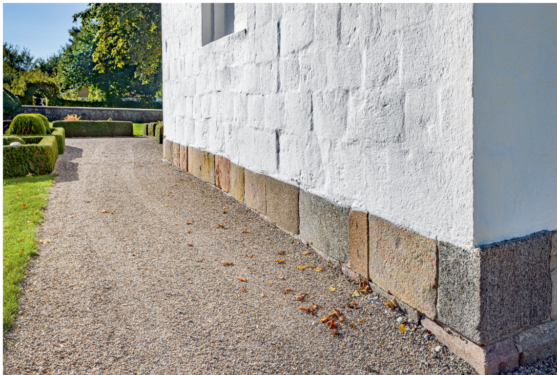
Fig. 7. Korforlængelsens østgavl (s. 6550) med genanvendte buede kvadre fra \dagger apsis, set fra nordøst. Foto Arnold Mikkelsen 2021. – The chancel extension's east gable wall with re-used curved ashlars from the \dagger apse, seen from the north east.
