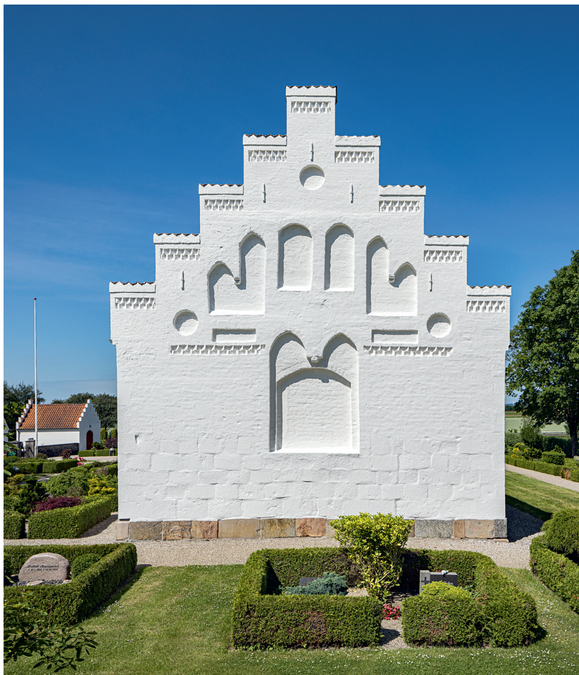
Fig. 17. Korforlængelsens østgavl (s. 6550). Foto Arnold Mikkelsen 2021. – The chancel extension's east gable.
