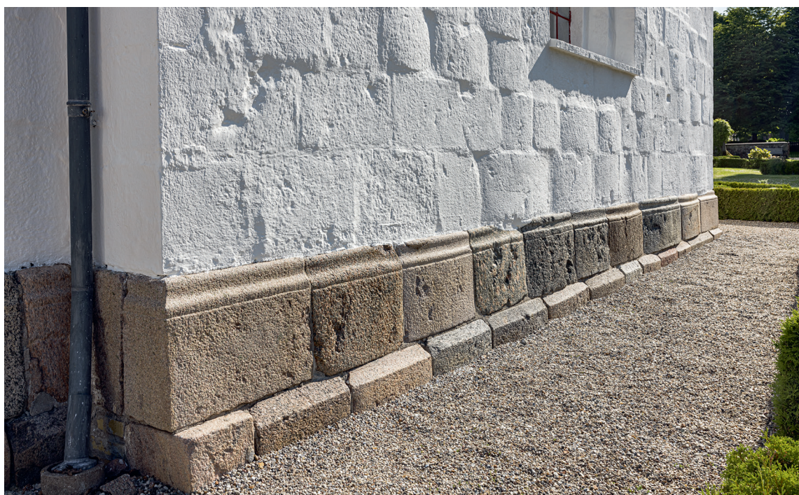
Fig. 7. Korforlængelsens østgavl (s. 6550) med genanvendte buede kvadre fra \dagger apsis, set fra nordøst. Foto Arnold Mikkelsen 2021. – The chancel extension's east gable wall with re-used curved ashlars from the \dagger apse, seen from the north east.
