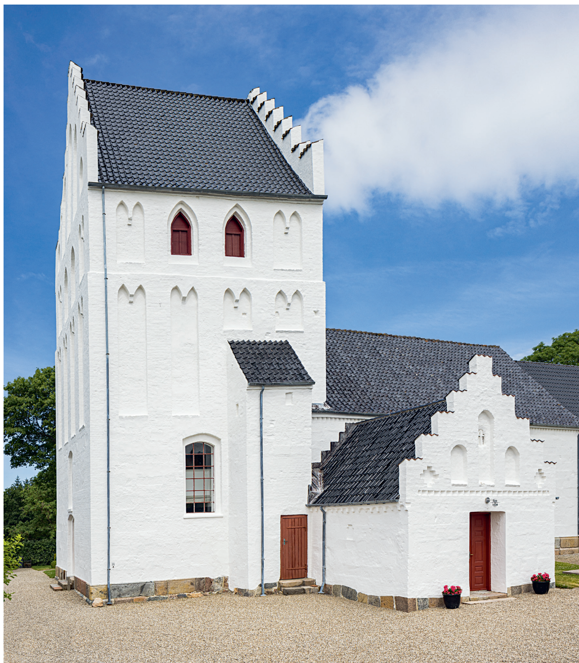
Fig. 25. Tårn (s. 6556), trappehus (s. 6558) og våbenhus (s. 6562) set fra sydvest. Foto Arnold Mikkelsen 2021. – Tower, stairwell and porch seen from the south west.
