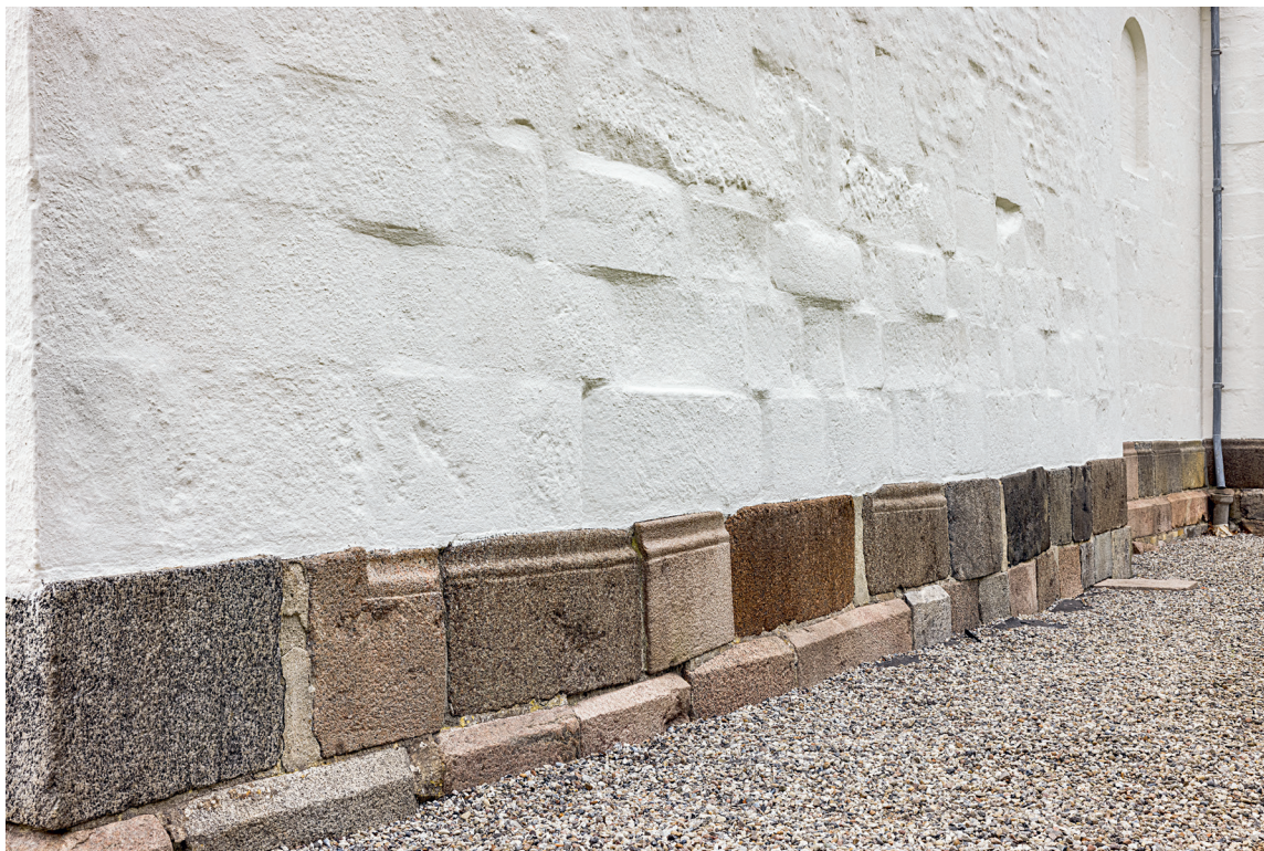
Fig. 9. Korforlængelsens nordside med genanvendte sokkelsten (s. 6550 og jf. fig. 37) og buede kvadre fra tåpsiden (s. 6550), set fra nordøst. Foto Arnold Mikkelsen 2021. – The chancel extension's north side with re-used footing stones and curved ashlars from the tåpse, seen from the north east.
