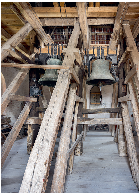
Fig. 43. Klokkestolen (s. 6569) set fra syd. Foto Arnold Mikkelsen 2021. – Bell frame seen from the south.
