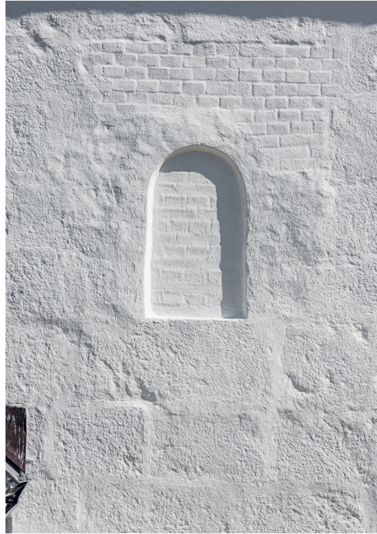
Fig. 110. Ombygget romansk vindue i skibets sydside (s. 6549). Foto Arnold Mikkelsen 2021. – Rebuilt Romanesque window in the nave's south side .
