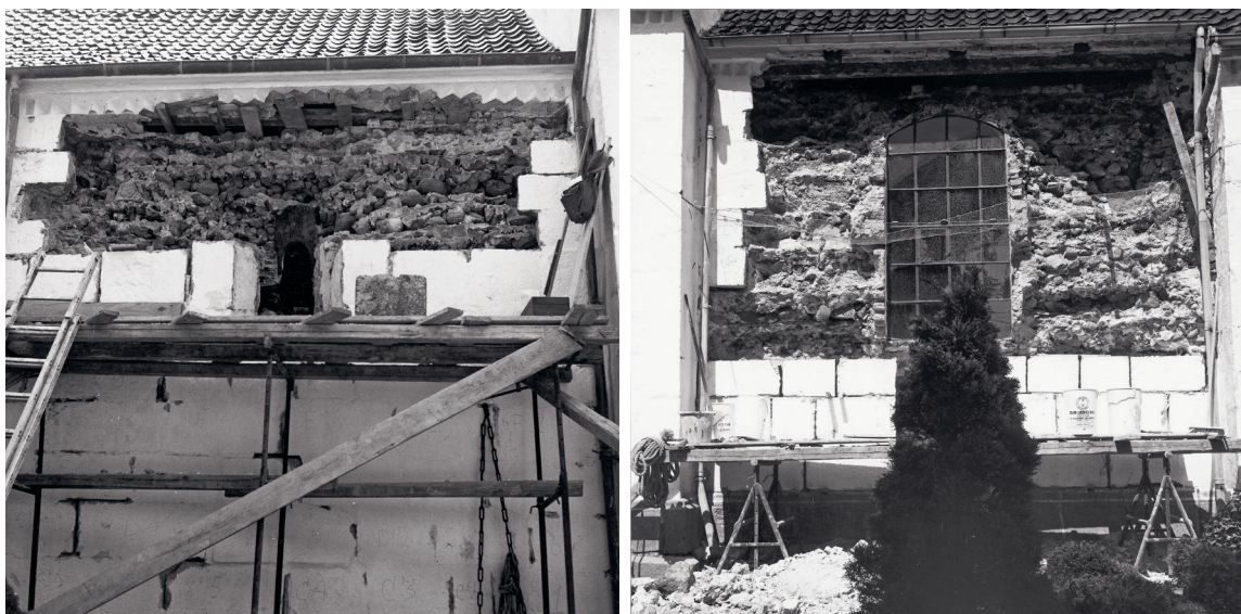
Fig. 106-07. Kvadermur i det oprindelige kors under nedtagning (s. 6566). 106. Nordsiden. 107. Sydsiden. Foto Birgit Als Hansen 1983. I NM – Ashlar walls in the original chancel being taken down. 106. North side. 107. South side.
