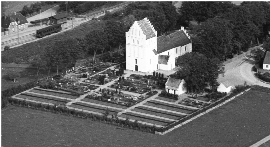
Fig. 2. Luftfoto af Asperup Kirke set fra sydvest. Foto Aalborg Luftfoto o. 1948-52. I KB. – Aerial photograph of Asperup Church seen from the south west.
