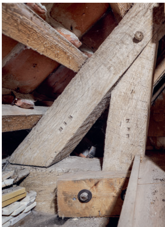
Fig. 90. Våbenhusets tagværk (s. 6666, jf. fig. 29), 3. spærfag set fra syd, vestre spærfod. Foto Arnold Mikkelsen 2024. — Third truss seen from the south, western strutting beam.
