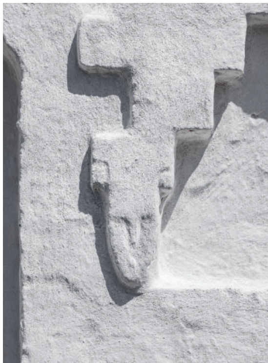
Fig. 6. Detalje på korets sydmur (s. 6649). Foto Arnold Mikkelsen 2023. – Detail on the chancel's south wall.
