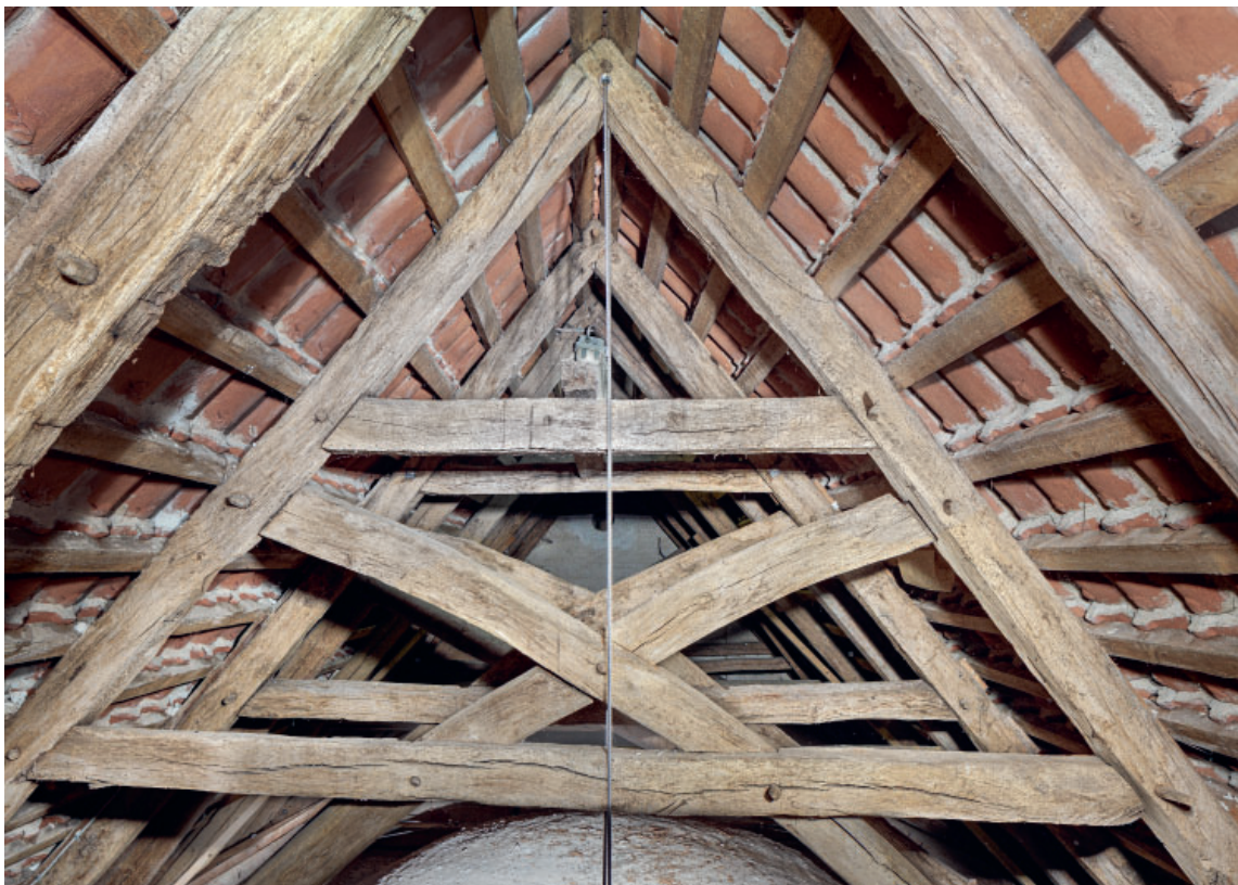
Fig. 25. Skibets vestforlængelses vestligste spærfag (s. 6665), set mod vest. Foto Arnold Mikkelsen 2024. – The westernmost trusses of the nave's western extension.
