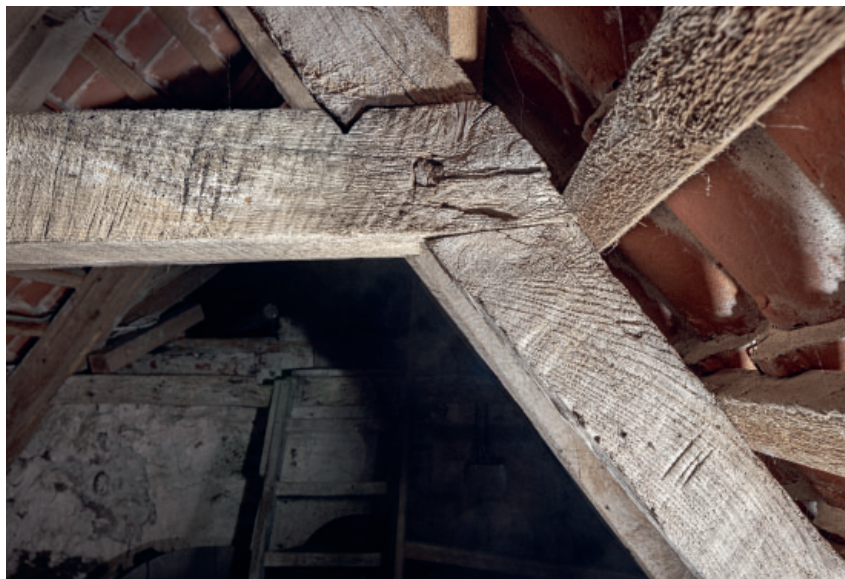
Fig. 89. Våbenhusets tagværk (s. 6666, jf. fig. 29), 3. spærfag set fra syd, del af hanebånd. Foto Arnold Mikkelsen 2024. — Porch roofing. Third truss seen from the south, part of collar beam.
