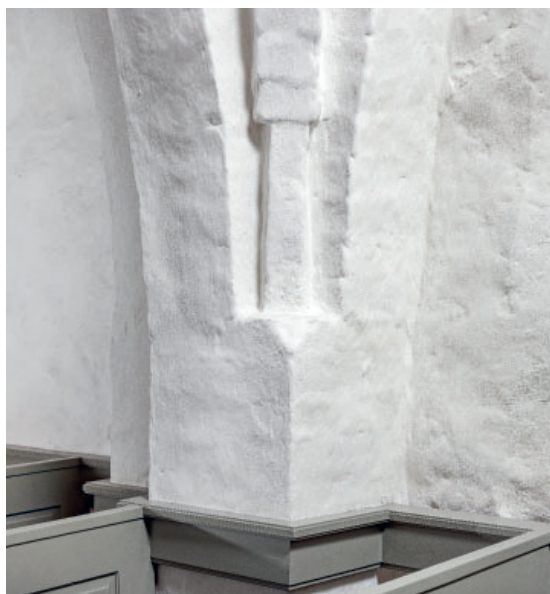
Fig. 15. Hvælpille i skibets nordvesthjørne (s. 6651), set mod nordvest. Foto Arnold Mikkelsen 2023. – Vault pier in the nave's north west corner, looking north west.
