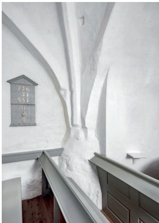
Fig. 16. Hvælpille i skibets nordøsthjørne (s. 6651), set mod nordøst. Foto Arnold Mikkelsen 2023. – Vault pier in the nave's north east corner, looking north east.
