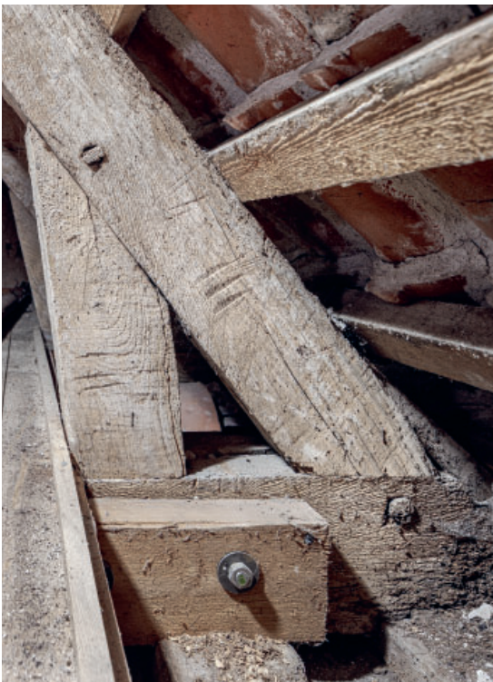
Fig. 91. Våbenhusets tagværk (s. 6666, jf. fig. 29), 3. spærfaq set fra syd, østre spærfod. Foto Arnold Mikkelsen 2024. – Third truss seen from the south, eastern strutting beam.
