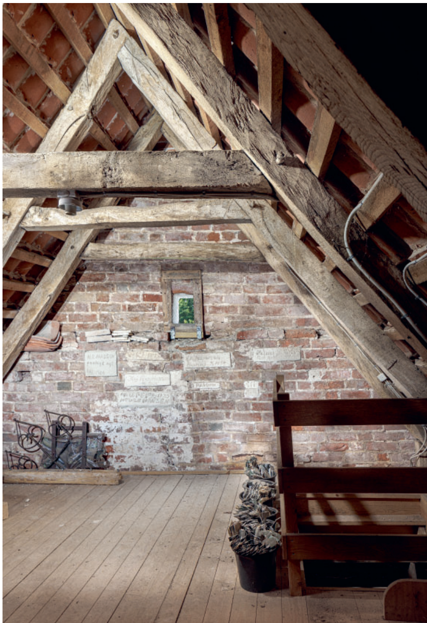
Fig. 29. Våbenhuset tagværk (s. 6666), set fra nord. Foto Arnold Mikkelsen 2024. – Roofing of the porch seen from the north.
