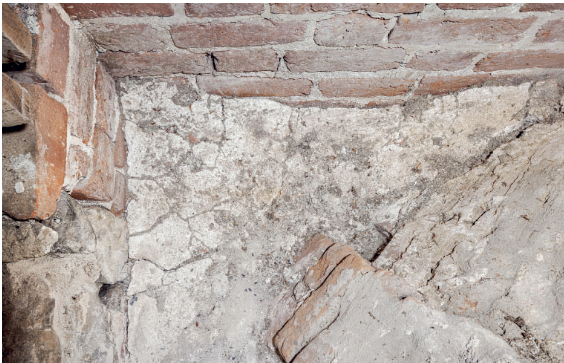
Fig. 87. Korets nordøsthjørne med spygat med pudset overflade til afløb (s. 6650). Foto Arnold Mikkelsen 2024. – North east corner of the chancel, scupper with dressed surface for drainage.
