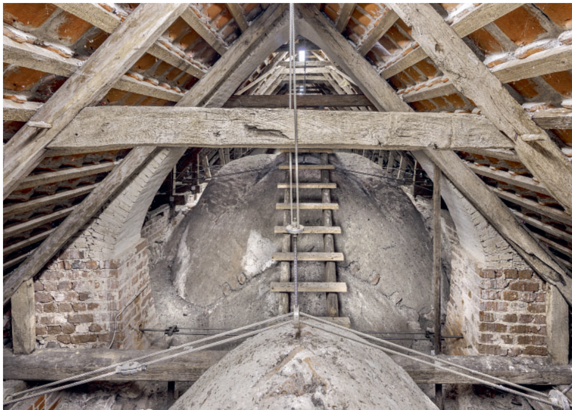
Fig. 22. Bueåbning mellem korets og skibets loftrum (s. 6657), triumfbuens overside (s. 6658) samt korets hvælv (s. 6650). Foto Arnold Mikkelsen 2024. – Archway between lofts of the chancel and nave, top of the chancel arch, and chapel vault.
