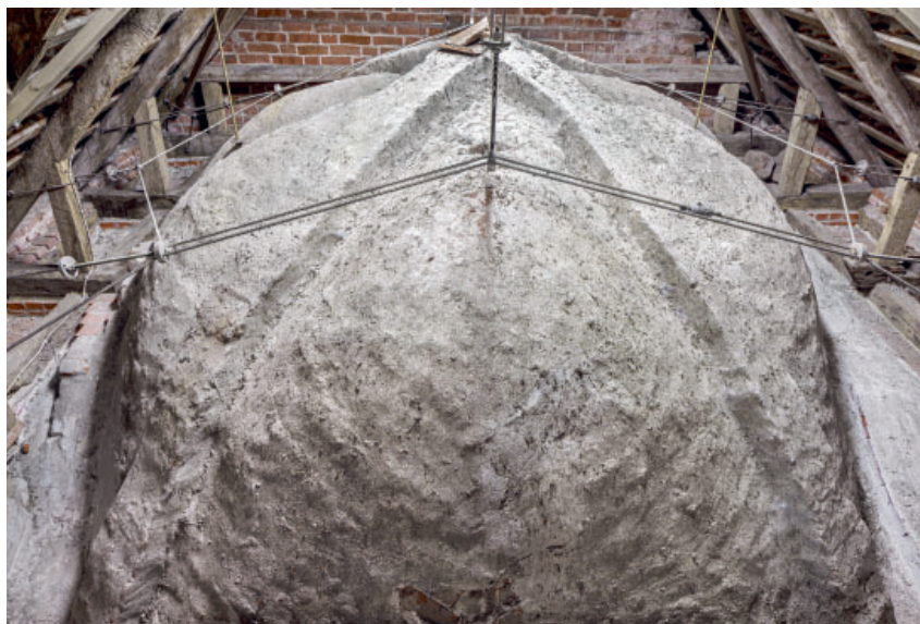
Fig. 23. Oversiden af korets hvælv (s. 6650). Foto Arnold Mikkelsen 2024. – Top of the chancel vault.
