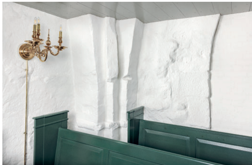
Fig. 24. Hvælvpille i skibets sydvesthjørne (s. 6743) samt tårnbuens søndre vange (s. 6739). Foto Arnold Mikkelsen 2023. – Vault pier in the south west corner of the nave and southern side member of the tower arch.
