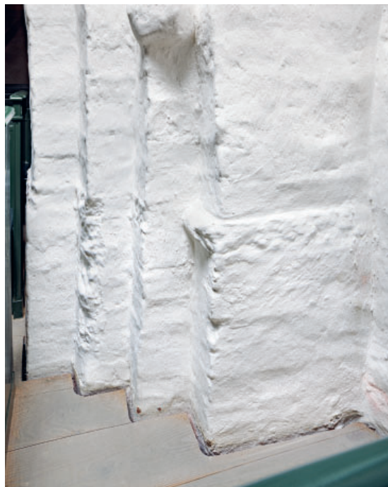
Fig. 117. Skibets nordsides midterste hvælpille (s. 6743). Foto Arnold Mikkelsen 2023. — The middle vault pier in the north side of the nave.
