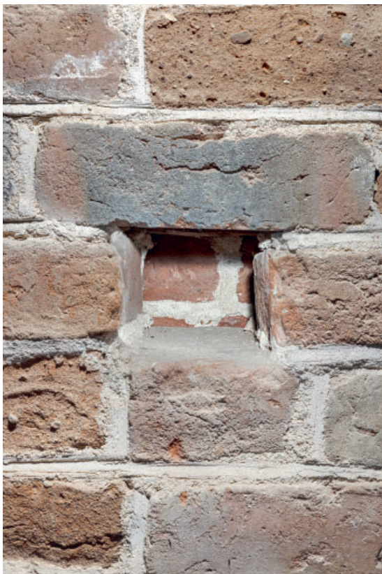
Fig. 29. Udsnit af mellemstokværks skalmurede nordmur (s. 6747). I bunden af bomhullet ses stokværkets oprindelige nordmur (s. 6740). Foto Arnold Mikkelsen 2023. – Part of the intermediate floor's brick-faced north wall. The original north wall of the floor is visible through the putlog hole.
