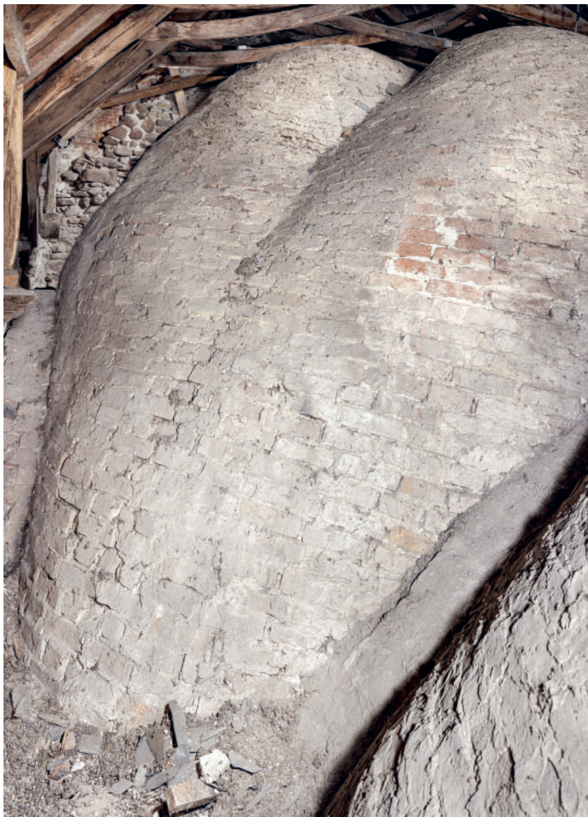
Fig. 119. Skibets østre hvælv (s. 6743) samt kappet bindbjælke til venstre i billedet. (s. 6755). Foto Arnold Mikkelsen 2023. – The nave's eastern vault and cross-cut tie beam to the left.
