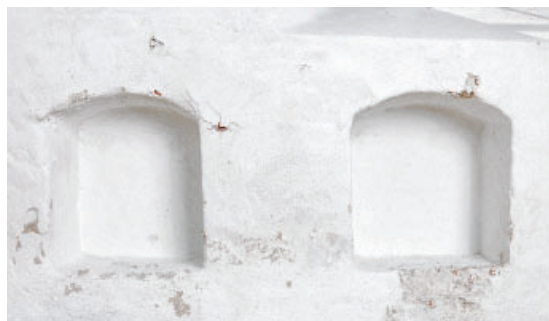
Fig. 28. Nicher i korforlængelsens sydmur (s. 6743). Foto Arnold Mikkelsen 2023. – Niches in the chancel extension's south wall.
