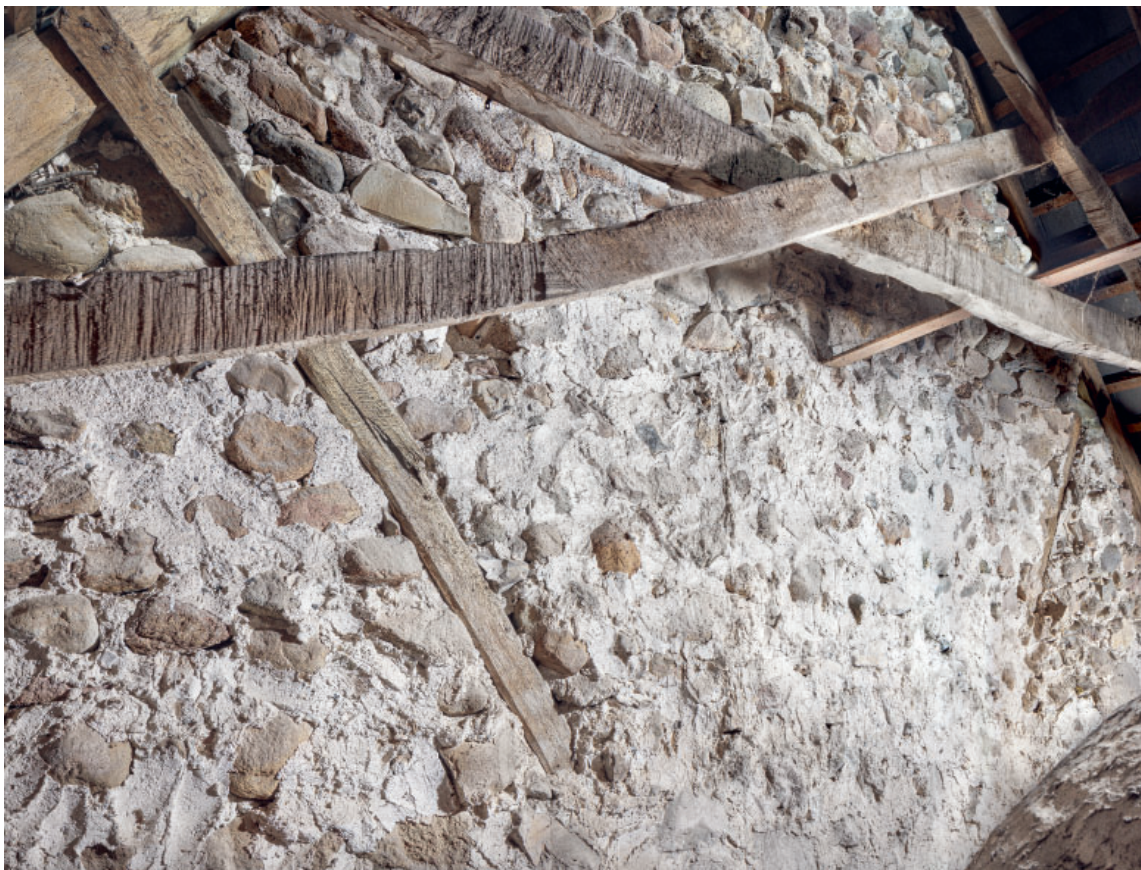
Fig. 42. Rester af oprindeligt tagværk med to bevarede skråstivere (s. 6755) i triumfgavlens vestside. Foto Arnold Mikkelsen 2023. – Remains of original roofing with two preserved struts on the west side of the chancel arch gable.
