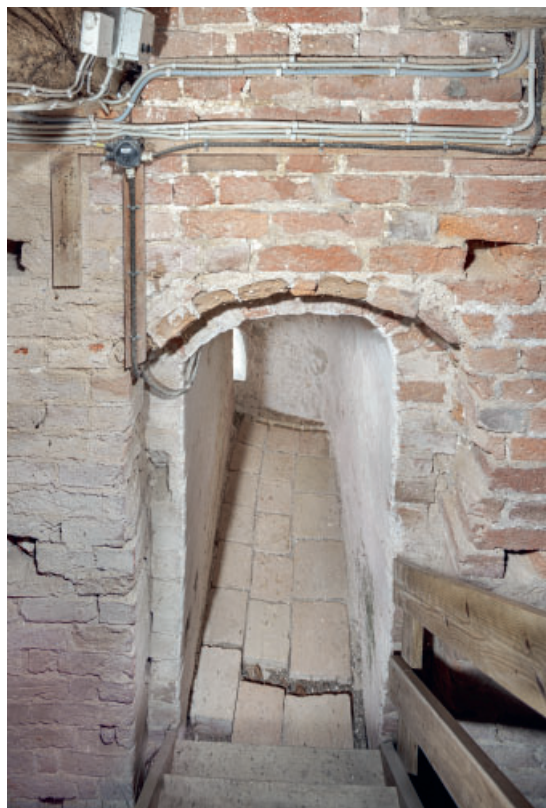
Fig. 30. Tårnets mellemstokværks indre. Overdør (s. 6740) samt sydmur med skalmuring (s. 6748). Foto Arnold Mikkelsen 2023. – Interior of the intermediate floor of the tower. Upper door and south wall with brick facing.
