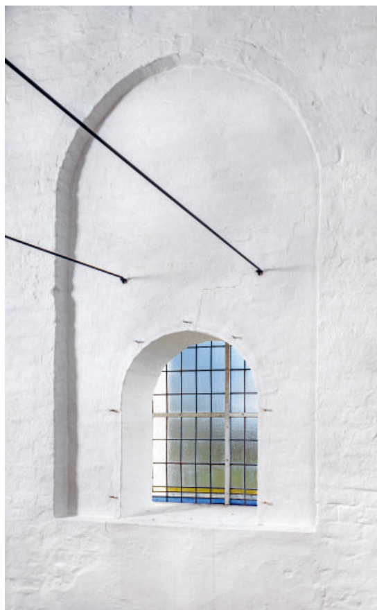
Fig. 115. Korforlængelsens østvindue (s. 6741). Foto Arnold Mikkelsen 2023. – East window of the chancel extension.
