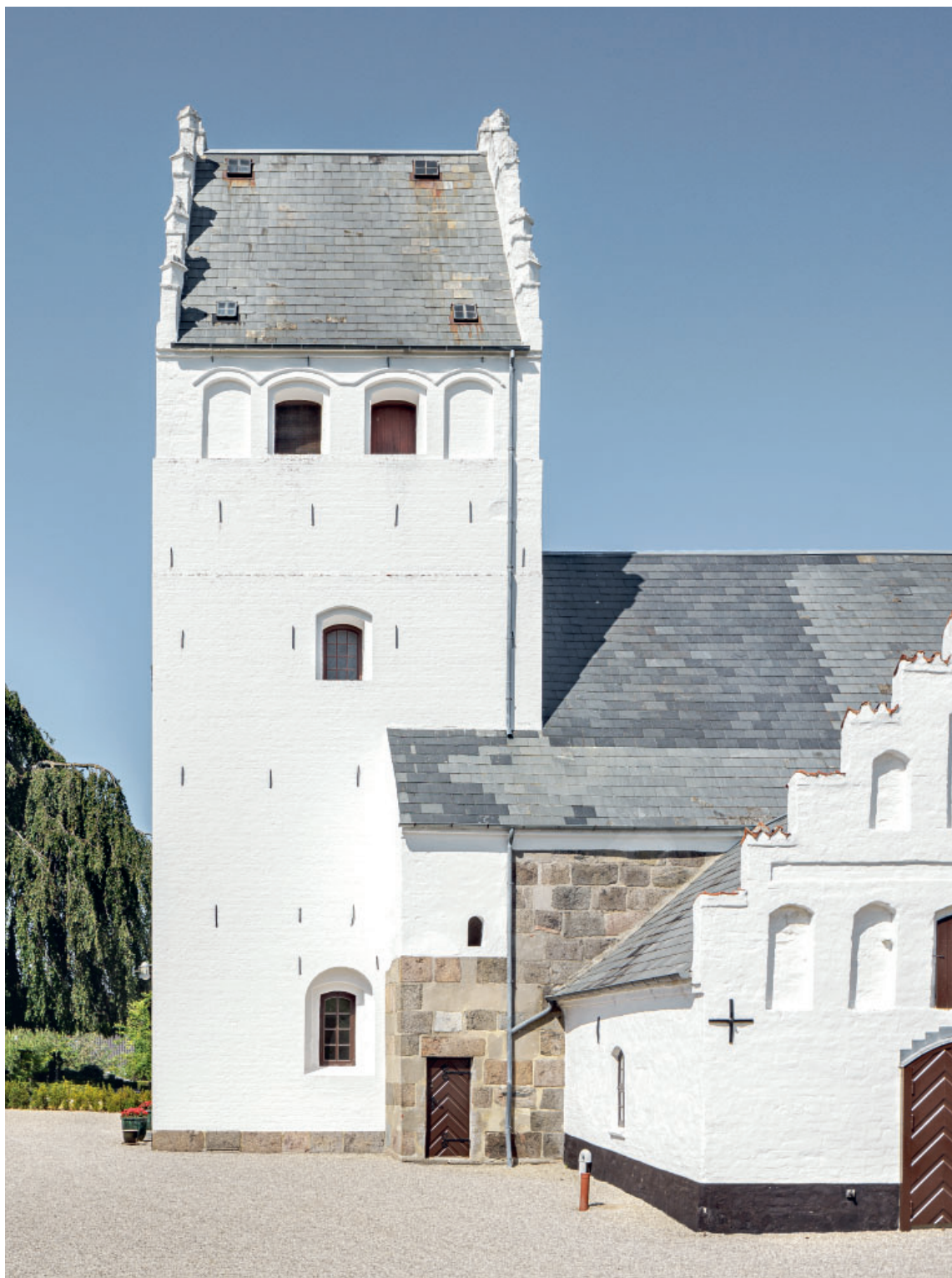
Fig. 19. Tårn (s. 6736), trappehus (s. 6740) og våbenhus (s. 6745) set fra syd. Foto Arnold Mikkelsen 2023. — Tower, stairwell, and porch seen from the south.
