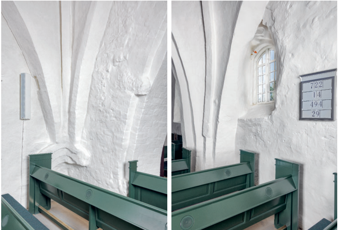
Fig. 22-23. 22. Trompe i skibets nordøsthjørne (s. 6743). 23. Vestre vindue samt gjordbuens pille i skibets søndre sides indre (s. 6753 og 6743). Foto Arnold Mikkelsen 2023. – 22. Squinch in the nave's north east corner. 23. Western window and pier of the reinforcing rib, interior of the nave's south side.
