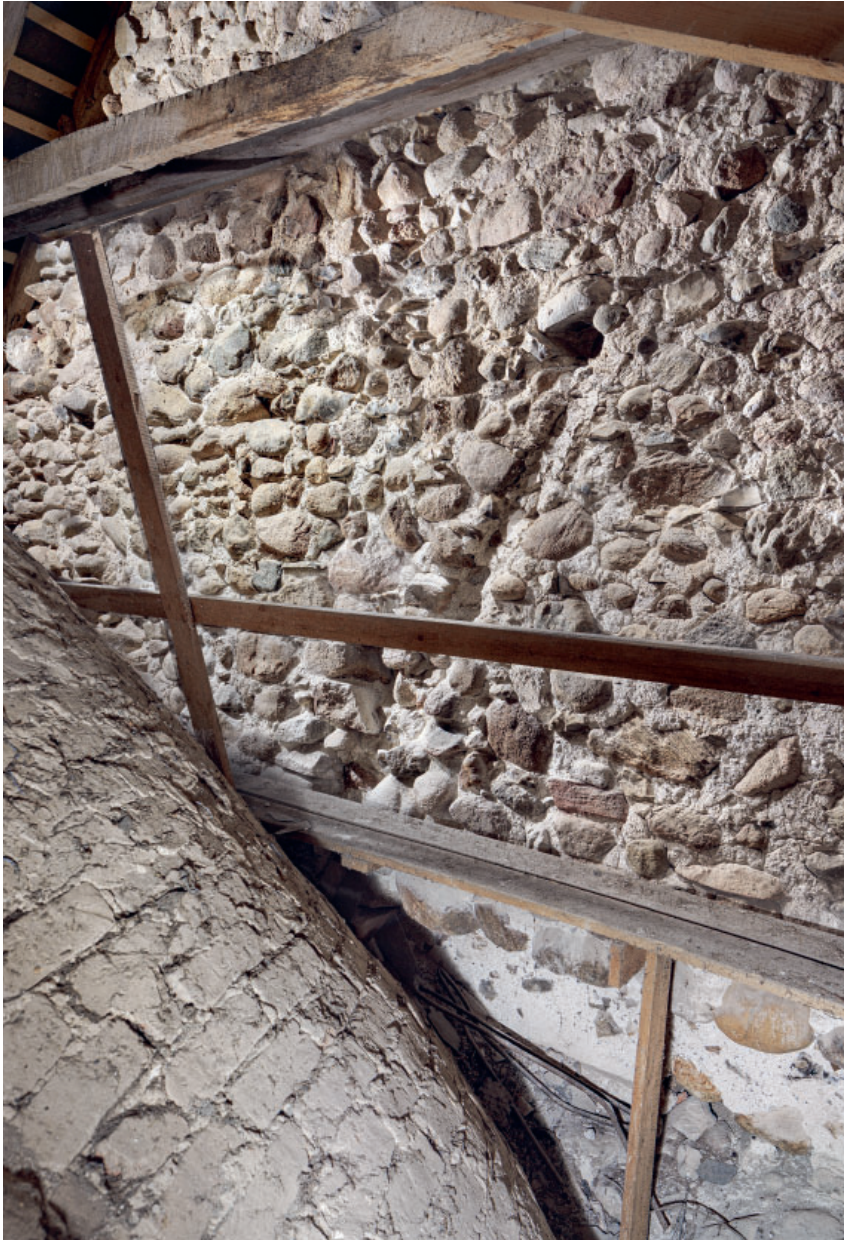
Fig. 43. Spor efter oprindeligt tagværk (s. 6755) i skibets vestgavls inderside. Foto Arnold Mikkelsen 2023. – Traces of original roofing on the interior of the nave's west gable.
