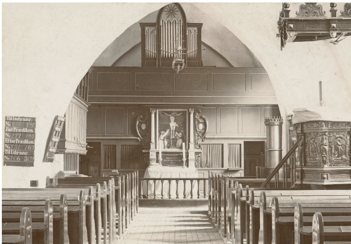
Fig. 53. Indre set mod øst mellem 1890 og 1907/08. Foto i NM. – Interior looking east between 1890 and 1907/8.
