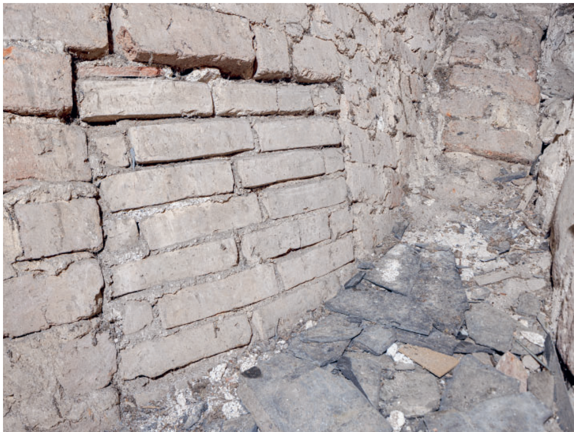
Fig. 118. †Lem i skibets vestre hvælvs sydvesthjørne i søndre kappe (s. 6745). Foto Arnold Mikkelsen 2023. – †Hatch in the south west corner of the western vault, in the south severy.
