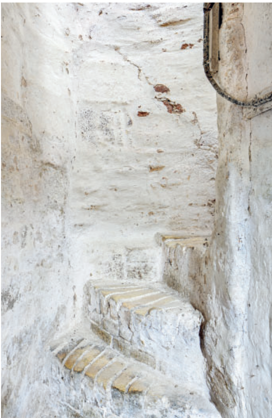
Fig. 20. Trappehusets indre (s. 6740). Foto Arnold Mikkelsen 2023. – Stairwell interior.
