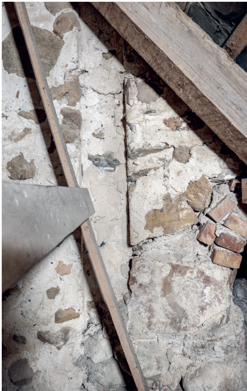
Fig. 44. Aftryk af lodret spærstiver i triumfgavlens østside (s. 6755). Foto Arnold Mikelsen 2023. – Imprint of vertical strut on the east side of the chancel arch gable.
