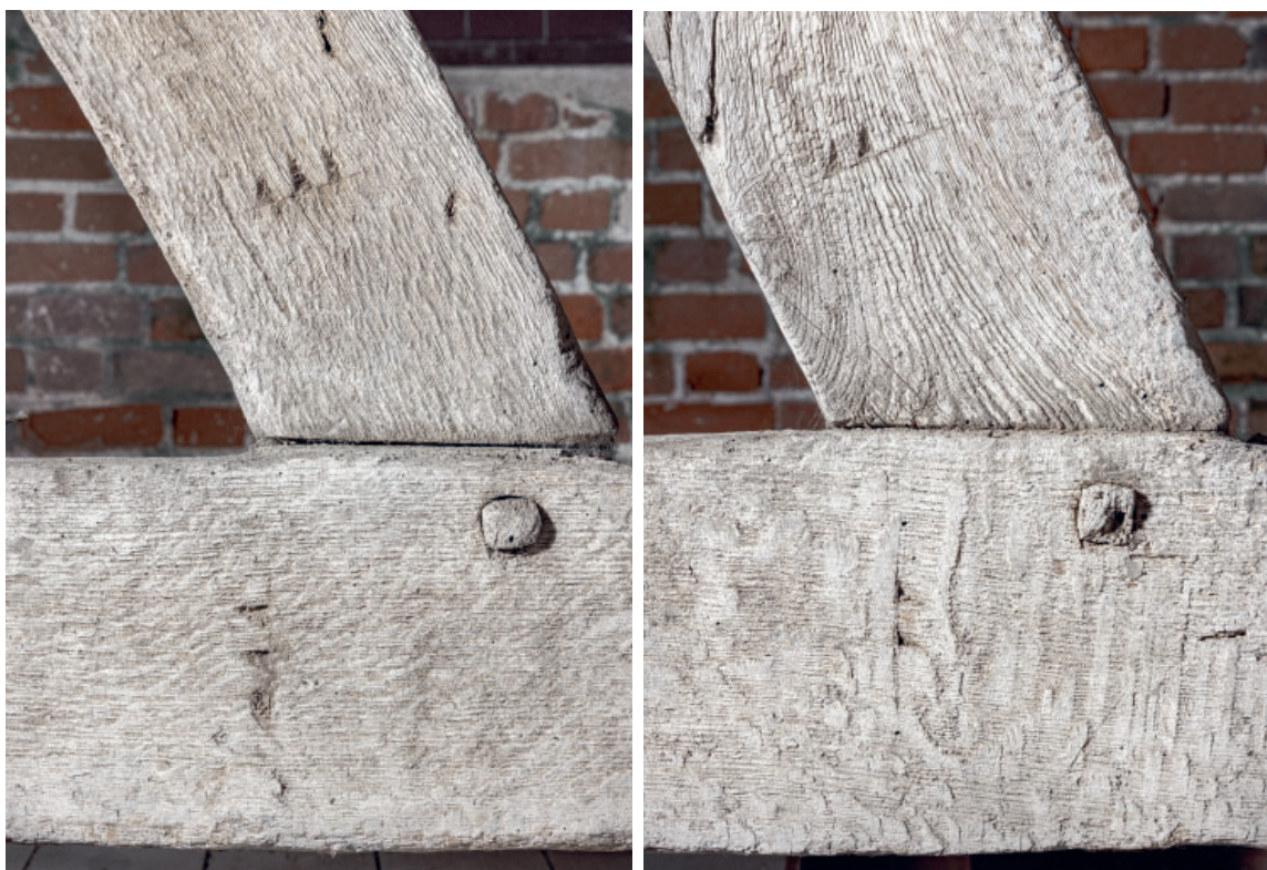
Fig. 48–49. Nummerering på klokkestolens østligste fags vestside (s. 6756 f.), søndre del. Foto Arnold Mikkelsen 2023. – Numbering on the west side of the easternmost bay of the bell frame, southern part.
