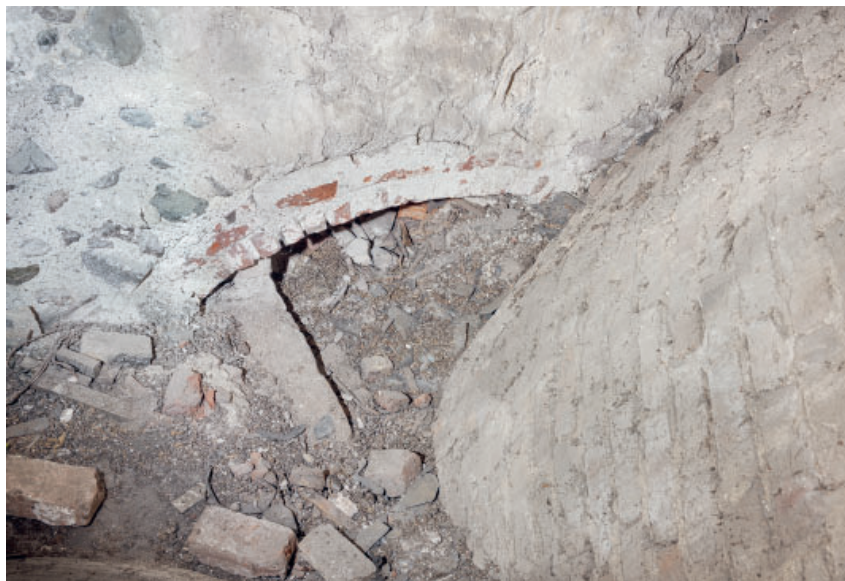
Fig. 106. †Romansk vindue i skibets syddside (s. 6734) samt lukkemur mod østhvæl-vets lomme (s. 6743). Foto Arnold Mikkelsen 2023. – †Romanesque window in the nave's south side, and closing wall in the space above the eastern vault.
