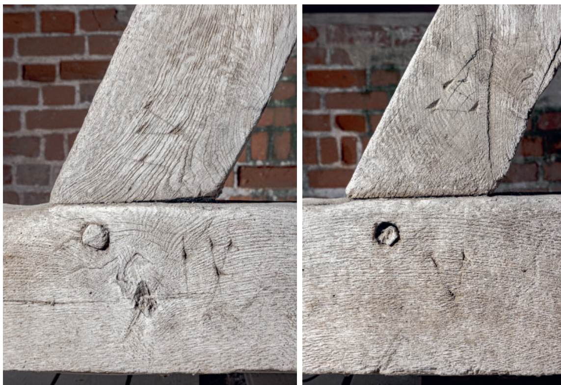
Fig.46–47. Nummerering på klokkestolens østligste fags vestside (s. 6756 f.), nordre del. Foto Arnold Mikkelsen 2023. – Numbering on the west side of the easternmost bay of the bell frame, northern part.
