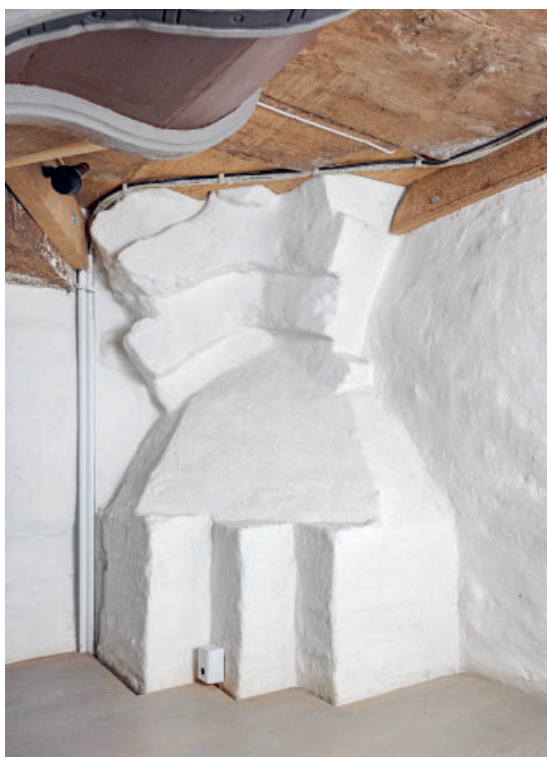
Fig. 116. Påbegyndt hjørnehvælpille? og trompe i skibets sydøsthjørne (s. 6743). Foto Arnold Mikkelsen 2023. — Partial corner vault pier and squinch in the nave's south east corner.
