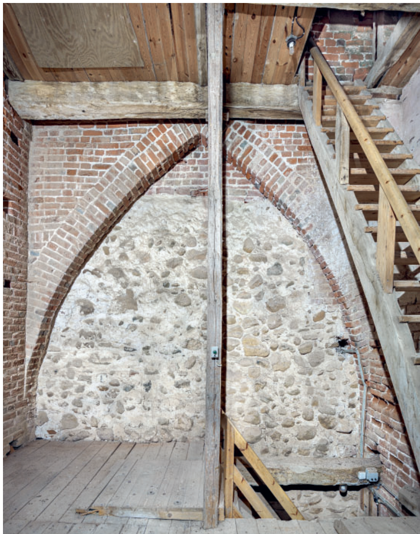
Fig. 13. Aflastningsbue i tårnets mellemstokværk (s. 6748) og skibets oprindelig vestgavl set mod øst (s. 6735). Foto Arnold Mikkelsen 2023. – Relieving arch on the tower's intermediate floor, and the nave's original west gable looking east.
