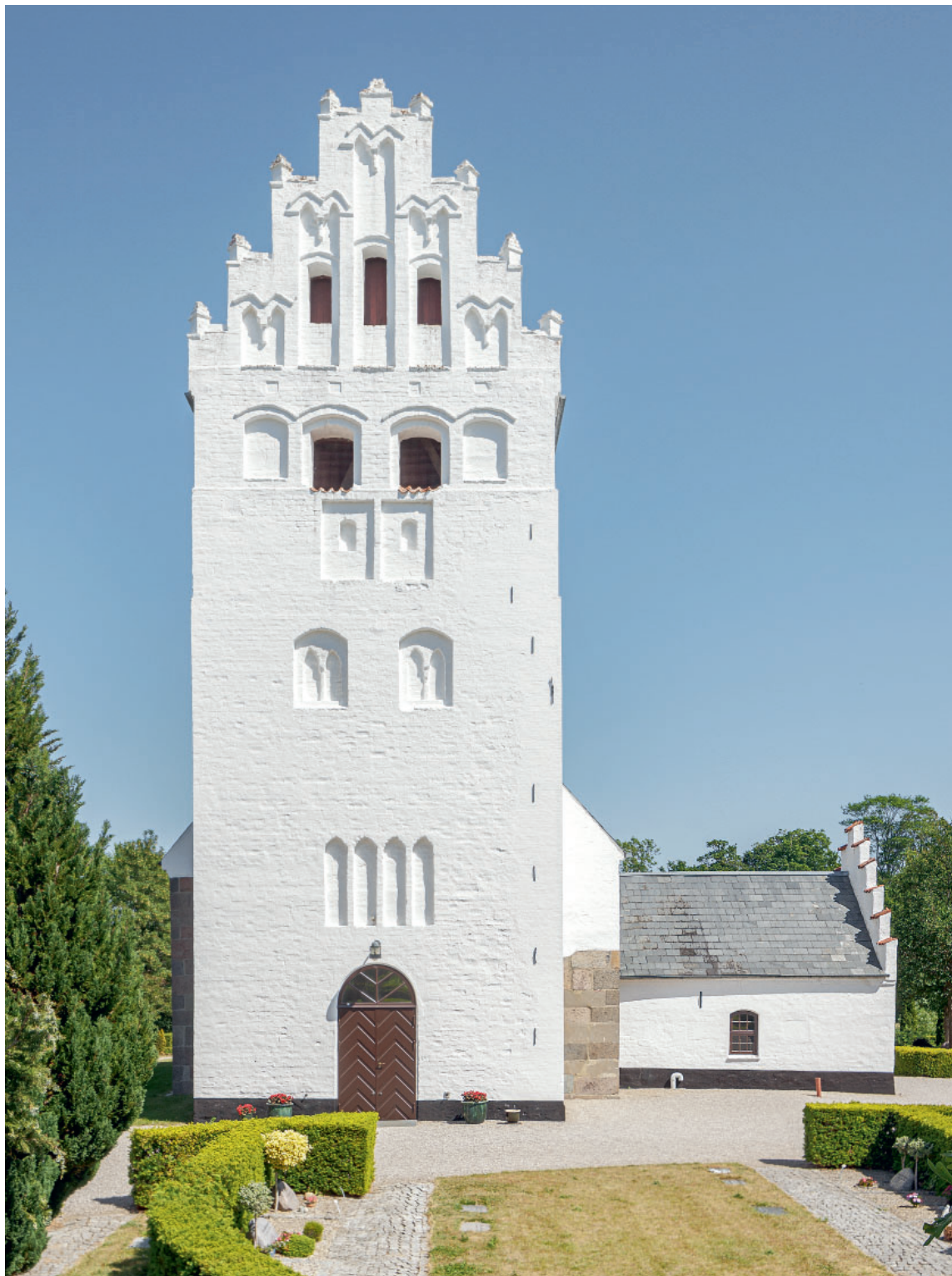
Fig. 15. Tårn (s. 6736 og 6747) og våbenhus (s. 6745) set fra vest. Foto Arnold Mikkelsen 2023. — Tower and porch seen from the west.
