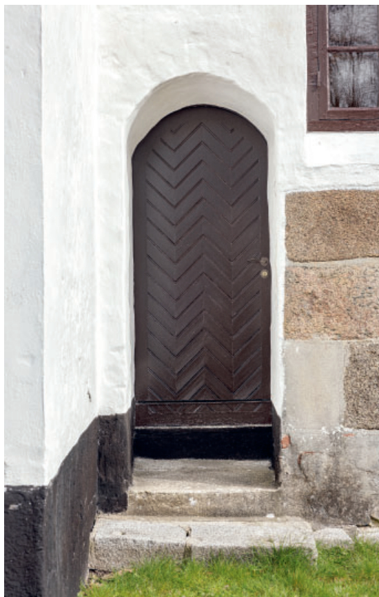
Fig. 38. Præstedør i korets sydside (s. 6741). Foto Arnold Mikkelsen 2023. – Priest's door in the south side of the chancel.
