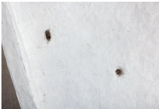
Fig. 99. Skibets østre hvælv med klokkerebshuller (s. 6847). Foto Arnold Mikkelsen 2024. – Eastern vault of the nave with holes for bell ropes.
