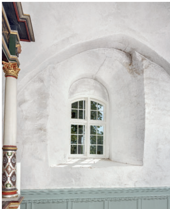
Fig. 33. Korets sydvindue (s. 6841), indre. Foto Arnold Mikkelsen 2024. – South window of the chancel, interior.
