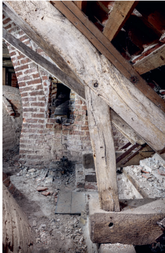
Fig. 43. Skibets andet spærfag fra vest, nordsiden, med nummerering (s. 6861) samt bue til tårnet (s. 6847). Foto Arnold Mikkelsen 2024. – The nave's second truss from the west with numbering, north side, and arch leading to the tower.
