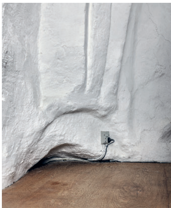
Fig. 23. Trompe i skibets sydøsthjørne (s. 6845, jf. fig. 50). Foto Arnold Mikkelsen 2024. – Squinch in the south east corner of the nave.
