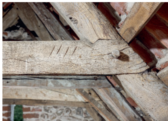
Fig. 37. Korets tagværk (s. 6860). Nummerering, 4. fag, i sydsiden, spær og hanebånd (s. 6860). Foto Arnold Mikkelsen 2024. – Chancel roofing. Numbering on the fourth truss, south side. Rafter and collar beam.
