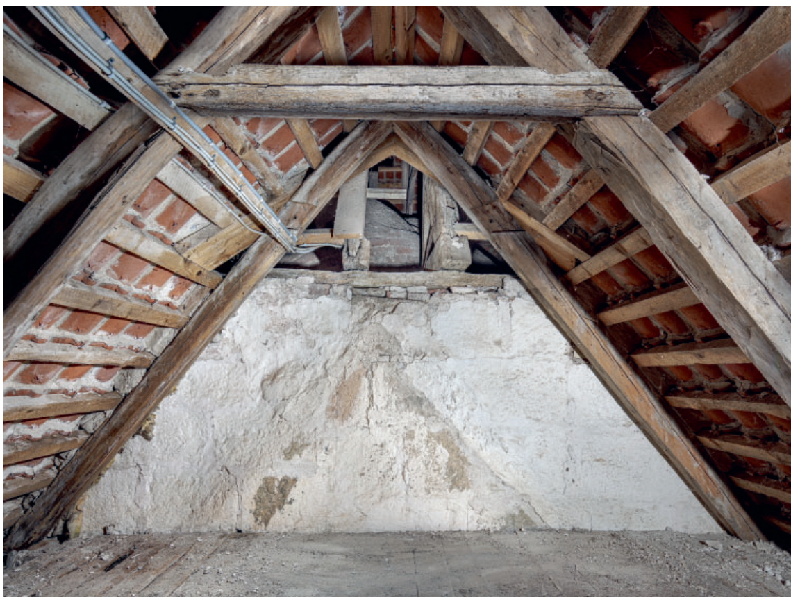
Fig. 19. Tagspor fra det middelalderlige våbenhustag (s. 6843). Foto Arnold Mikkelsen 2025. – Traces of the Medieval porch roof.
