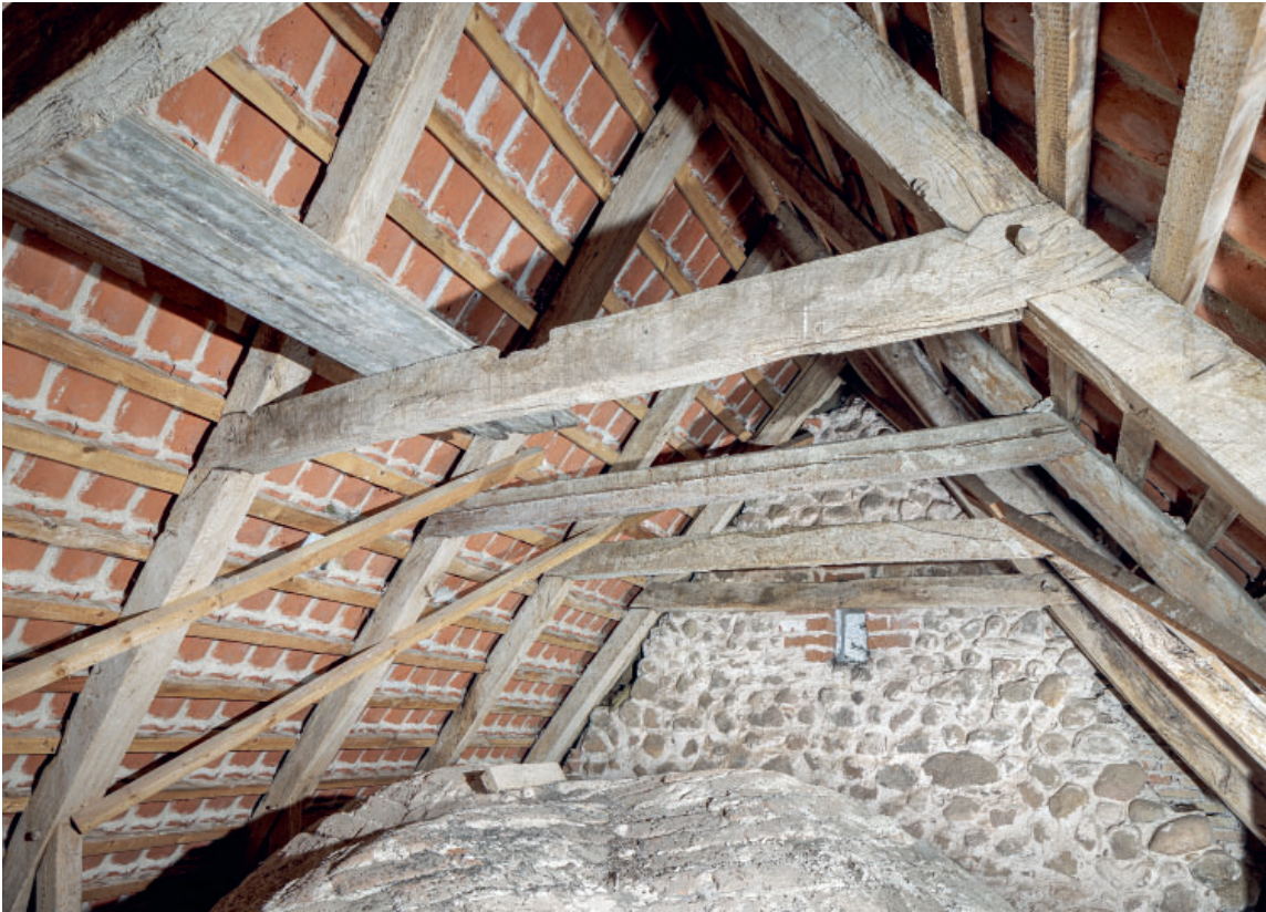
Fig. 36. Korets tagværk (s. 6860). Foto Arnold Mikkelsen 2024. – Chancel roofing.
