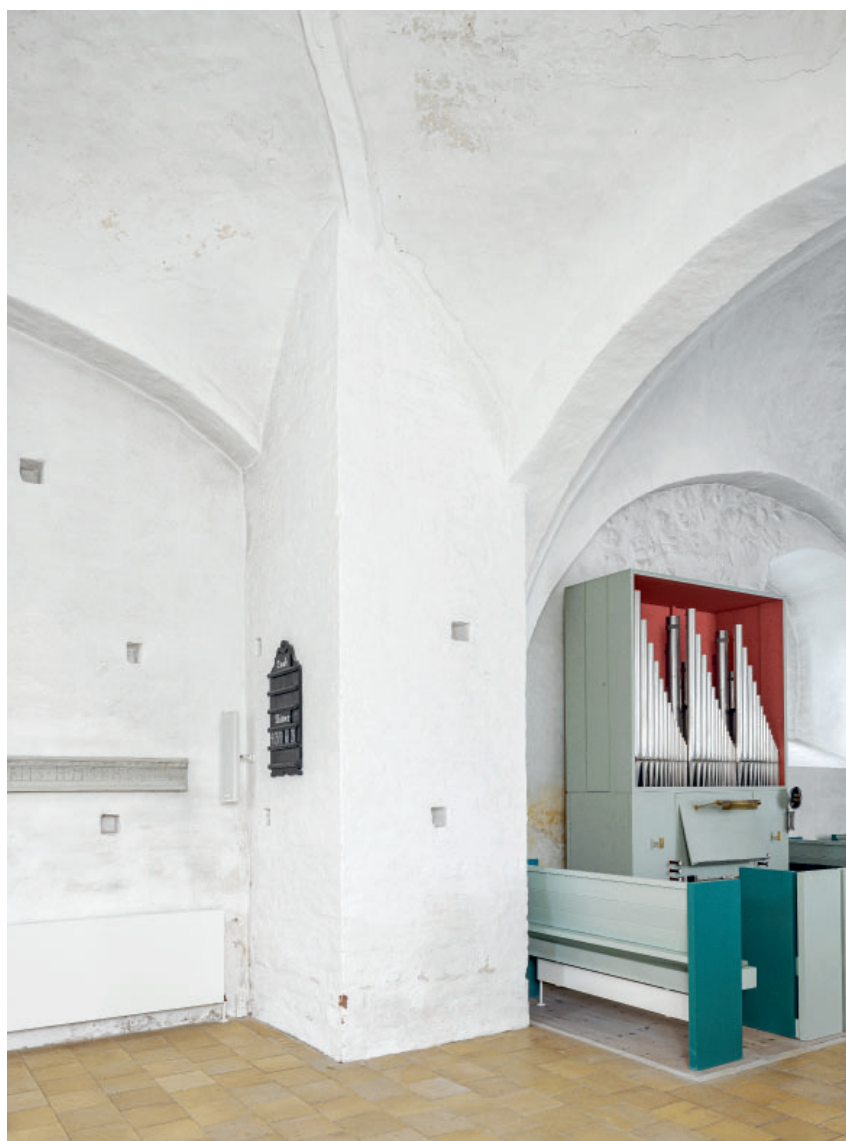
Fig. 28. Den nordre af de to piller i vestforlængelsen, der bærer tårnets østmur (s. 6847), set mod nordøst. Foto Arnold Mikkelsen 2024. — The western extension's northern pier bearing the east wall of the tower, looking north east.
