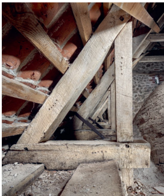
Fig. 38. Korets tagværk, spærstiver og spærfod, 5. fag fra øst i nord med nummerering (s. 6860). Foto Arnold Mikkelsen 2024. – Chancel roofing. Strut and strutting beam, north side of the fifth truss from the east with numbering.
