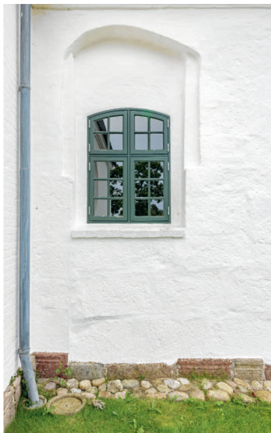
Fig. 12. Skibet romanske \uparrow norddør (s. 6841), yderside med senere vindue (s. 6858). Foto Arnold Mikkelsen 2025. – Romanesque north \uparrow door of the nave, exterior and a later window.
