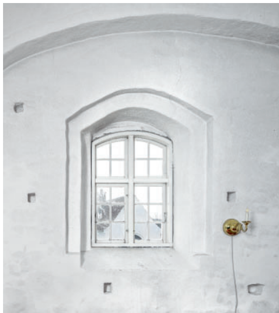
Fig. 97. Vestforlængelsens sydvindue (s. 6843). Foto Arnold Mikkelsen 2025. – South window of the western extension.
