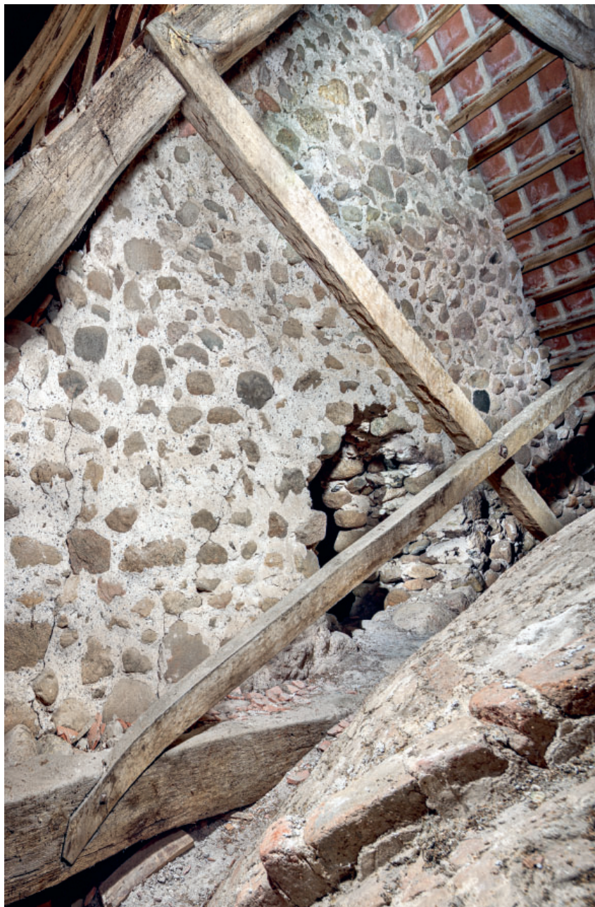
Fig. 42. Triumfgavlens vestside med gennembrudt åbning (s. 6841) samt skibets østligste krydsbånd (s. 6861). Foto Arnold Mikkelsen 2024. – West side of the chancel arch gable with an opening broken through, as well as the easternmost scissor truss of the nave.
