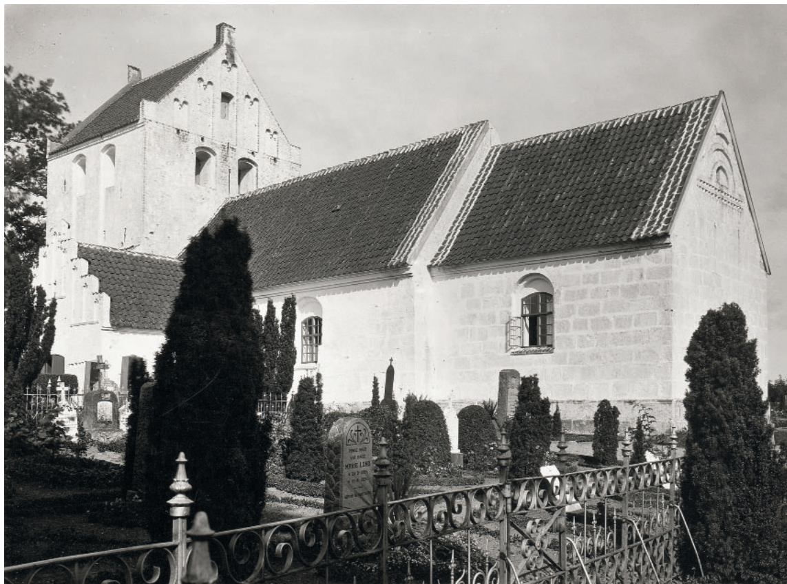
Fig. 45. Kirken set fra sydøst. Foto M. Mackeprang 1926. I NM. – The church seen from the south east.
