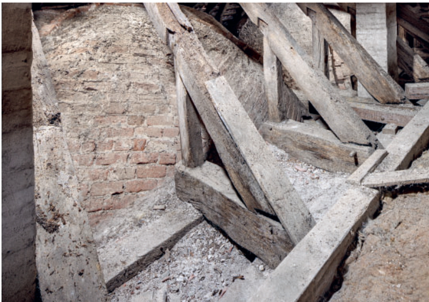
Fig. 44. Skibets tagværk. Spær i skibets nordside med blade til forsvundne spærstivere (s. 6861), set fra nordøst. Foto Arnold Mikkelsen 2024. – Nave roofing. Rafter in the north side of the nave with slots for missing struts, seen from the north east.
