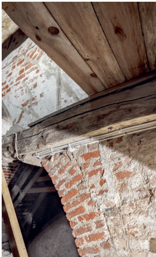
Fig. 31. Aflastningsbuer, der bærer tårnets østmur (s. 6847), set mod nordøst. Foto Arnold Mikkelsen 2025. – Relieving arches bearing the east wall of the tower looking north east.
