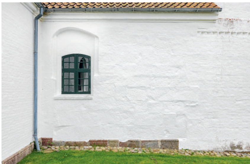
Fig. 98. Skibets nordside med romansk tårndør (s. 6841), senere vindue (s. 6858) samt overgang til vestforlængelse (s. 6843). Foto Arnold Mikkelsen 2024. – North side of the nave with Romanesque north door, later window, and transition to the western extension.
