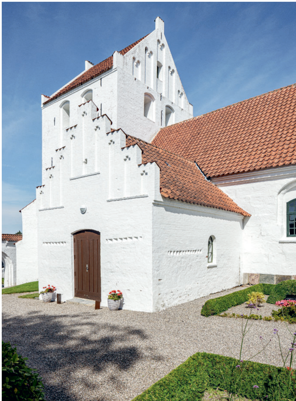
Fig. 27. Våbenhus (s. 6843) og tårn (s. 6847) set fra sydøst. Foto Arnold Mikkelsen 2024. — Porch and tower seen from the south east.
